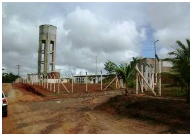
Figura 5.118 – Área da ETA do SIAA de Sauípe devidamente cercada
