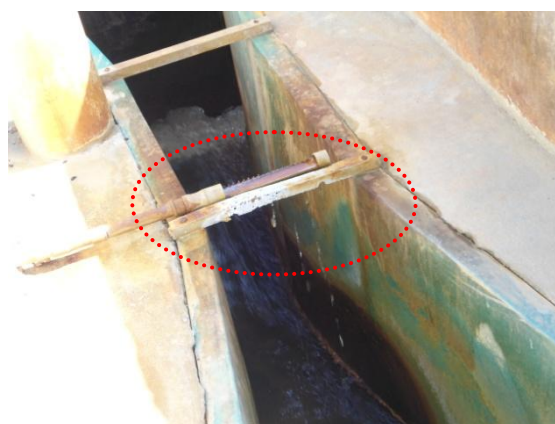
Figura 5.83 – Detalhe em vermelho - aplicação da solução de sulfato de alumínio
