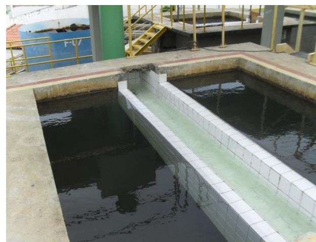
Figura 5.33 - Coleta de água clarificada nos dois tipos de filtros existentes na ETA de Barra do Pojuca.
