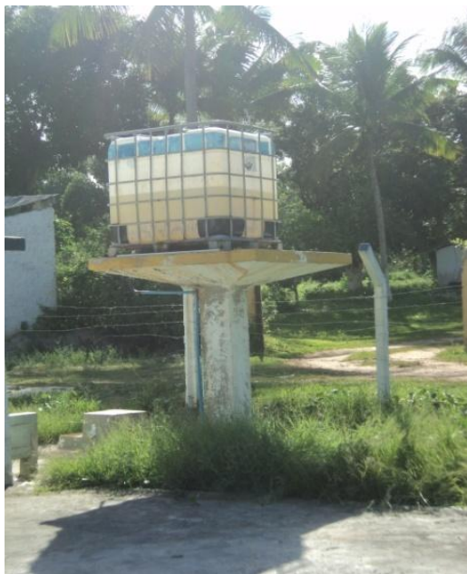
Figura 5.132 – Bombona de ácido fluossilícico concentrado, situada fora da Casa de Química
