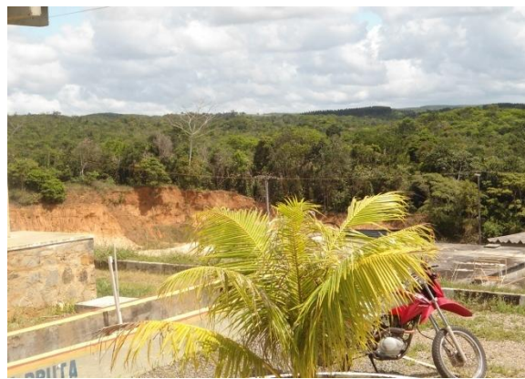
Figura 5.119 – Vista geral do talude e patamar situados ao fundo da área da ETA, que deveriam ter sido objeto de recomposição paisagística durante a implantação das obras
