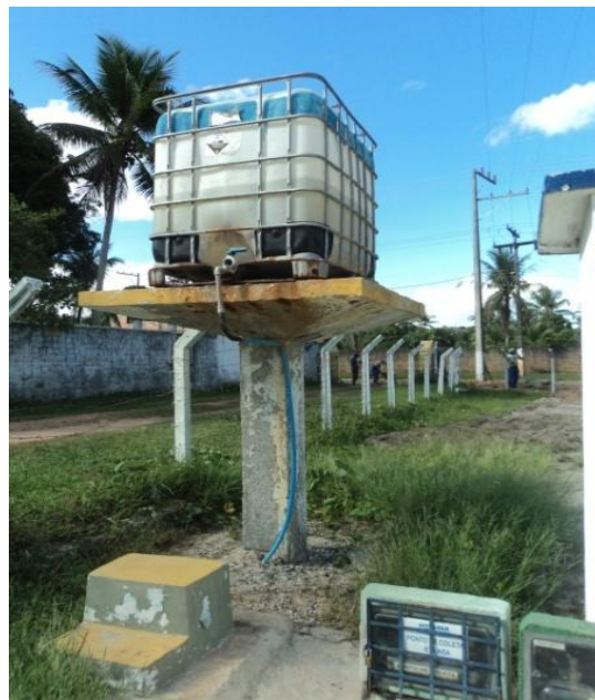
Figura 5.132 – Bombona de ácido fluossilícico concentrado, situada fora da Casa de Química
