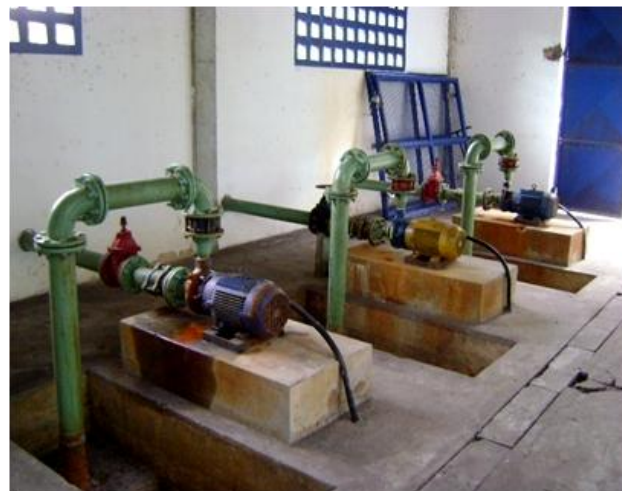
Figura 5.68 - Conjuntos secundários da EEAT2 (desativados)
