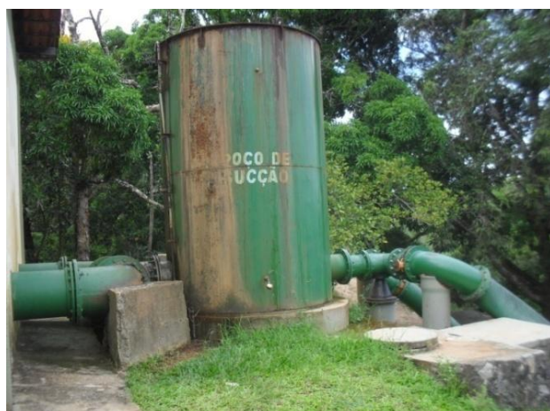
Figura 5.17 - Antigo poço de sucção da EEAB2
