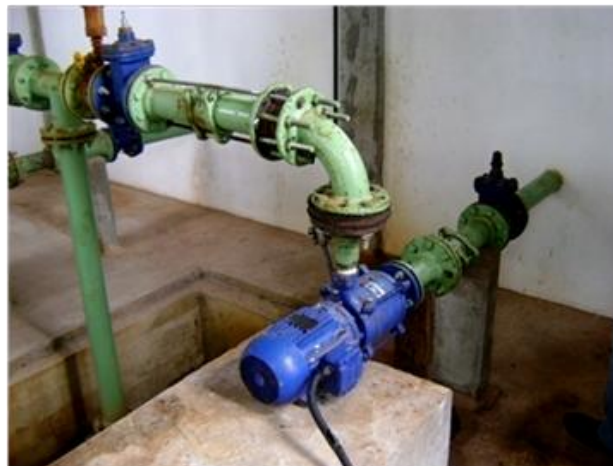
Figura 5.73 - Detalhe dos conjuntos motobomba que compõem a EEAT4
