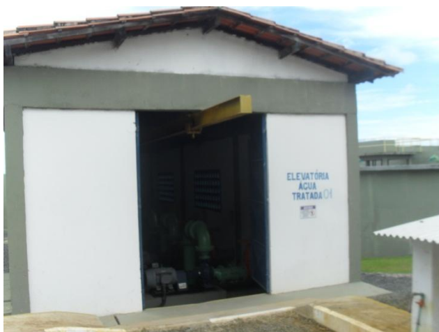
Figura 5.57 - Vista externa da EEAT1N
