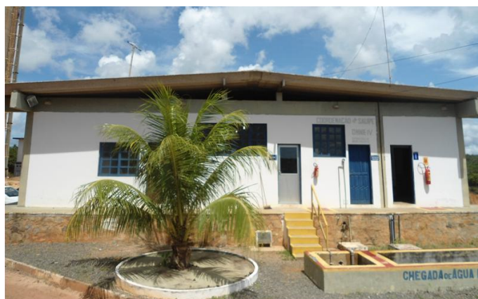
Figura 5.88 – Vista geral externa da Casa de Química
