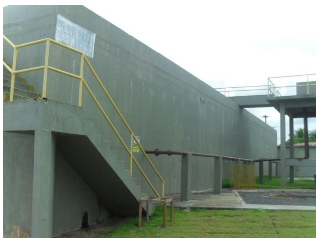
Figura 5.49- Adensadores de lodo
