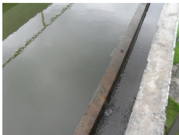
Figura 5.54 - Coleta do efluente sobrenadante dos adensadores de lodo
