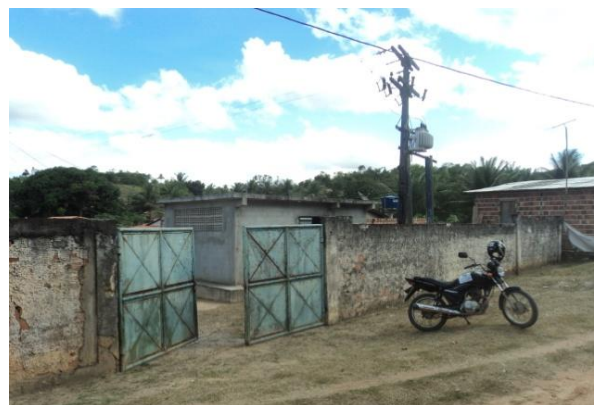
Figura 5.4 – Vista geral das instalações da EEB8
