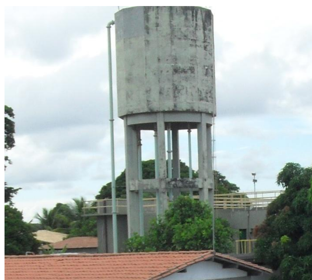
Figura 5.35 - REL de 150 m³ (Lavagem dos Filtros)
