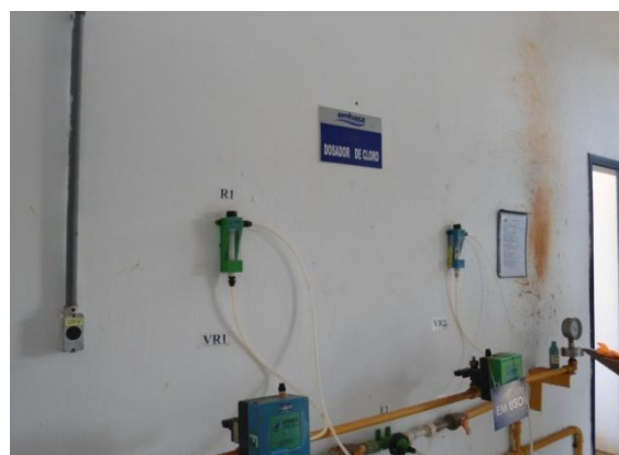
Figura 5.102 – Sala dos dosadores de cloro gás
