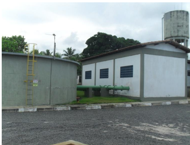
Figura 5.59 - Vista geral da EEAT1N, implantada junto ao RAP de 400 m 3 (poço de sucção).
