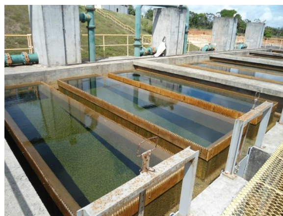
Figura 5.85 – Vista parcial da parte superior dos filtros
