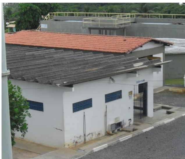
Figura 5.36 - Vista geral da edificação que abriga as Casas de Química e de Cloração
