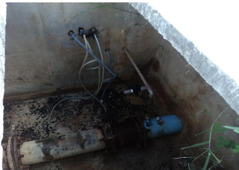
Figura 5.137 – Aplicação dos produtos químicos na tubulação adutora de água bruta, na área da ETA do SAA Amado Bahia
