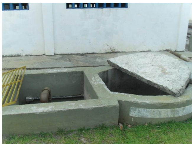
Figura 5.51- Poço de sucção da Estação Elevatória de Efluentes 4 (EEE4)
