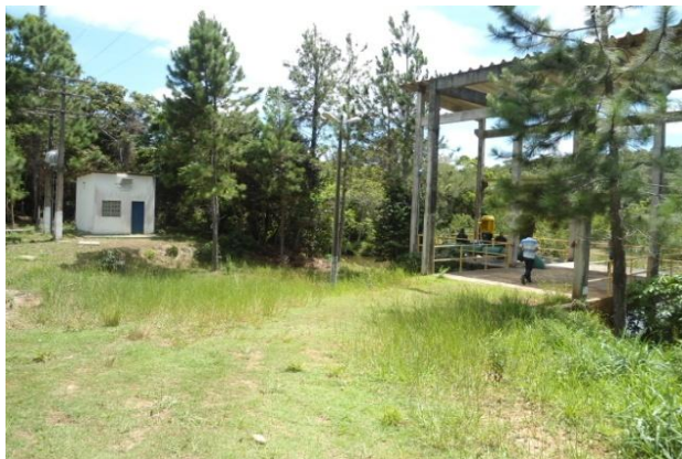
Figura 5.75 – Vista parcial da área onde está instalada a EEB1
