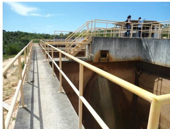
Figura 5.111 – Reservatórios que se destinariam a receber a água de lavagem dos filtros
