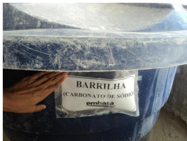
Figura 5.134 – Reservatório de polietileno, onde é preparada a solução de carbonato de sódio, barrilha
