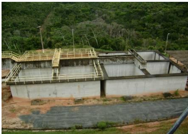
Figura 5.111 – Reservatórios que se destinariam a receber a água de lavagem dos filtros
