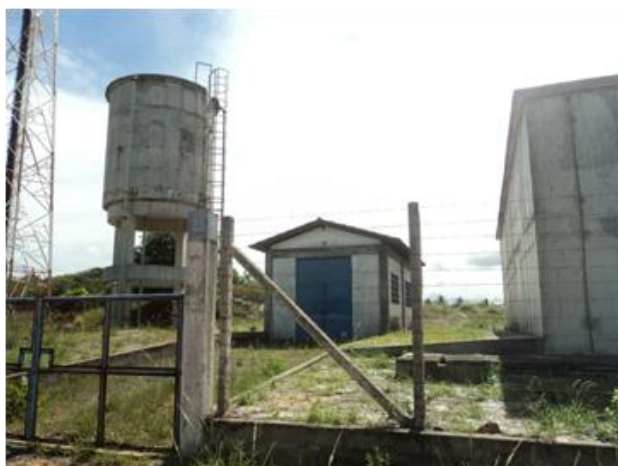
Figura 5.71- Vista geral da área onde está instalada a EEAT4
