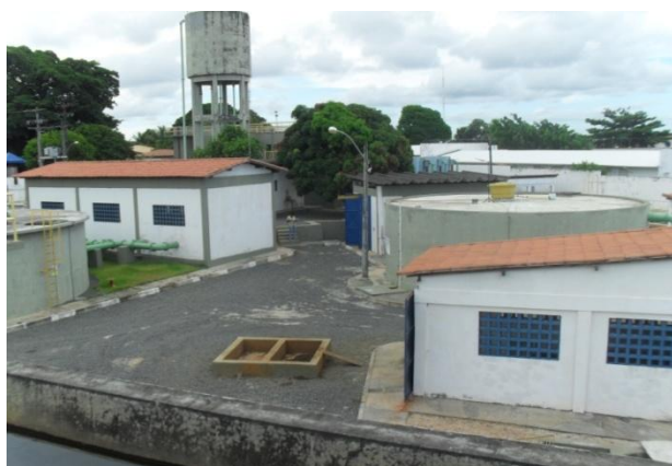
Figura 5.21 - Vista geral da ETA de Barra do Pojuca
