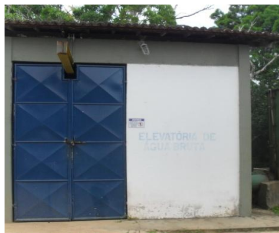
Figura 5.18 - Área externa da casa de bombas da EEAB2
