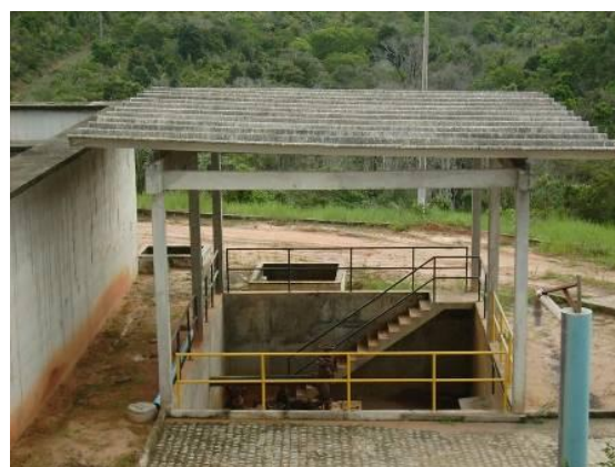
Figura 5.113 – Vista geral da casa de bombas da estação elevatória dos efluentes de lavagem dos filtros (EEEL)
