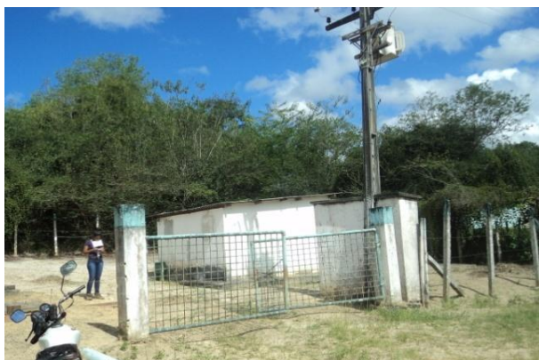
Figura 5.3 – Vista geral das instalações da EEB6
