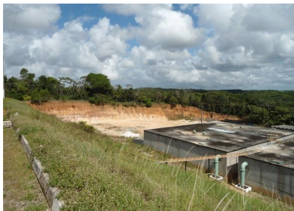
Figura 5.119 – Vista geral do talude e patamar situados ao fundo da área da ETA, que deveriam ter sido objeto de recomposição paisagística durante a implantação das obras
