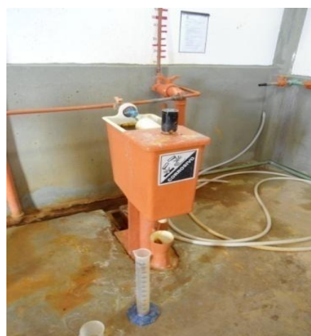
Figura 5.94 – Detalhe de um dos dosadores de nível constante
