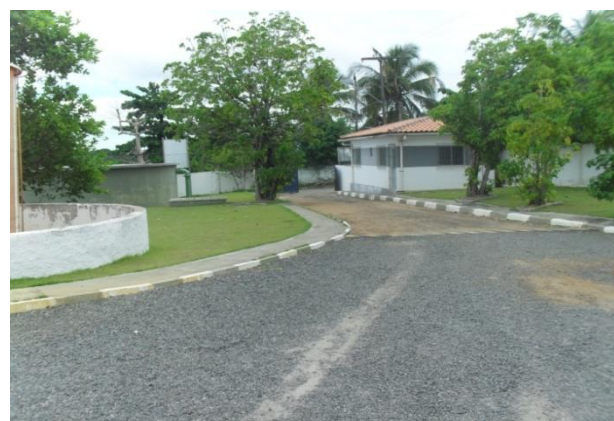
Figura 5.22 - Entrada da ETA de Barra do Pojuca
