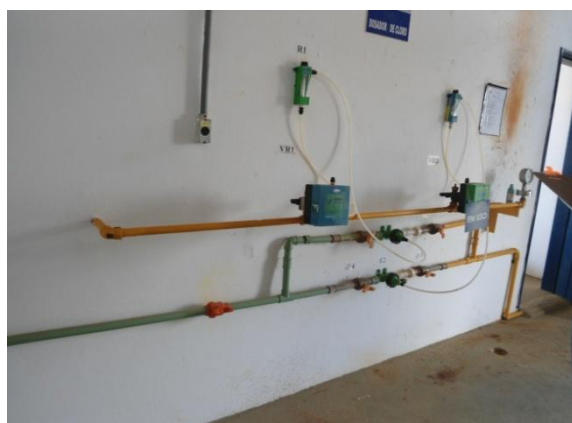
Figura 5.102 – Sala dos dosadores de cloro gás
