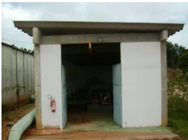
Figura 5.120 – Vista externa da casa de bombas da EET1
