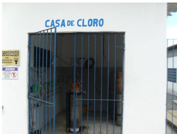
Figura 5.44 – Vista externa da Casa de Cloração
