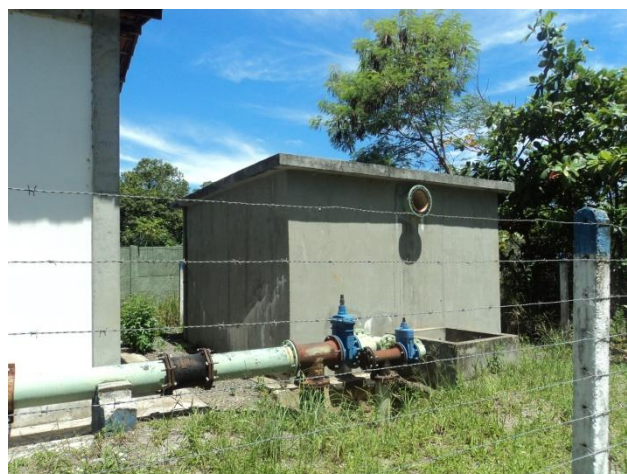
Figura 5.66 - Poço de sucção de 35 m 3 ("by passado")
