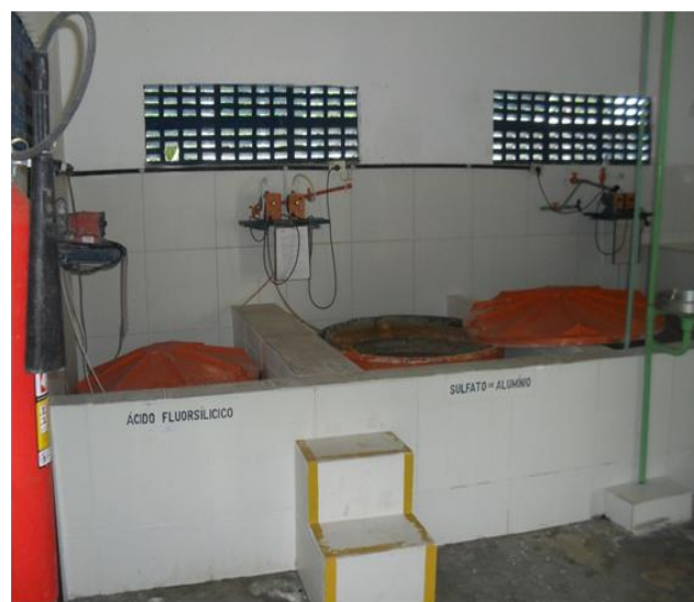
Figura 5.37 - Interior da Casa de Química
