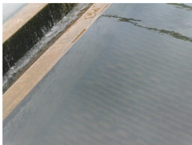
Figura 5.30 - Coleta da água decantada
