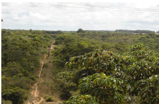
Figura 5.77 – Caminhamento da adutora de água bruta
