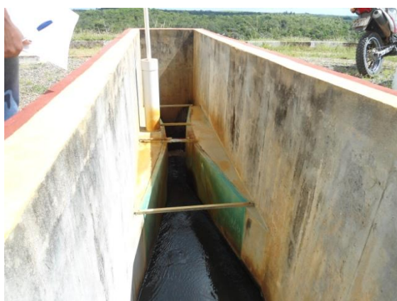
Figura 5.82 – Misturador rápido, Calha Parshall
