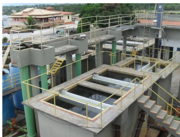
Figura 5.32 - Filtros russos de seção quadrada (em concreto)
