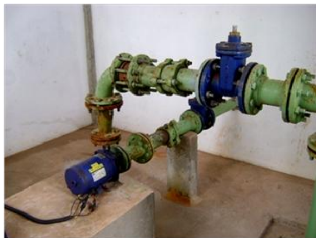
Figura 5.73 - Detalhe dos conjuntos motobomba que compõem a EEAT4
