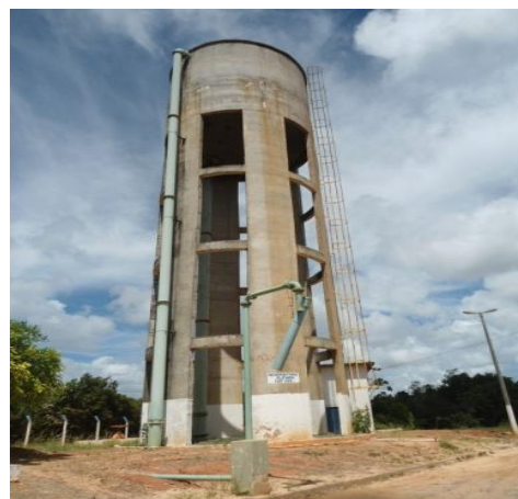
Figura 5.110 – Vista geral do REL de 200 m³
