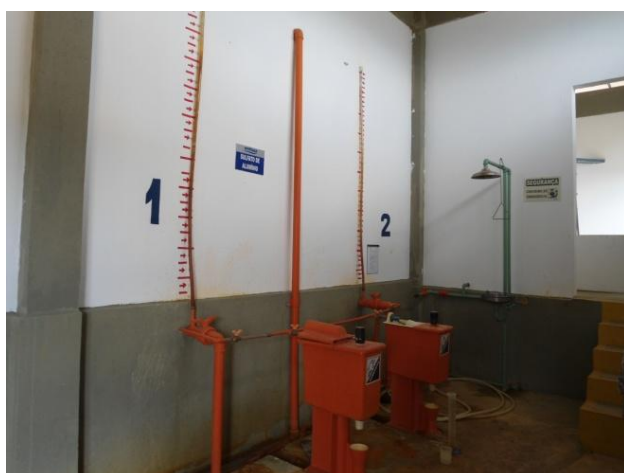
Figura 5.93 – Dosadores de nível constante
