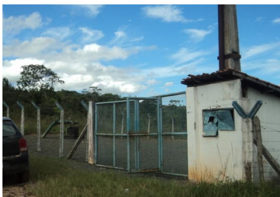
Figura 5.5 – Vista geral das instalações da EEB9
