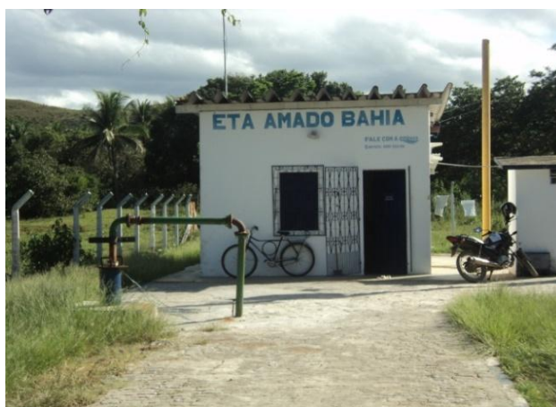
Figura 5.130 – Vista geral da ETA do SAA de Amado Bahia
