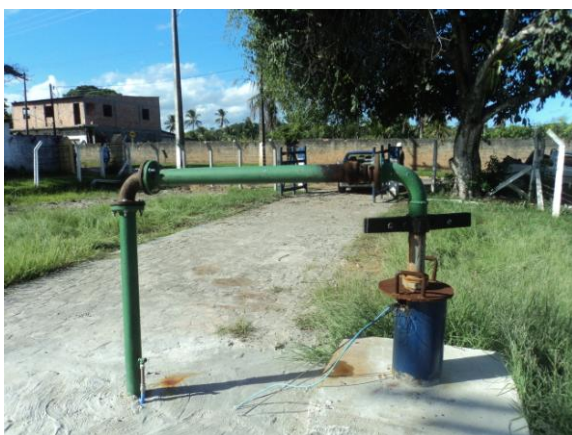
Figura 3.14 – Poço CSB2 – Vista geral do poço
