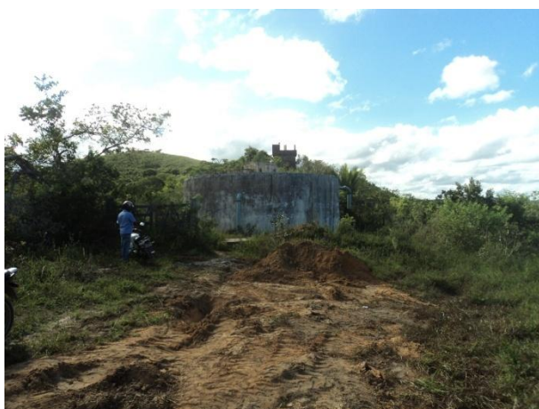
Figura 3.20 – Vista do centro de reservação de Amado Bahia
