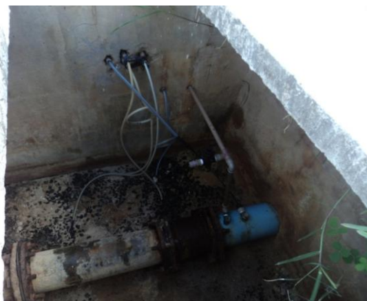
Figura 3. 19 - Aplicação dos produtos químicos na área da ETA
