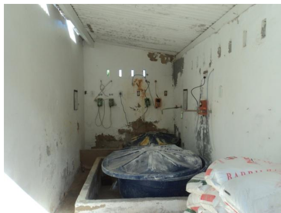
Figura 3. 18 - Interior da casa de química
