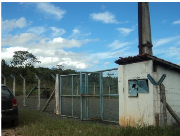
Figura 3.4 - Poço CSB9N – Vista geral das instalações
