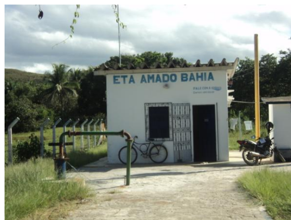
Figura 3.15 – Poço CSB2 – Local de Instalação
