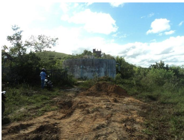
Figura 2.8 – Vista do centro de reservação de Amado Bahia
