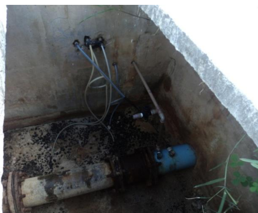
Figura 2.6 - Aplicação dos produtos na área da ETA
