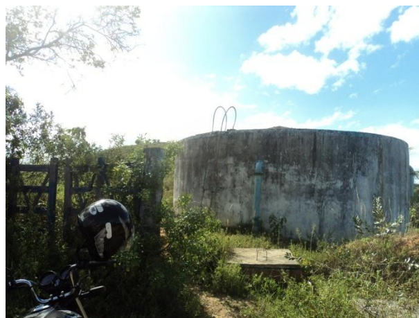
Figura 2.9 – Vista do reservatório apoiado de 200 m³
