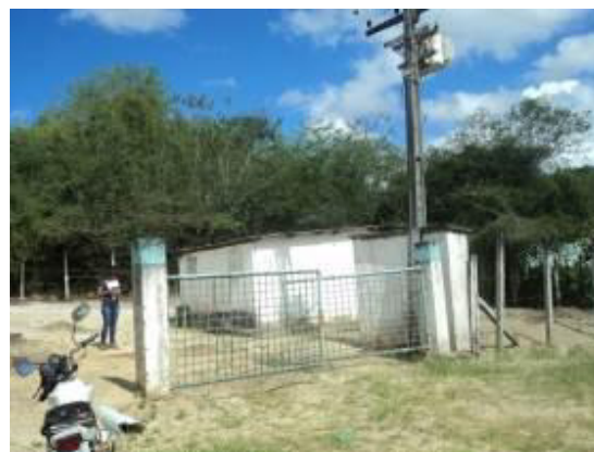
Figura 4.8 - Poço CSB6N - Vista geral das instalações
