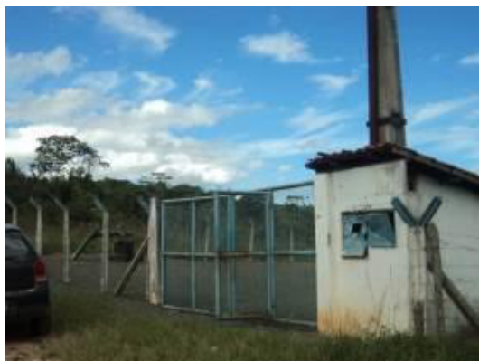
Figura 4.13 - Poço CSB9N – Vista geral das instalações
