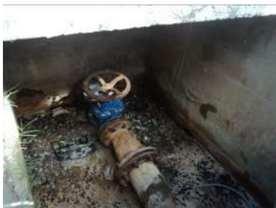
Figura 4.120 - Poço CSB2 – Caixa de registro
