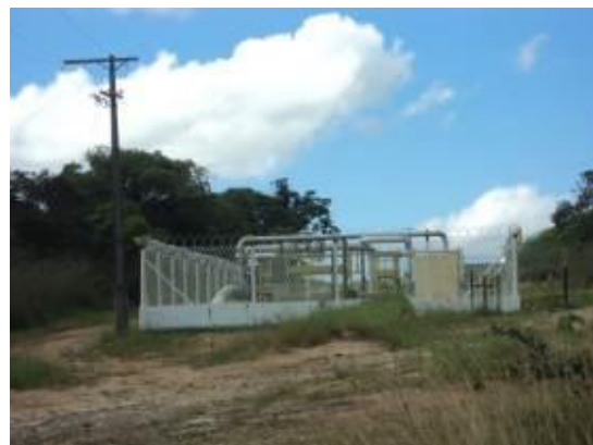
Figura 4.16 - Poço CSB9N – Tubulações condutoras de gás da PETROBRÁS próximas ao poço
