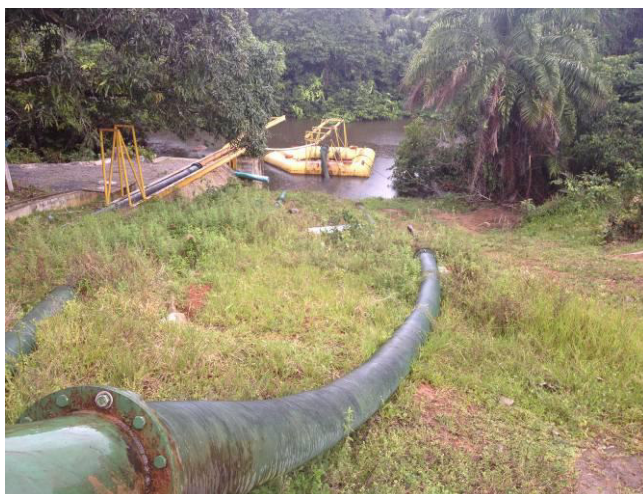
Figura 4.70 - Vista geral da área da captação SIAA Barra do Pojuca
