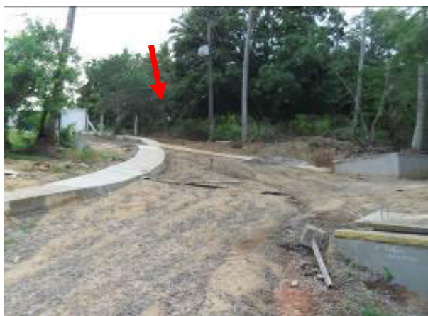
Figura 4.72 - Cerca danificada (detalhe em vermelho)
