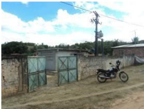
Figura 4.9 - Poço CSB8N – Vista geral das instalações
