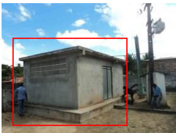
Figura 4.11 - Poço CSB8N – Unidade de tratamento (detalhe em vermelho), no próprio local da instalação
