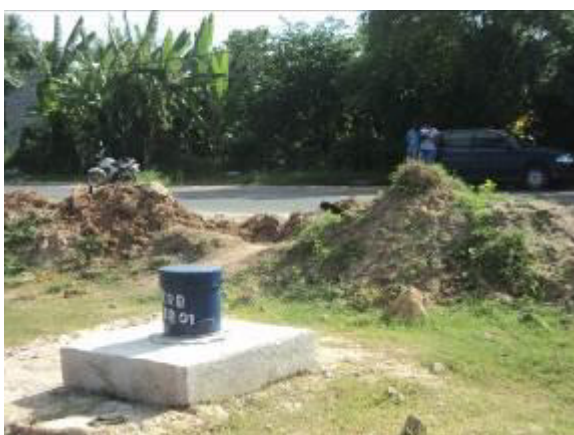
Figura 4.116 - Poço novo – Local da perfuração
