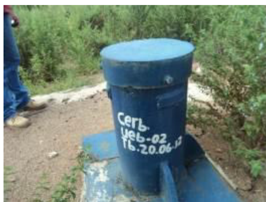
Figura 4.20 - Poço novo, perfurado pela CERB
