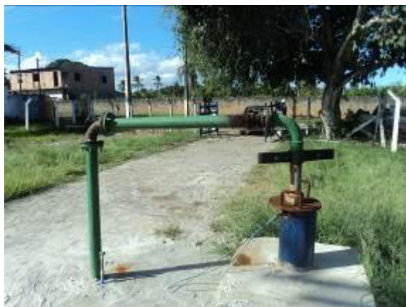
Figura 4.114 - Poço CSB2 – Vista geral do poço
