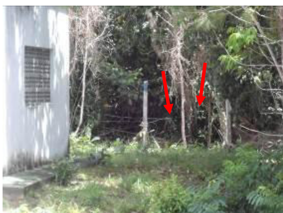
Figura 4.111 - Local da cerca (detalhe em vermelho) que permite o acesso de pessoas não autorizadas
