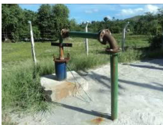
Figura 4.122 - Poço CSB2 – Vista do barrilete de recalque
