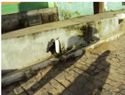
Figura 50 – Ligações prediais de esgoto, (a) inexistência de caixa de limpeza e (b) desenho esquemático da caixa
