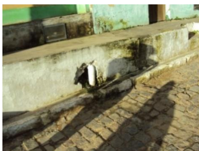
Figura 48 – Ligações prediais de esgoto, (a) inexistência de caixa de limpeza e (b) desenho esquemático da caixa
