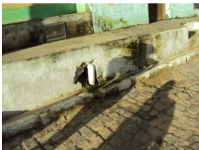
Figura 46 - Ligações prediais de esgoto, (a) inexistência de caixa de limpeza e (b) desenho esquemático da caixa
