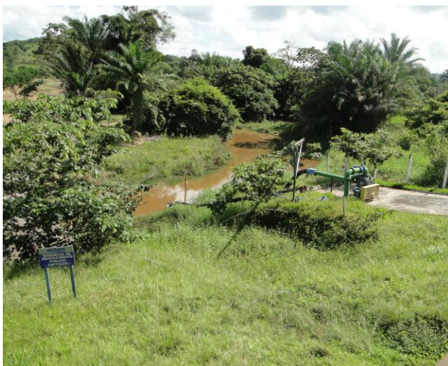
Figura 5.41 - Vista geral da área da captação do SAA de Pojuca
