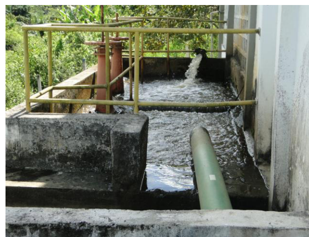
Figura 5.44 –Chegada no poço de sucção da EEAB2
