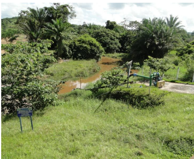
Figura 6.3 - Vista geral da área da captação do SAA de Pojuca
