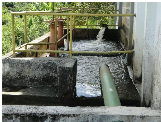
Figura 6.8 - Chegada no poço de sucção da EEAB2
