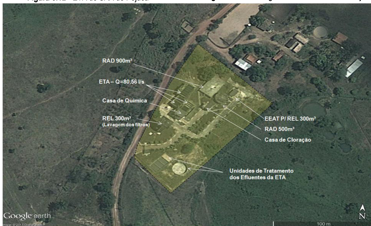
Figura 6.14 – Área da ETA do SAA de Pojuca.
