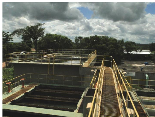
Figura 6.13 - Vista geral da ETA do SAA de Pojuca
