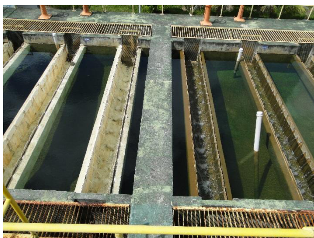
Figura 6.18 - Coleta do efluente filtrado
