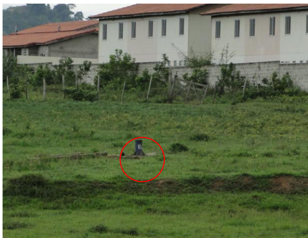
Figura 6.14 - Poço CSB17 – Poço novo; ausência de proteção
