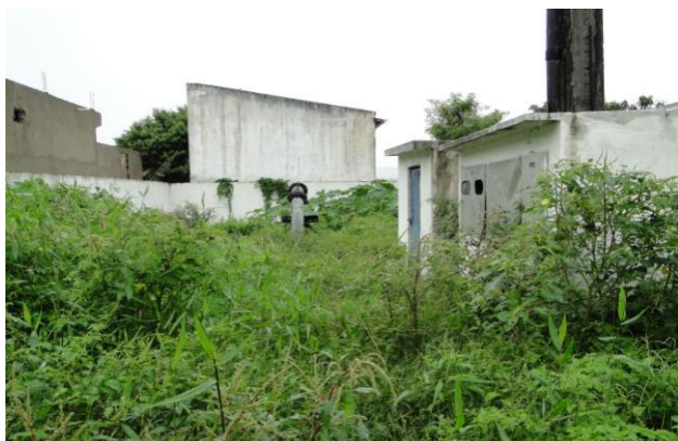
Figura 6.10 - Poço CSB14 – Local da Instalação; falta de roçagem e conservação do local
