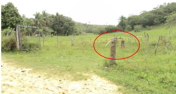
Figura 6.16 - Poço CSB1 – Local da Instalação; falta de portão e conservação do local.
