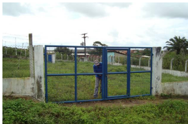
Figura 6.11 - Poço CSB15 – Vista geral da instalação. Proteção com cerca; faltam identificação e sinalização de acesso restrito
