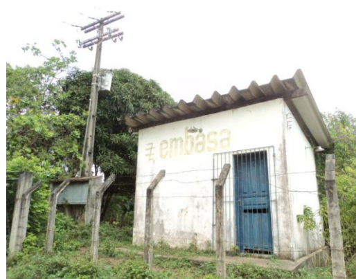
Figura 6.23 - Poço CSB1 – Local do quadro de comando.
