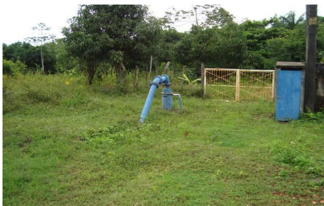
Figura 6.6 - Poço CSB12 – Vista geral da instalação
