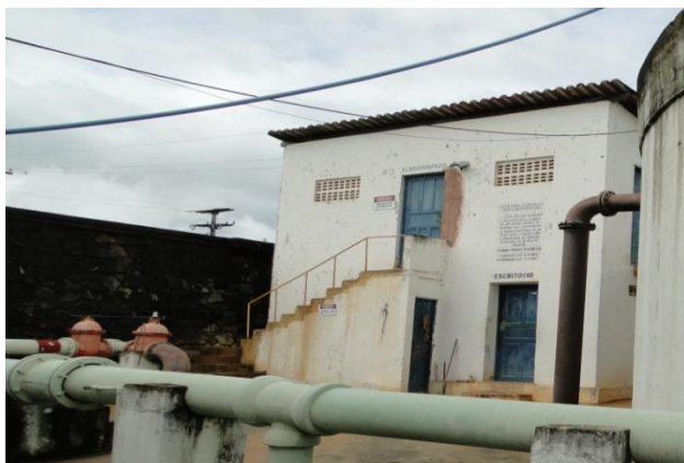
Figura 7.11 - Casa de química / Laboratório - armazenagem, dosagem e preparo.
