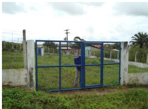
Figura 7.6 - Vista geral das instalações da EEB15.
