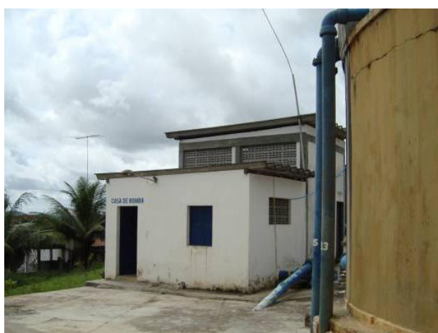
Figura 7.17 – EET1 – Vista da Casa de Bombas
