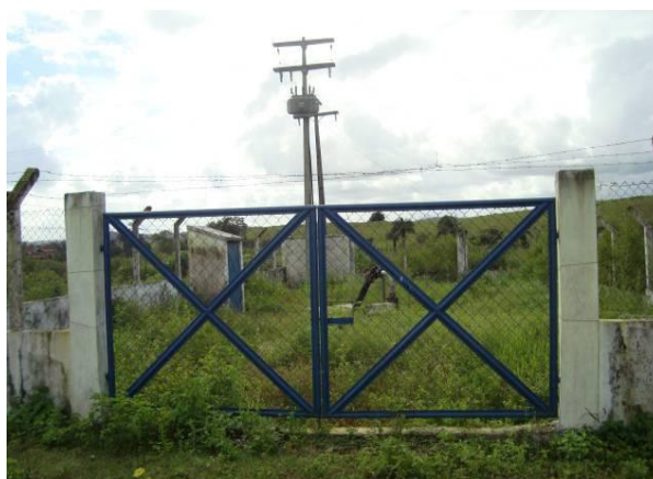
Figura 7.7 - Vista geral das instalações da EEB16.
