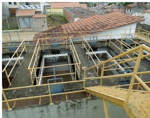
Figura 7.16 - Vista dos Filtros Russos – (fora de operação).
