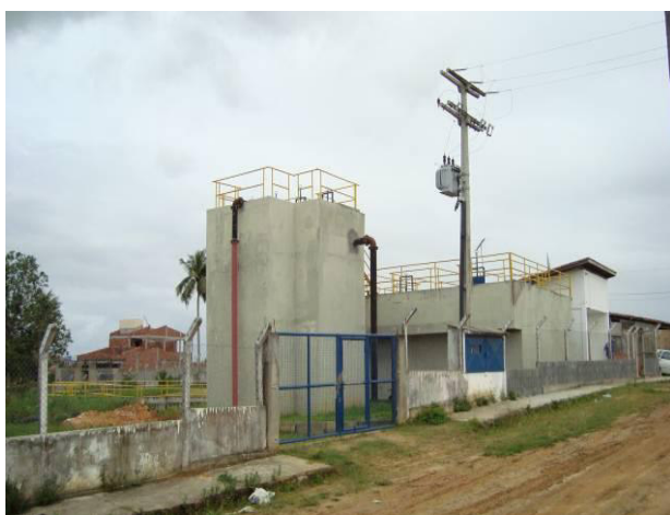
Figura 7.13 - Vista geral da área da ETA (Tipo filtro russo).
