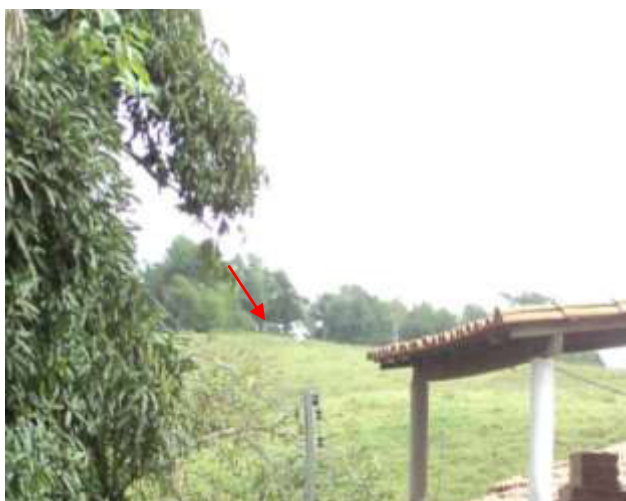
Figura 8.13 - Vista do local do Reservatório de Santo André.
