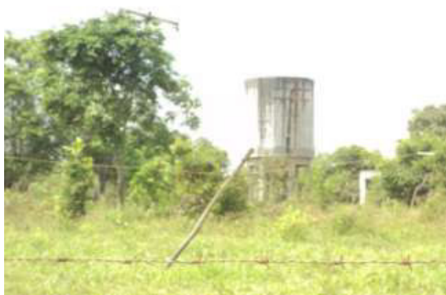
Figura 8.11 - Vista do Reservatório de Jacuípe – Cap. 100m 3 .
