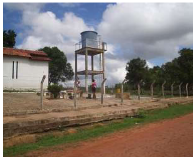
Figura 8.14 - Reservatório de Gari – Tanque em Fibra de 10m³
