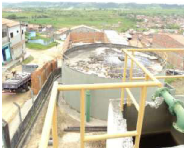
Figura 8.7 - Vista do Reservatório apoiado 500m³.
