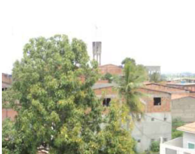
Figura 8.6 - Vista do RED de 50 m³.
