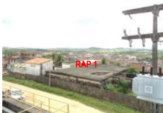
Figura 8.3 - Vista do reservatório apoiado – RAP1.
