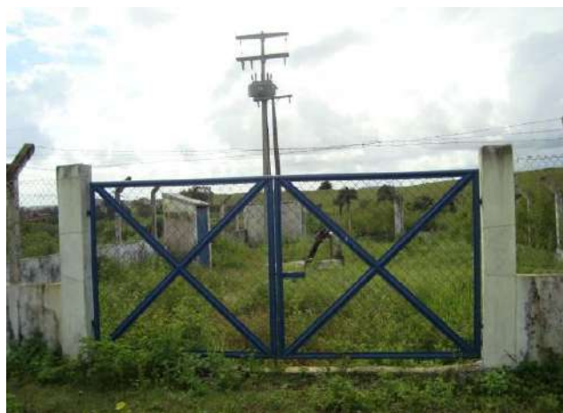
Vista Geral das instalações da EEB16
