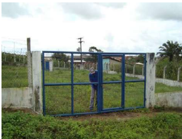
Vista Geral das instalações da EEB15
