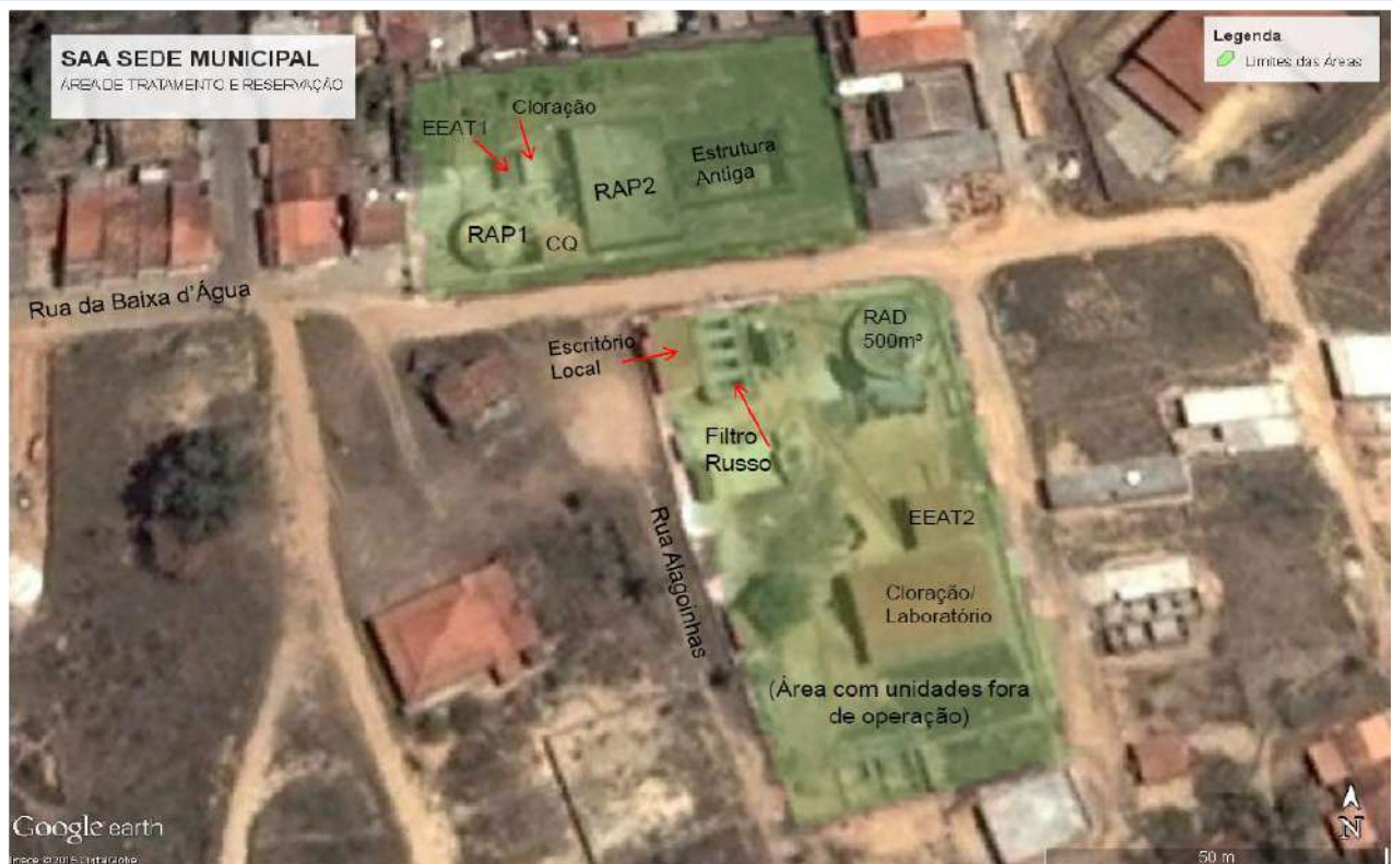
Figura 3.3 - Área de Tratamento e Reservação do SAA Sede Municipal Fonte: Google Earth Pro
