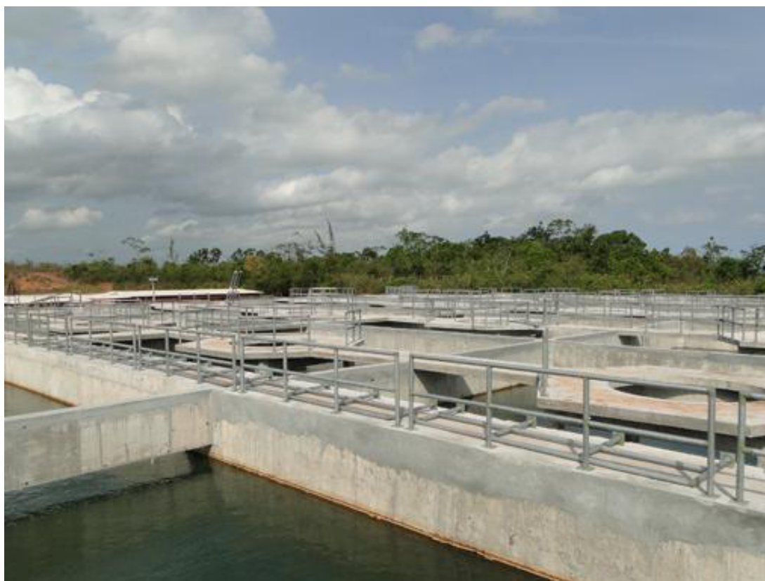
Figura 1. 22 - Ampliação da ETA Principal
