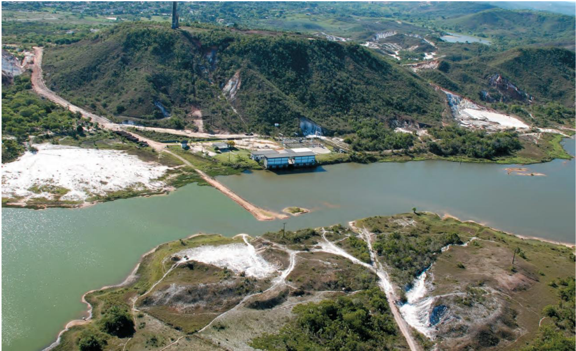
Figura 1. 7- Vista panorâmica da captação/elevatória de Santa Helena (também conhecida como elevatória do Jacumirim)
