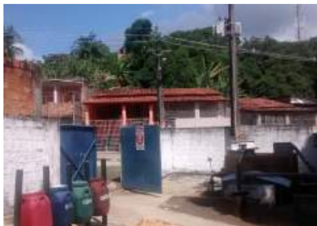
Figura 1. 74 - ETA de Bom Jesus dos Pobres, onde está localizado o Poço 1 (em destaque). Verifica-se boa conservação e proteção do local.
