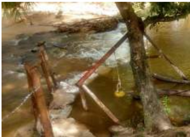
Figura 1. 85 - Ponto de captação no rio Irauá. Evidencia-se a estrutura de sustentação da bomba e pequena barragem.
