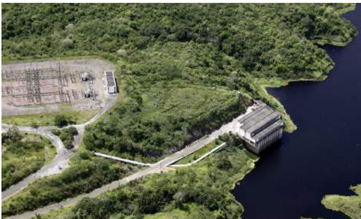
Figura 1. 24 - Vista Aérea da Captação / Estação Elevatória do SIAA de Salvador em Pedra do Cavalo
