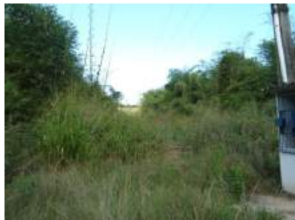
Figura 1. 26 - Área da captação do SAA de São Brás - sem barreiras físicas
