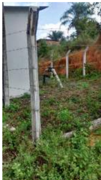
Figura 1. 71 - Poço 2 (Cabuçu). Não foi possível o acesso da equipe para verificação de suas condições
