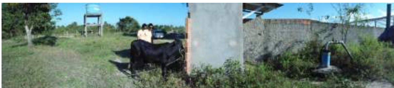
Figura 1. 59 - Poço P02 – Vista geral do local da instalação, presença de animais
