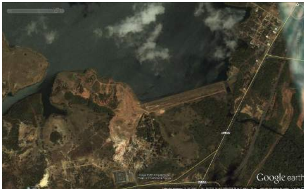
Figura 1. 15 - Vista Geral da Barragem Joanes II
