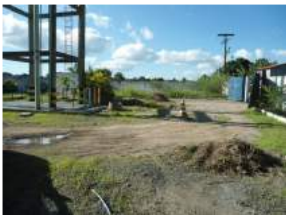
Figura 1. 55 - Poço P01 - Vista geral do local da instalação
