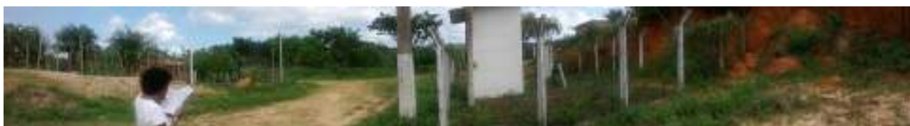
Figura 1. 72 - Área do entorno do Poço 2 (Cabuçu). Existem algumas moradias próximas ao local da captação.
