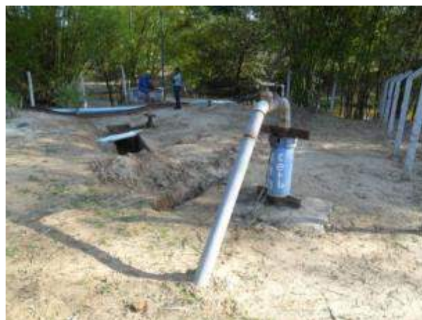
Figura 1. 65 - Área do Poço 1 (Saubara), devidamente cercada e afastada do centro urbano de Saubara (EMBASA, 2011)
