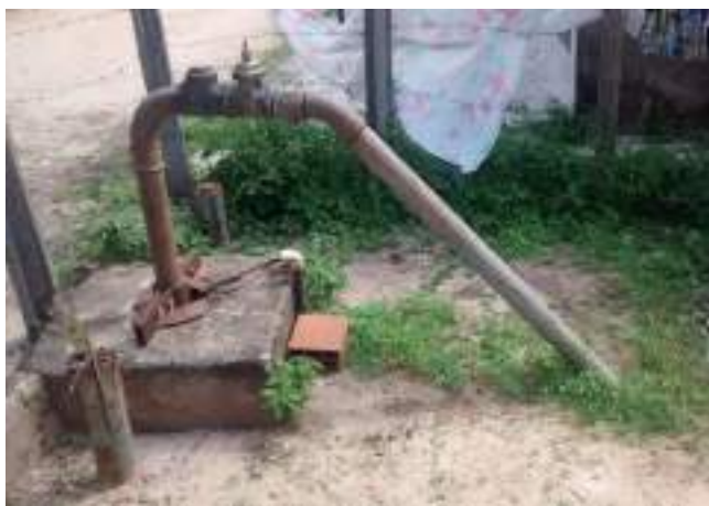
Figura 1. 66 - Poço 1 (Cabuçu) localizado em área densamente povoada
