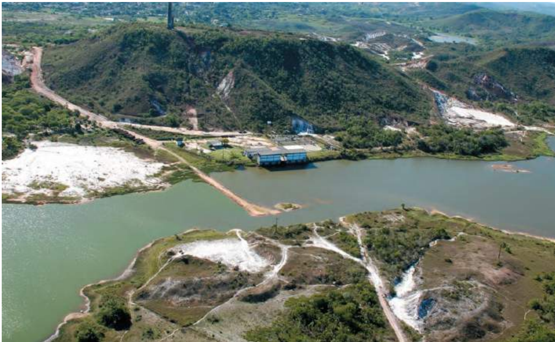
Figura 1. 30 - Vista panorâmica da captação/elevatória de Santa Helena (também conhecida como elevatória do Jacumirim)
