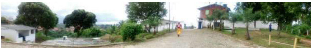
Figura 3.24 - Foto panorâmica da ETA de Saubara, onde localiza-se o RENT 200 e o RED 50
