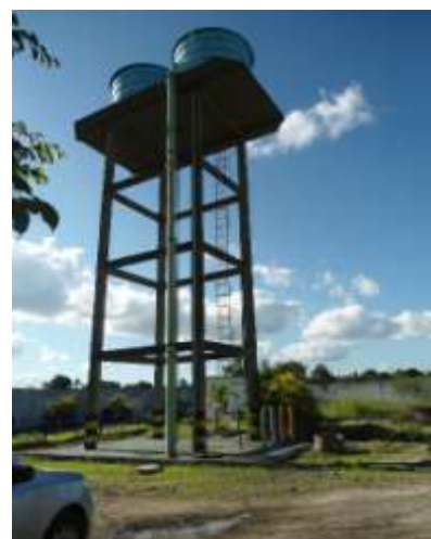
Figura 3.21 - Reservatório Elevado de Distribuição (30m 3 )
