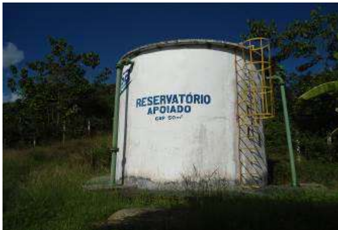
Figura 3. 9 - Reservatório existente 50 m 3 , em bom estado de conservação
