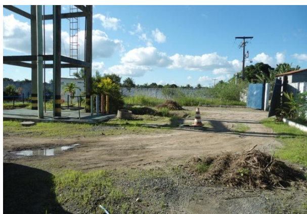
Figura 2.91 - Vista geral da área da ETA do SIAA do Planalto, devidamente cercada
