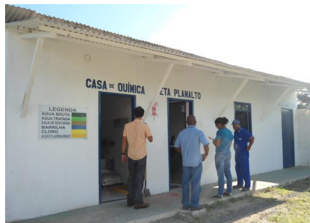
Figura 2.92 - Vista parcial da ETA do SIAA do Planalto
