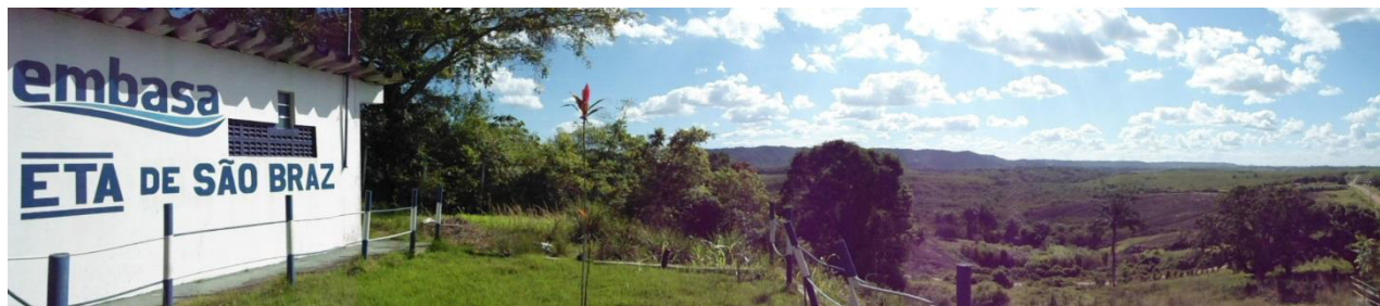
Figura 2.64 - Fotografia da área do entorno da ETA de São Brás
