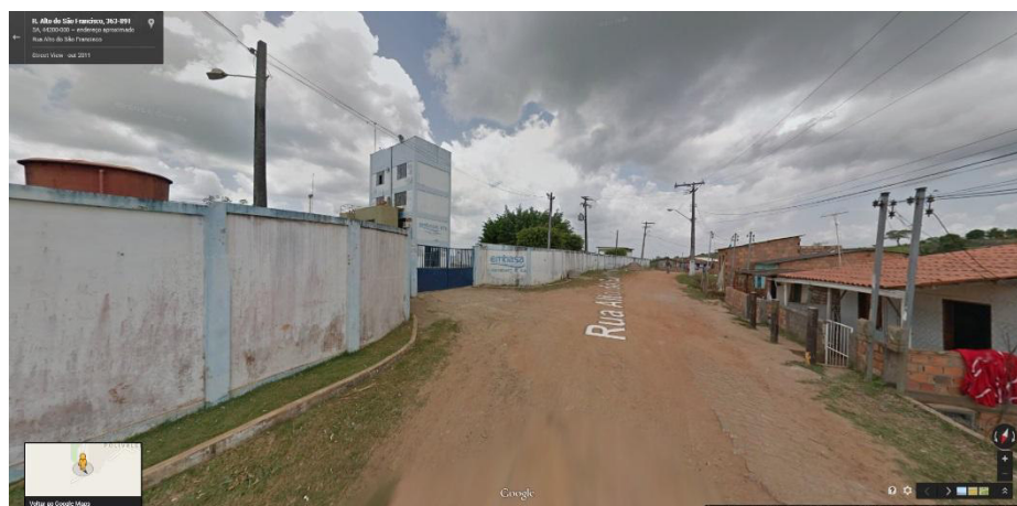
Figura 2.28 - Área no entorno da ETA de Santo Amaro
