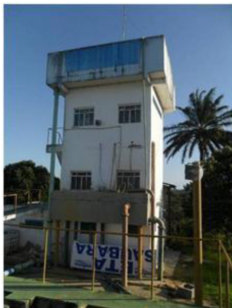
Figura 2.126 - Edificação que abriga a casa de cloração, o depósito de produtos químicos, a sala do operador e o reservatório elevado (RED 50 m³)
