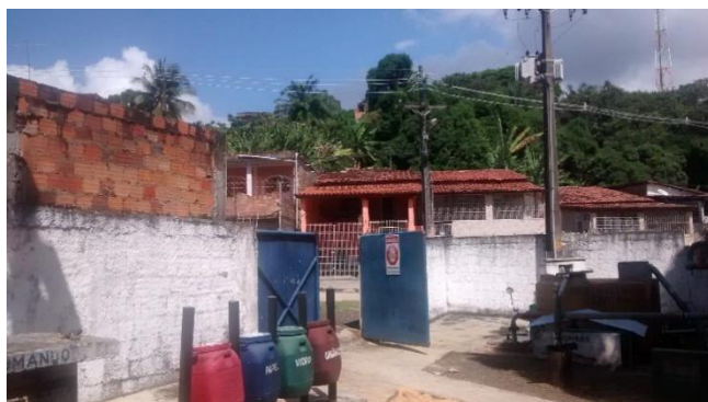
Figura 2.165 - Área no entorno da ETA de Bom Jesus dos Pobres
