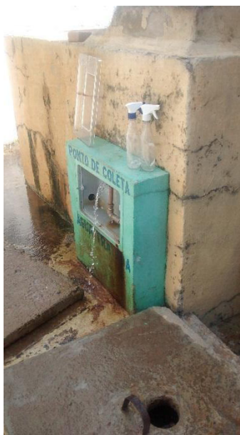
Figura 2.159 - Ponto de coleta de água tratada
