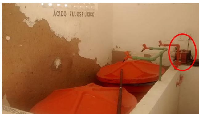
Figura 2.155 - Dosagem de ácido fluossilícico. Bombas dosadoras em destaque
