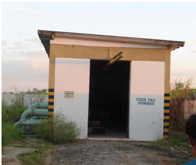
Figura 2.34 - Casa de bombas - CMB de água tratada
