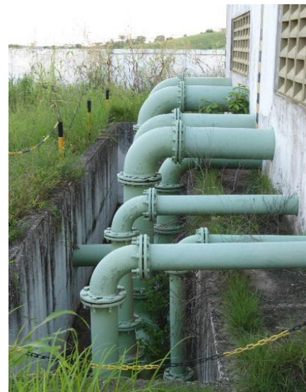
Figura 2.35 - Detalhe para os barriletes de sucção
