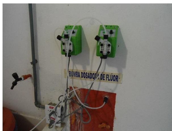
Figura 2.57 - Dosagem de Ácido Fluossilícico - bombas dosadoras
