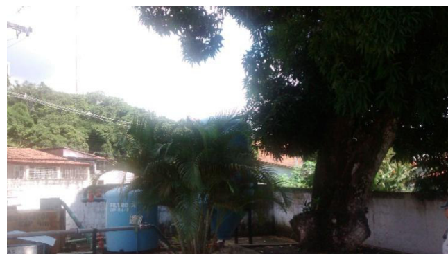
Figura 2.166 - ETA de Bom Jesus dos Pobres
