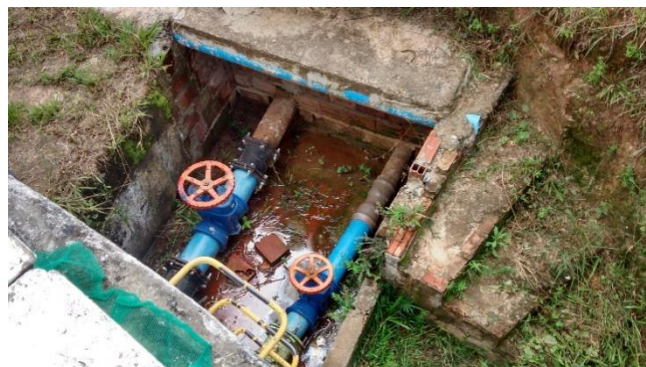
Figura 2.143 - Adutoras que abastecem as redes de distribuição de Acupe (DN 200) e Saubara (DN 160)
