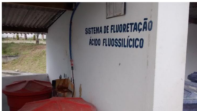
Figura 2.135 - Local de dosagem de ácido fluossilícico - sistema de fluoretação
