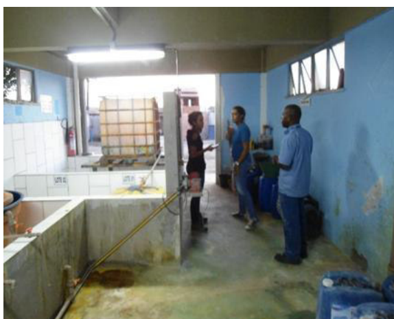
Figura 2.19 - Casa de química - produtos não identificados
