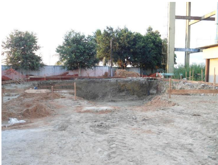
Figura 2.33 - Obras para ampliação da ETA - Construção de nova unidade de filtração (Cap. = 90L/s)
