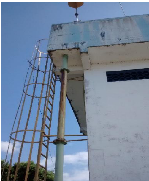
Figura 2.141 - Escada de acesso ao RED 50\text{m}^3
