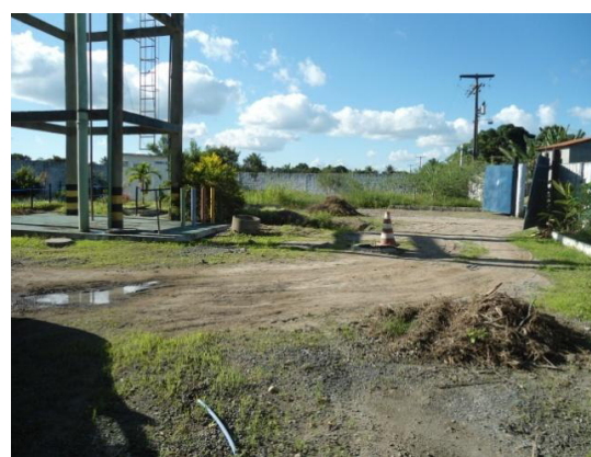
Figura 2.87 - EEAB1 - Vista geral do local da instalação
