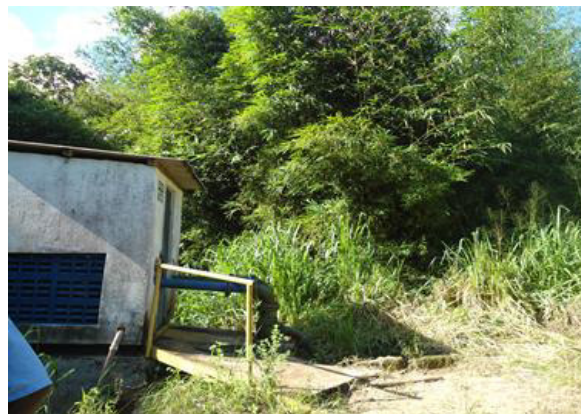
Figura 2.41 - Casa de bombas da captação superficial, evidenciando os barriletes de recalque dos CMB
