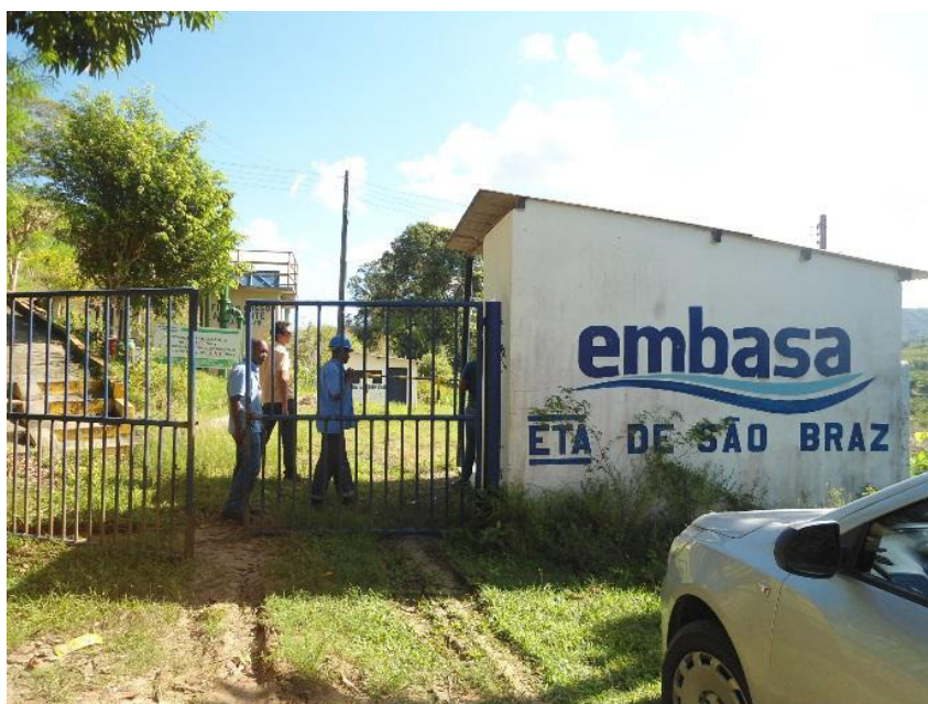
Figura 2.46 - ETA de São Brás
