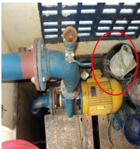
Figura 2.44 - Destaque para o balde utilizado para a retirada de areia do local de captação
