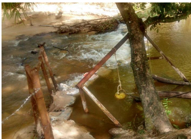
Figura 2.101 - Ponto de captação no rio Grande ou Irauá. Evidencia-se a estrutura de sustentação da bomba e pequena barragem.
