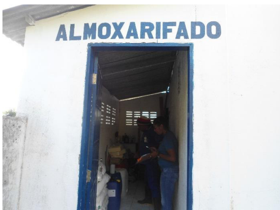
Figura 2.80 - Almoxarifado da ETA - local de armazenamento de produtos químicos e outros materiais
