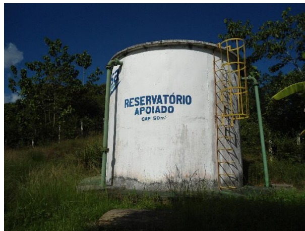
Figura 2.63 - Reservatório Apoiado de Distribuição (50m 3 )
