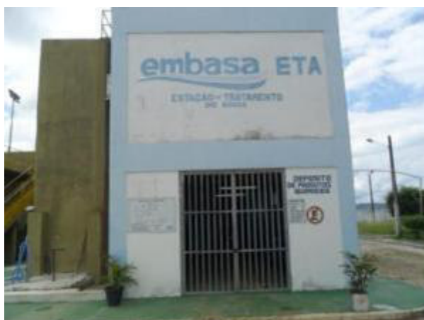
Figura 2.29 - Vista Geral do Edifício utilizado como Depósito de Produtos Químicos, Casa de Química e Sala de Reunião em 2011, anteriormente ao início das obras.
