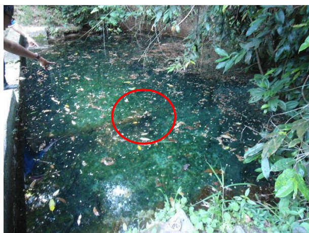
Figura 2.72 - AAB1 primeiro trecho com destaque para a válvula de retenção de sólidos (crivo)
