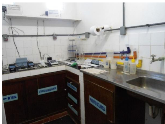
Figura 2.60 - Laboratório da ETA de São Brás
