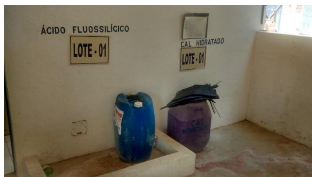
Figura 2.154 - Local de armazenamento do ácido fluossilícico e cal hidratada
