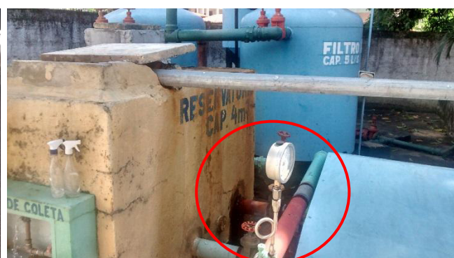
Figura 2.173 - Manômetro da tubulação de recalque do CMB de Bom Jesus dos Pobres
