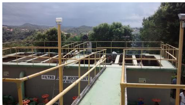
Figura 2.123 - Filtros de Fluxo Ascendente (8 unidades)
