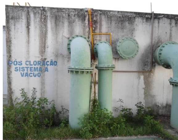
Figura 2.27 - Destaque para o sistema a vácuo do RAD 1200 m³
