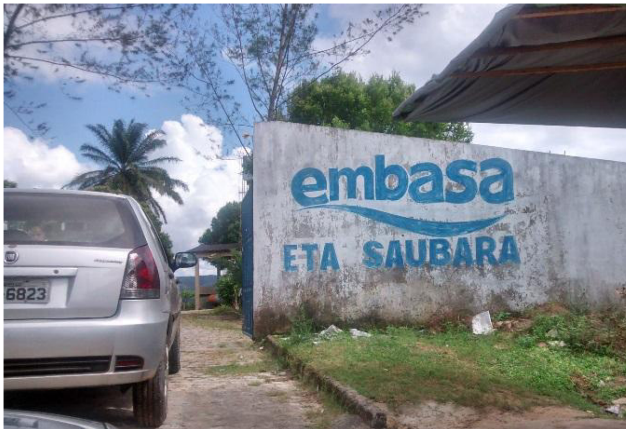
Figura 2.118 - ETA localizada em Saubara
