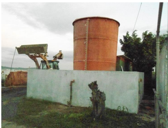
Figura 2.15 - Armazenamento de sulfato de alumínio
