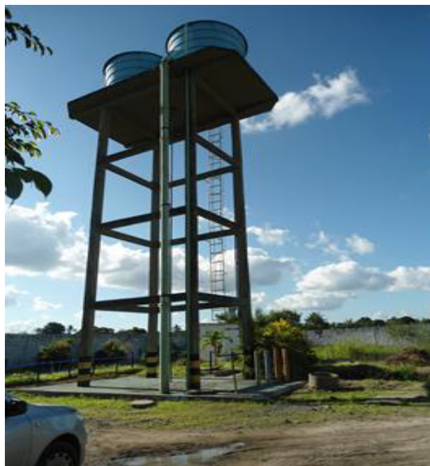
Figura 2. 99 - Reservatório Elevado de Distribuição - Capacidade total 30m 3
