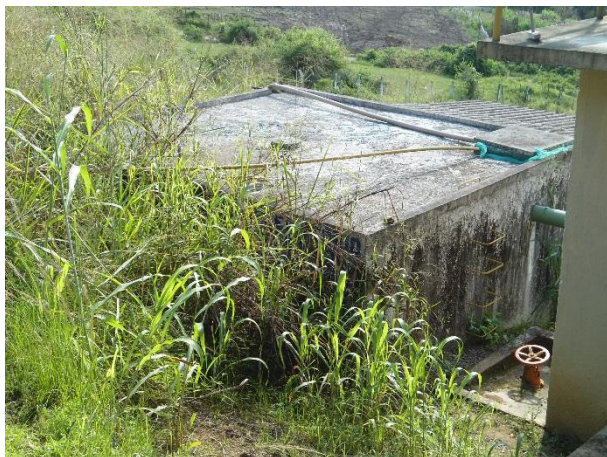
Figura 2.62 - Reservatório apoiado de 50 m 3 (tanque de contato)
