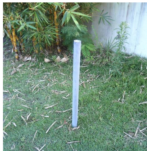
Figura 2.77 - Exemplo de local de aplicação dos produtos químicos. Neste caso, local de aplicação do corretor de pH
