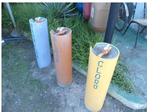
Figura 2.97 - Pontos de aplicação dos produtos químicos
