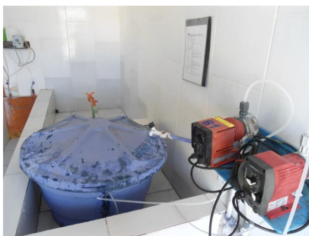
Figura 2.93 - Local de dosagem do carbonato de sódio (barrilha)
