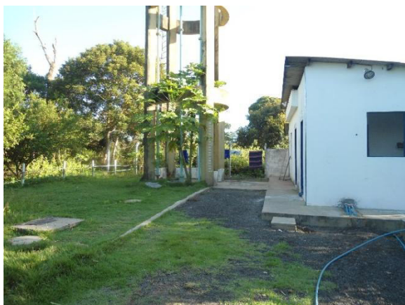
Figura 2.74 - ETA de Pedras
