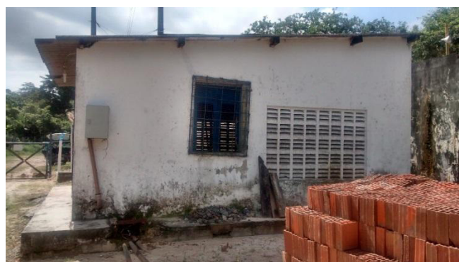
Figura 2.106 - EEB2 - A equipe não teve acesso para verificação de suas condições
