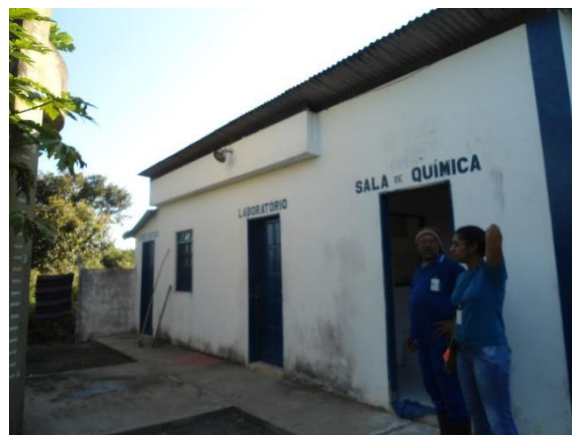
Figura 2.75 - ETA de Pedras
