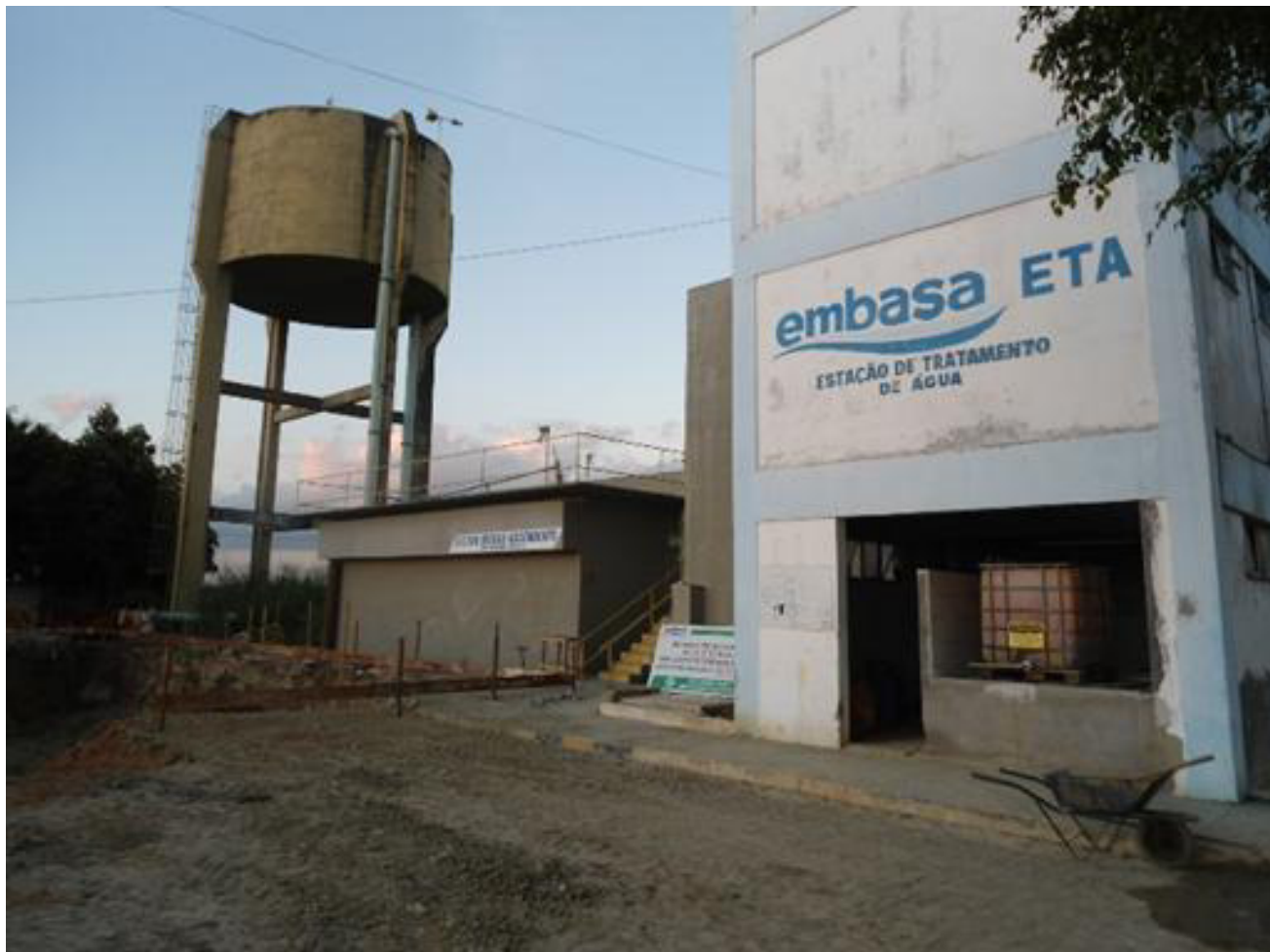
Figura 2.5 - ETA da Sede Municipal de Santo Amaro
