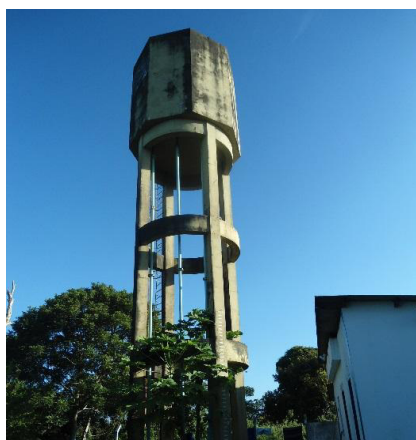
Figura 2.82 - Reservatório Elevado de Distribuição (RED) – 50 m 3
