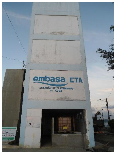
Figura 2.17 - Localização da Casa de Química, denominada no layout da ETA de Casa de Mistura
