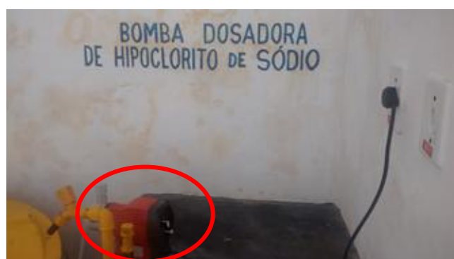
Figura 2.157 - Em destaque a bomba dosadora de hipoclorito de sódio
