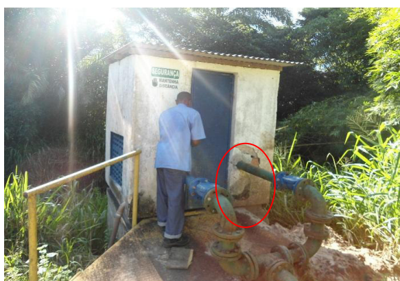
Figura 2.40 - Casa de bombas da captação superficial, evidenciando o estado de conservação
