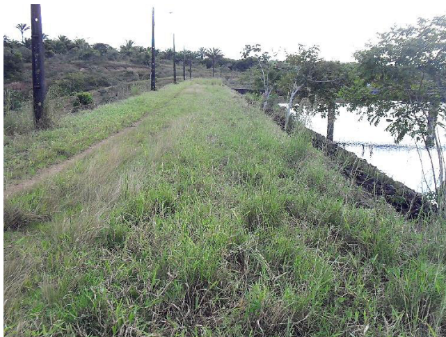
Figura 7.21 – Crista da barragem, vista da ombreira esquerda
