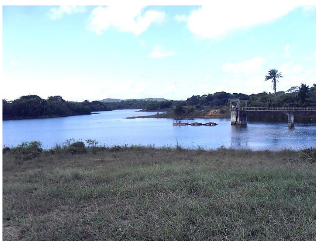
Figura 7.31 – Vista do lago com torre de tomada d'água e captação flutuante alternativa
