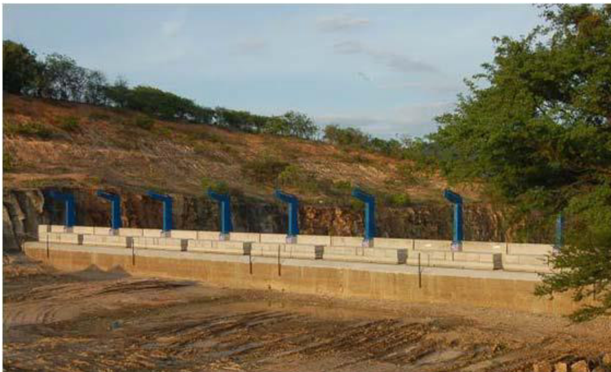
Figura 7.19 – Exemplo de fusegates na barragem do França
