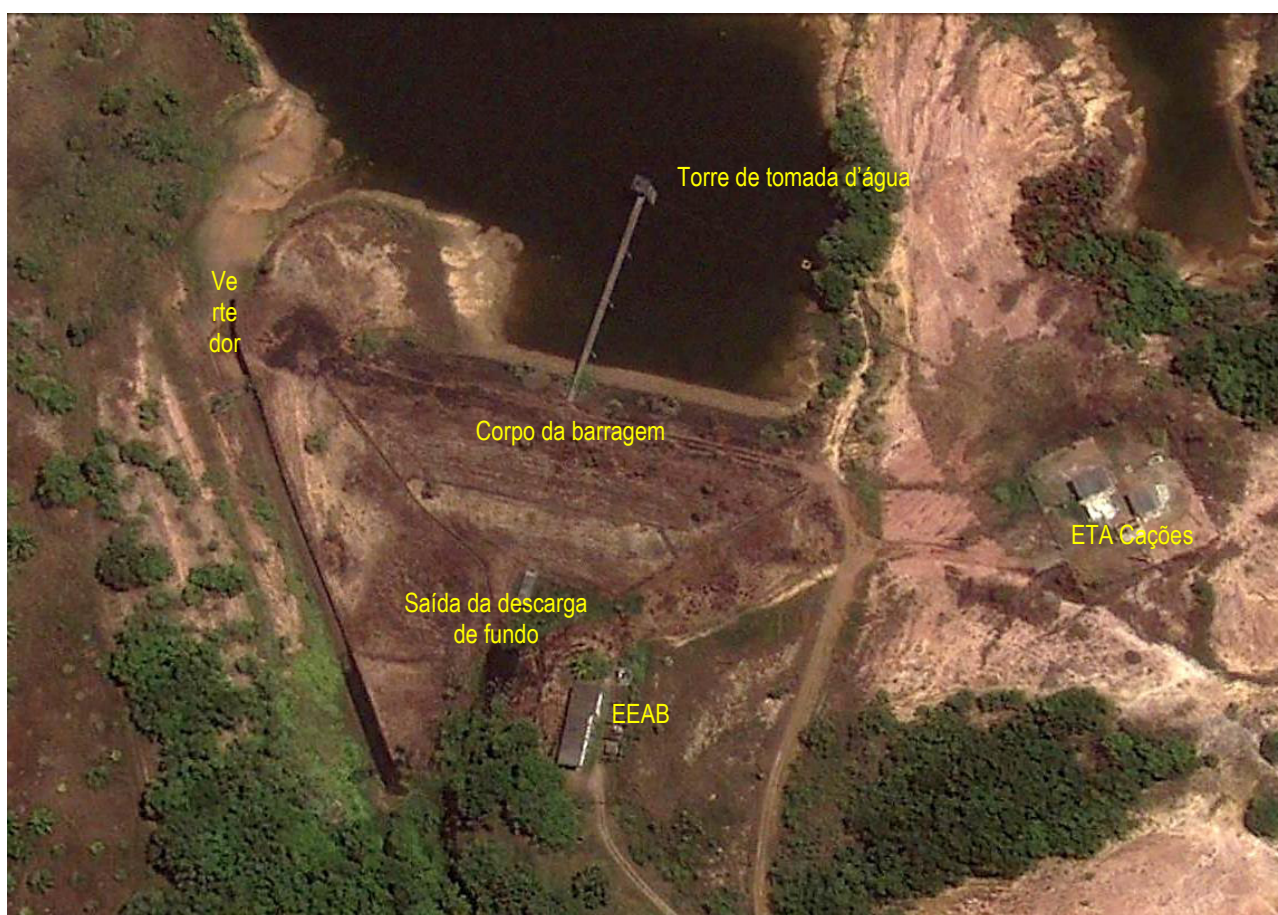
Figura 7.18 – Imagem de satélite da Barragem Tapera
