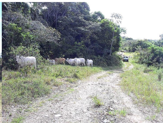
Figura 7.15 – Acesso à Barragem Tapera em área rural
