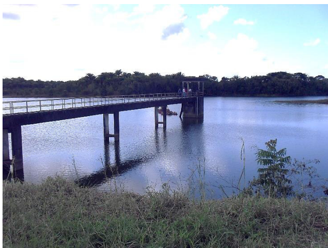
Figura 7.29 – Vista da torre de tomada d'água vista da crista da barragem
