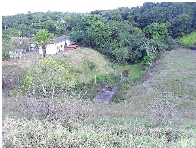
Figura 7.33 – Vista da EEAB a partir da crista da barragem
