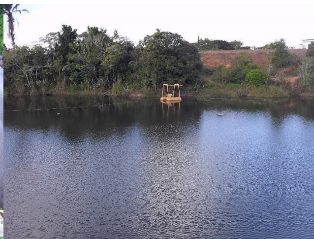
Figura 7.42 – Captação flutuante do Sistema de Abastecimento Cações
