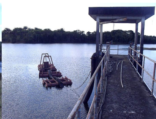
Figura 7.32 – Detalhe da torre de tomada d'água e captação flutuante alternativa
