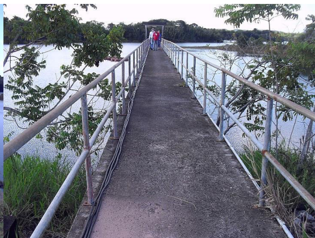
Figura 7.30 – Acesso à torre de tomada d'água
