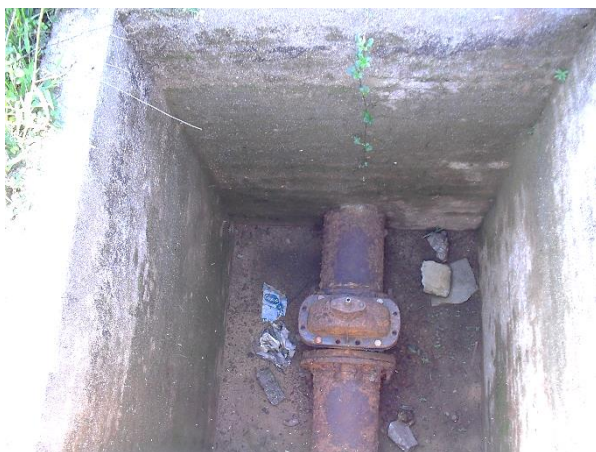
Figura 9.19 – Válvula de manobra do RAD9
