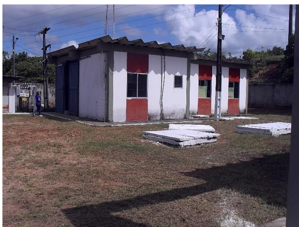
Figura 8.53 – Vista da edificação dos conjuntos motobomba da EEAT2
