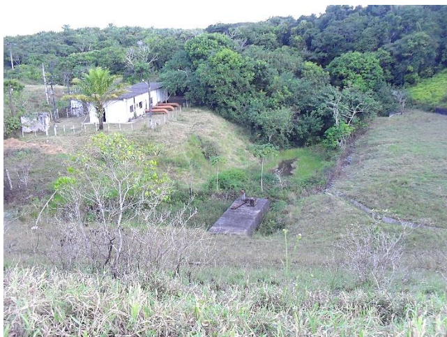
Figura 8.3 – Vista da EEAB1 a partir da crista da barragem
