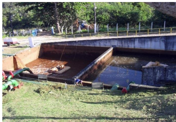
Figura 8.42 – Vista geral dos tanques de decantação da ETA
