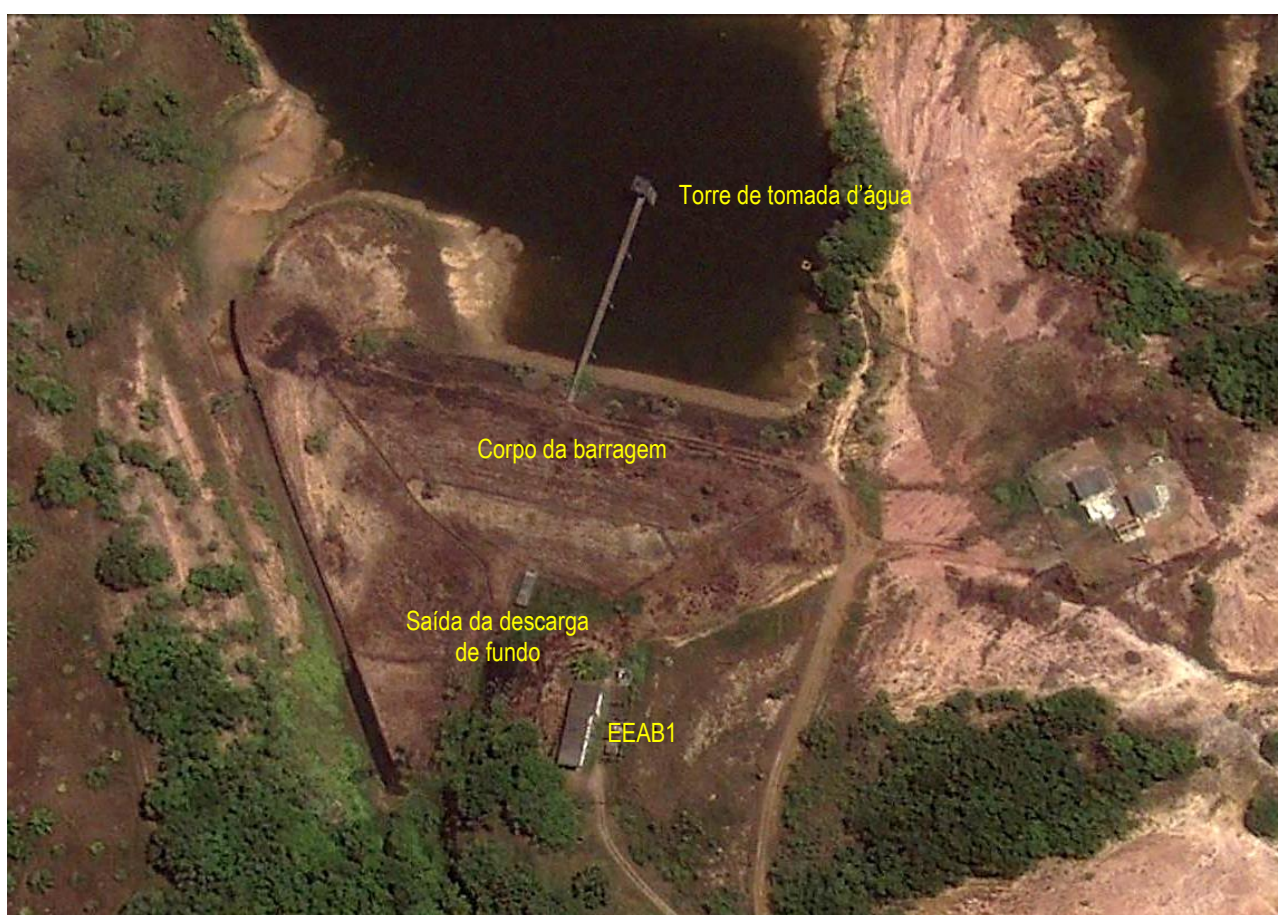
Figura 8.2 – Imagem de Satélite da Barragem Tapera
