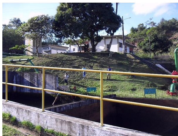
Figura 8.18 – Vista da entrada da ETA
