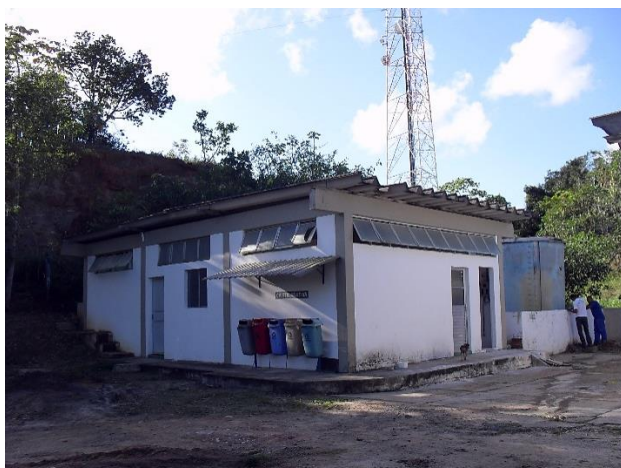
Figura 8.27 – Edificação onde se localiza área de depósito da ETA
