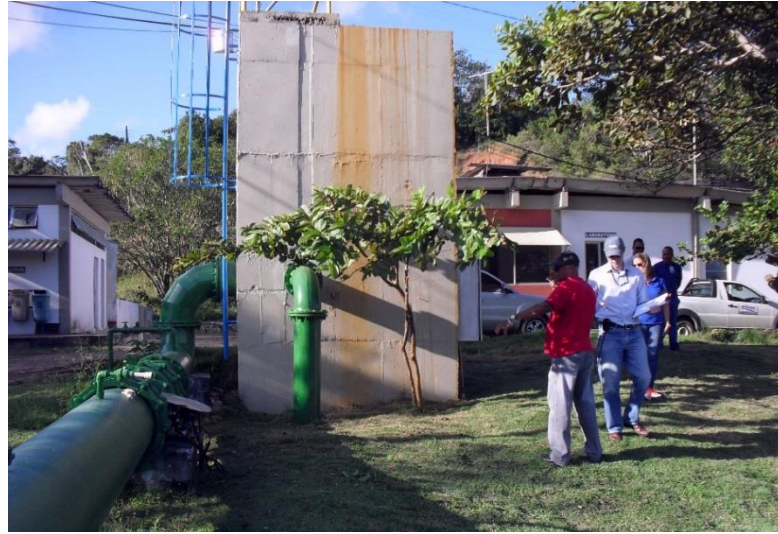
Figura 8.19 – Chegada da AAB1 na torre de mistura
