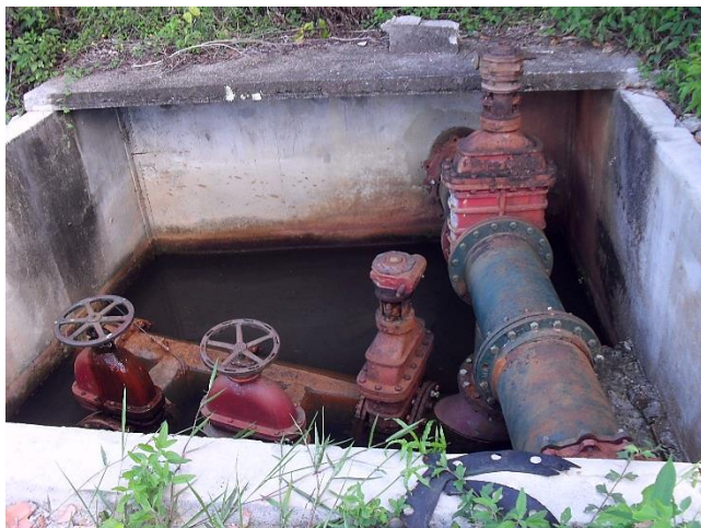
Figura 8.12 – Barrilete da EEAB1, com as derivações da AAB1 e AAB2
