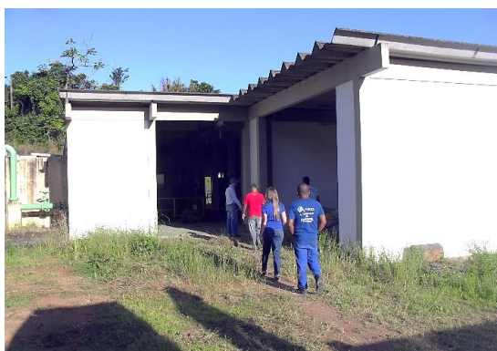
Figura 8.44 – Vista geral da edificação da EEAT1
