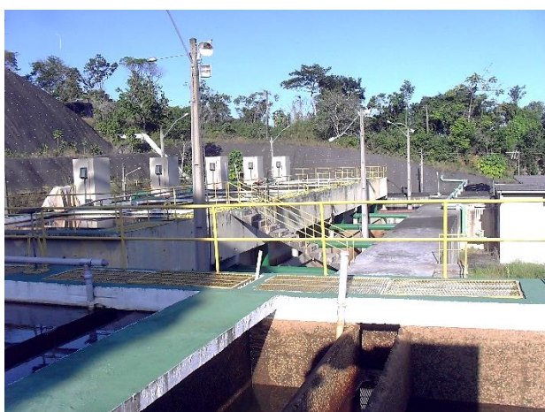
Figura 8.24 – Vista geral dos filtros e reservatório receptor de água tratada da ETA
