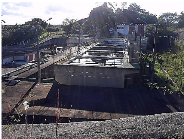
Figura 8.17 – Vista geral da ETA
