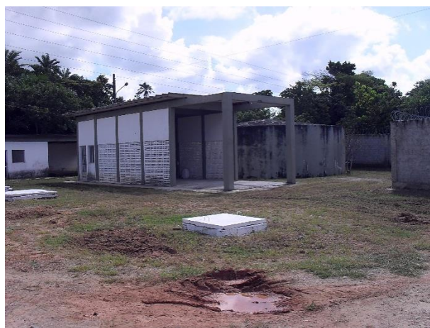
Figura 8.56 – Vista da casa de recloração da EEAT2
