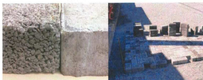
Sistema de blocos de concreto Pososo e Pavimentos Permeáveis em Vila Velha (ES)
