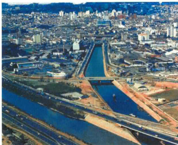
Canal de Desvio do Rio Tamanduateí - São Paulo (SP): CASO REAL
