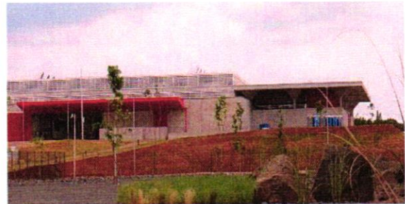
Figura 20 - Data Center Santander Campinas
