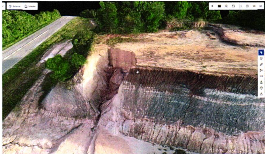
Figura 8 - Voos autônomo de drone para realizar a captura de imagens aéreas e levantamentos topográficos e altimétricos de alta precisão.
