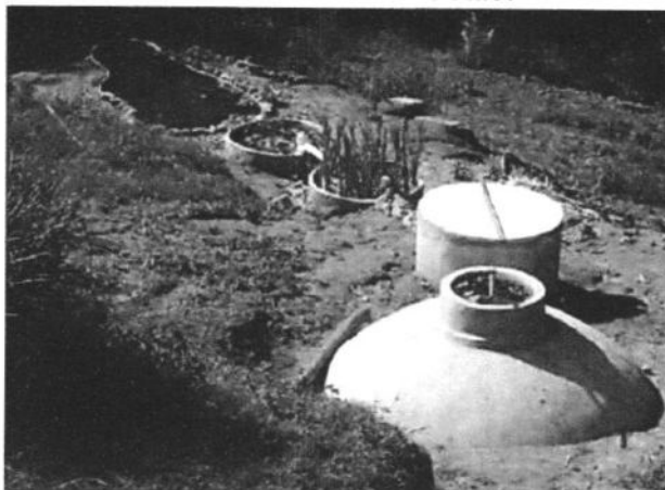
Figura 54: BSI que atende uma família e uma escola (Sítio Ko Yvy, Mury, RJ). O pós-tratamento do efluente do biodigestor é feito por dois filtros biológicos e um tanque de macrófita
