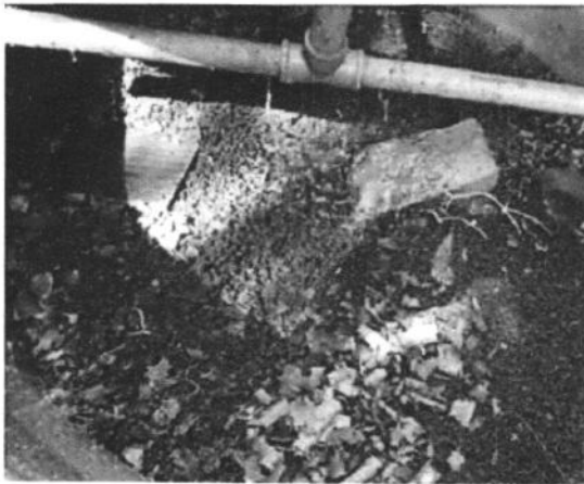
Figura 51: Detalhe de um vermifiltro unifamiliar com recheio de serragem. É possível observar a camada de vermicomposto (húmus)
