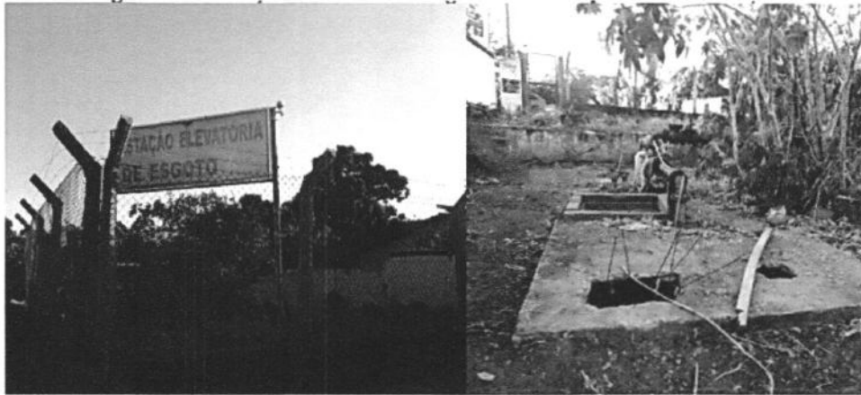
Figura 17: Estação elevatória de esgoto do município de Macaúbas/BA
