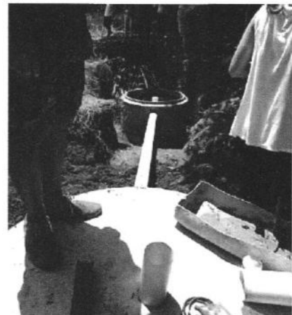
Figura 37: Filtro anaeróbio em construção. No primeiro plano, um tanque séptico. Depois o filtro anaeróbio e no fundo uma vala de infiltração preenchida com bambu
