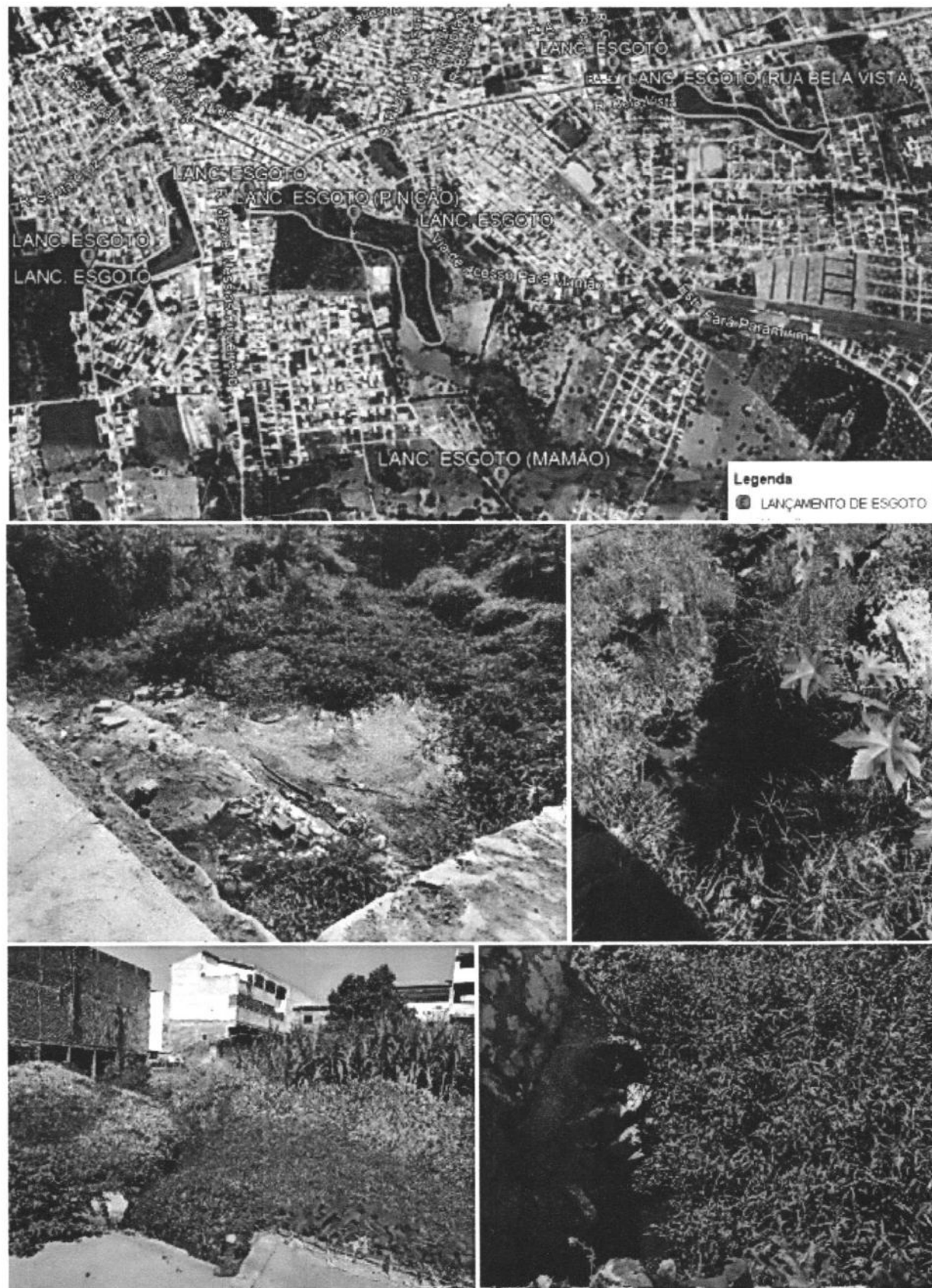
Figura 22: Pontos de lançamento de esgoto na sede municipal – município de Macaúbas/BA Fonte: Plano Municipal de Saneamento Básico e Gestão Integrada de Resíduos Sólidos, 2022
