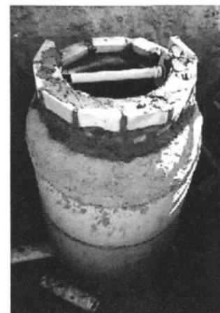
Figura 43: Biodigestor de anéis de concreto. Na imagem a cúpula está sendo construída com tijolos e suportará a tampa. A tubulação de PVC que chega na base é a entrada de esgoto
