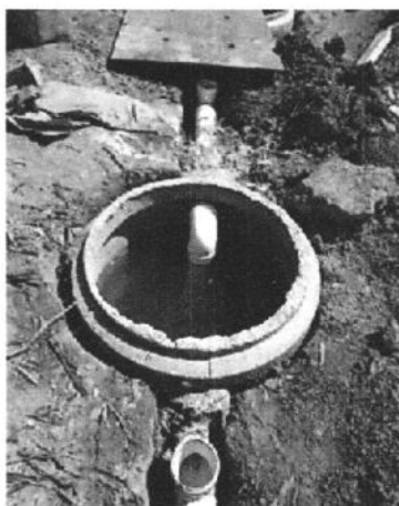
Figura 30: Tanque séptico (ainda sem a tampa instalada), construído em anéis de concreto
