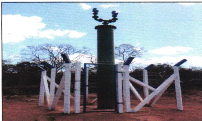
Figura 17 - Adutora De Água Bruta – Trecho EEAB 1 (Captação) / EEAB 2 - TUS
