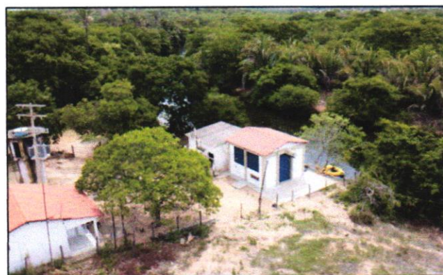
Figura 15 - Captação Flutuante – Rio Itaguari
