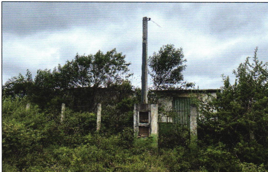
EEAT1 – ADUTORA DE ÁGUA TRATADA
