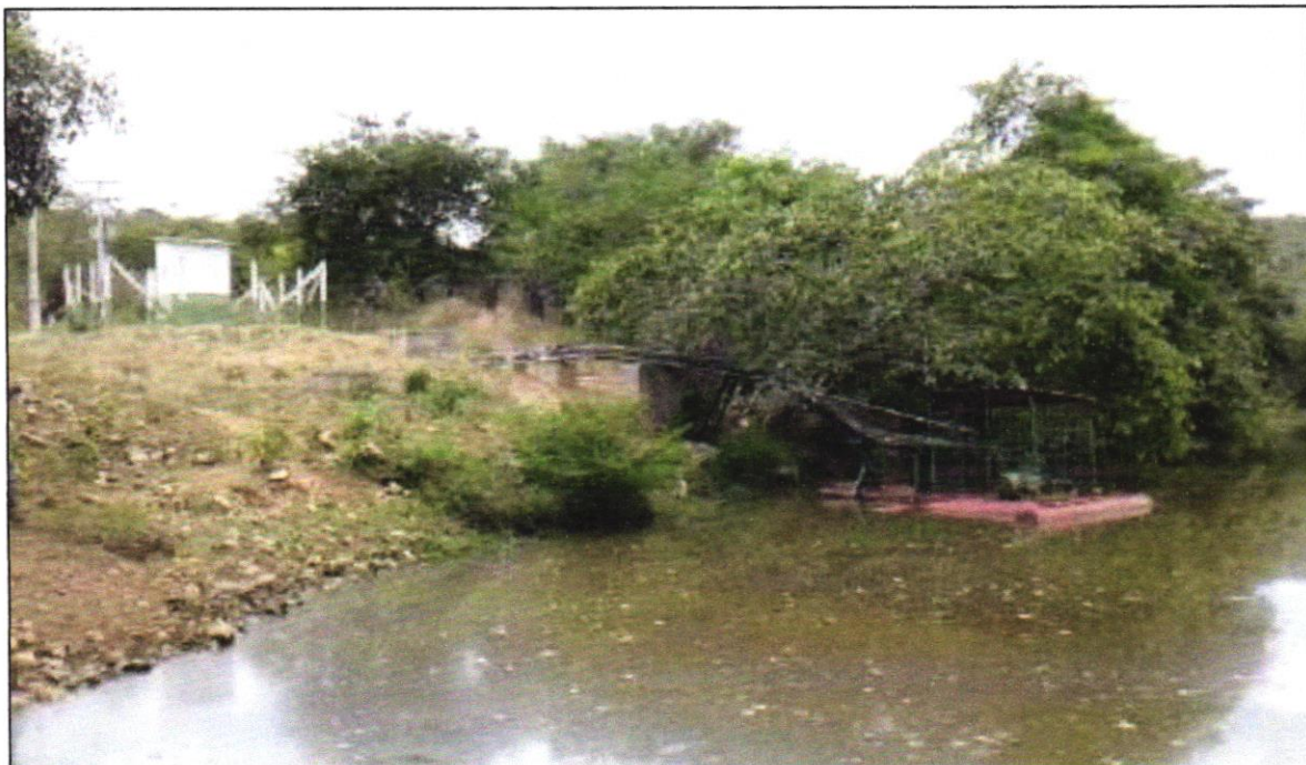
Captação Flutuante – Rio Pardo; na margem em terra a casa de comando
