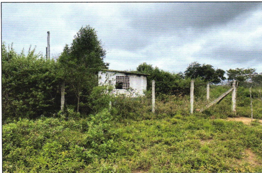
EEAT 1 – ADUTORA DE ÁGUA TRATADA
