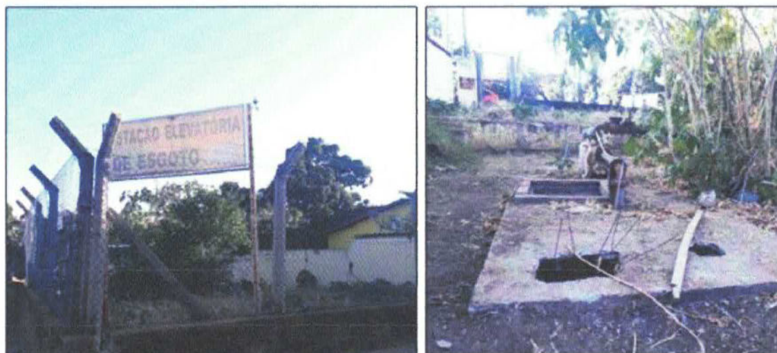
Figura 7. Estação elevatória de esgoto inativa do município de Macaúbas-BA Fonte: PMSB, 2022.
