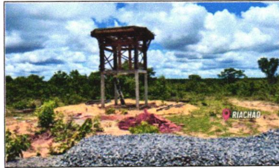
Figura 11. Obras do Sistema Simplificado de Abastecimento das localidades de Jacaré e Riachão Fonte: CERB, 2025
