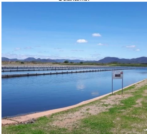
Figura 92 - Lagoa de Maturação da ETE Guanambi
