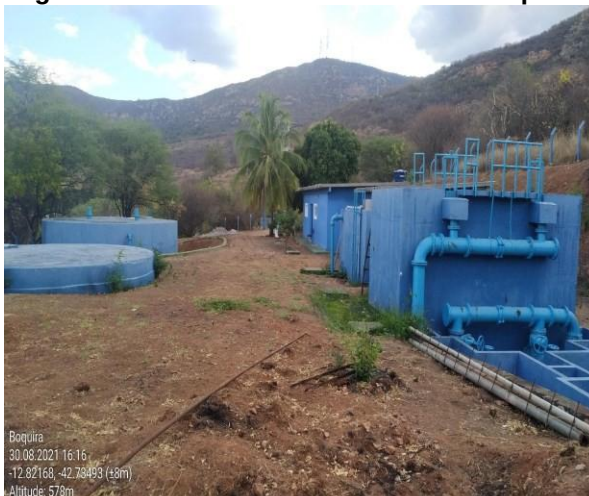
Figura 66 – Decantadores da ETA do Sistema Sede de Boquira
