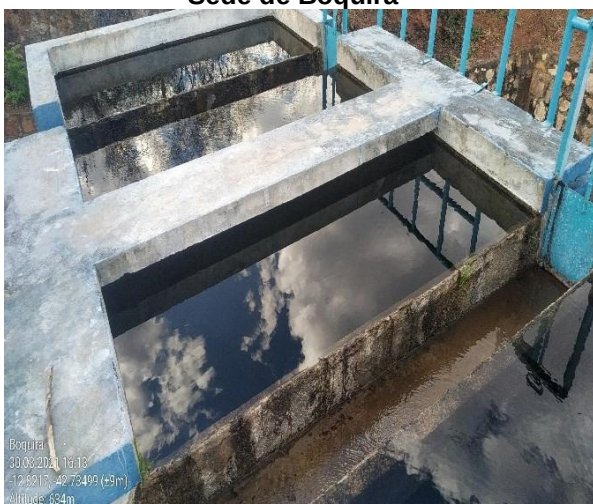
Figura 66 – Decantadores da ETA do Sistema Sede de Boquira
