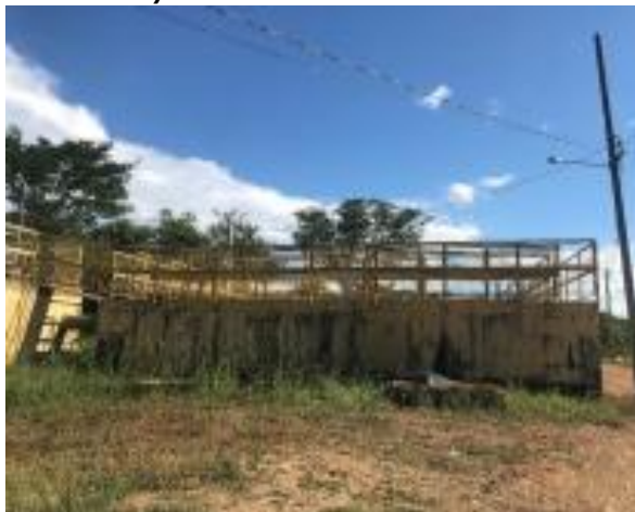
Figura 63 – ETA do Sistema Sede (São Desidério)
