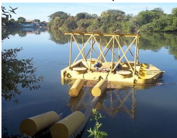
Figura 51 – Captação Rio Corrente (SAA SGNP Santana)
