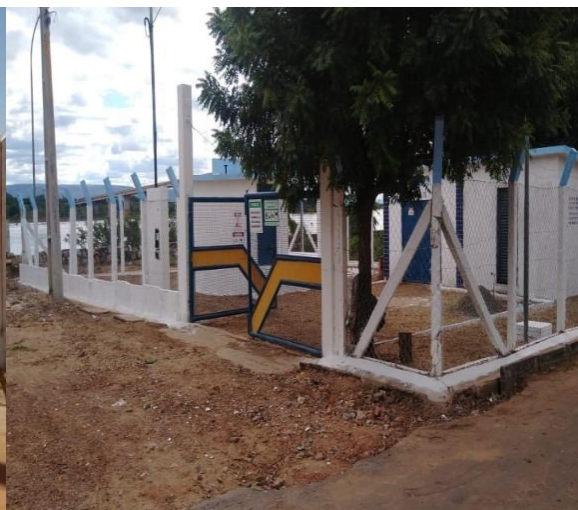
Figura 82 – EEE 03 do Sistema Sede (Ibotirama)
