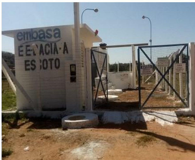
Figura 81 - EEE A do Sistema Sede (Canápolis)
