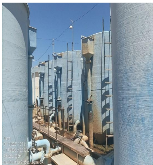
Figura 65 – Filtros da ETA do Sistema Sede de Barra
