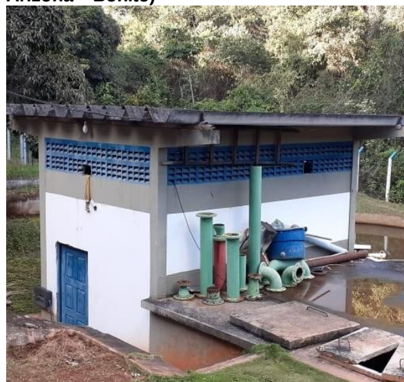
Figura 69 – Casa da EEAT (Sistema Sede e Arizona – Bonito)
