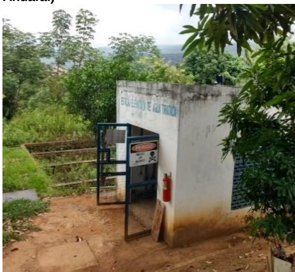
Figura 68 – EEAT (Sistema Sede – Andaraí)
