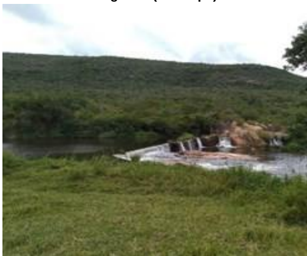
Figura 52 – Captação Rio Sujo do SAA Caraguatai (Jussiape)
