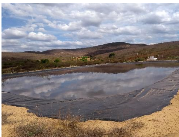
Figura 86 – Lagoa Anaeróbia – ETE Gentio do Ouro (Sistema Sede)
