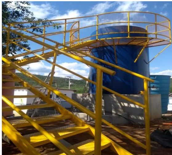
Figura 64 – Flocculadores da ETA do SAA Sede e Faustino de Iaçú
