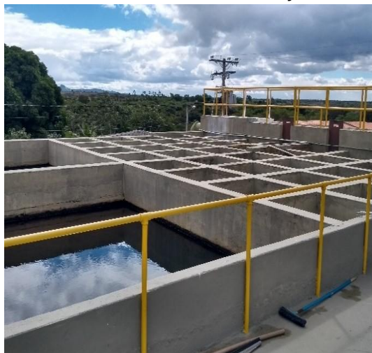
Figura 64 – Flocculadores da ETA do SAA Sede e Faustino de Iaçú
