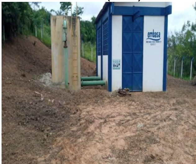
Figura 67 – EEAT do Sistema Sede, Andaraí e Sumaré (Piritiba)
