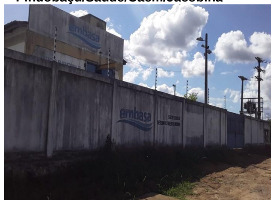
Figura 62 – EEAB2 SAA Pindobaçu/Saúde/Caém/Jacobina
