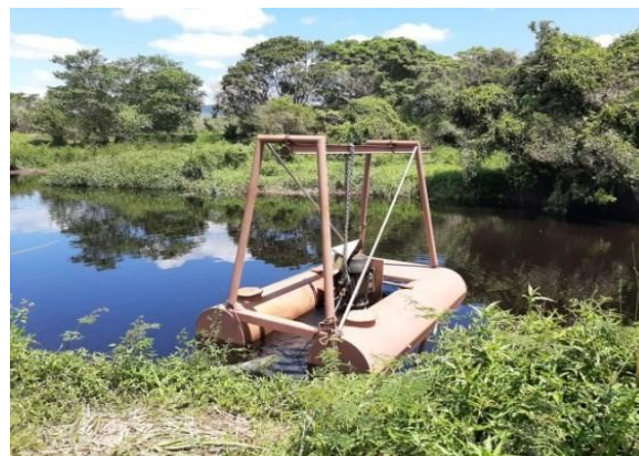
Figura 54 – Flutuante Captação Argoim
