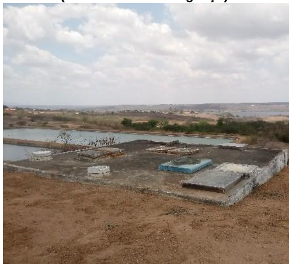
Figura 87 – ETE do Sistema Sede (Cabeceiras do Paraguaçu)
