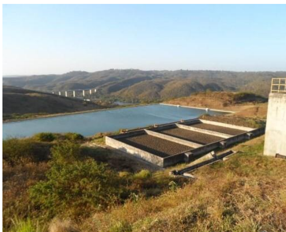
Figura 89 – ETE do Sistema Sede (Muritiba)
