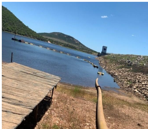
Figura 53 – Captação Barragem de Ponto Novo
