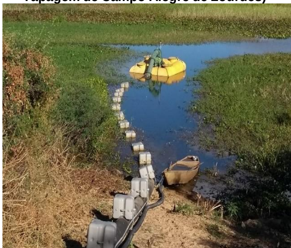
Figura 52 – Captação Flutuante Lago Sobradinho (Sistema Sede, Angico e Tapagem de Campo Alegre de Lourdes)
