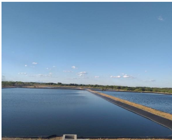
Figura 100 – ETE do Sistema Sede de Abaré
