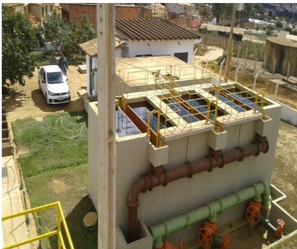
Figura 63 – ETA do SAA Sede Encruzilhada
