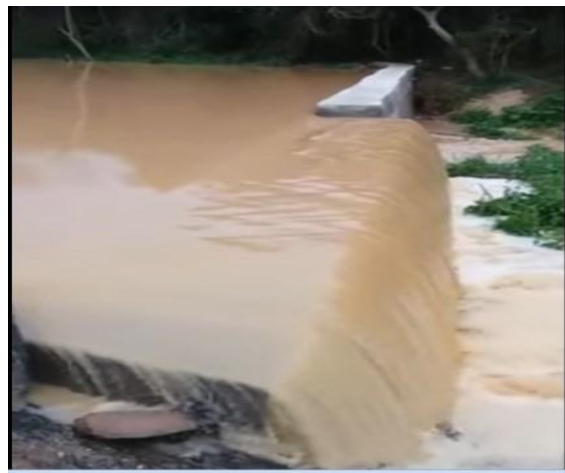
Figura 53 – Captação Rio Preto
