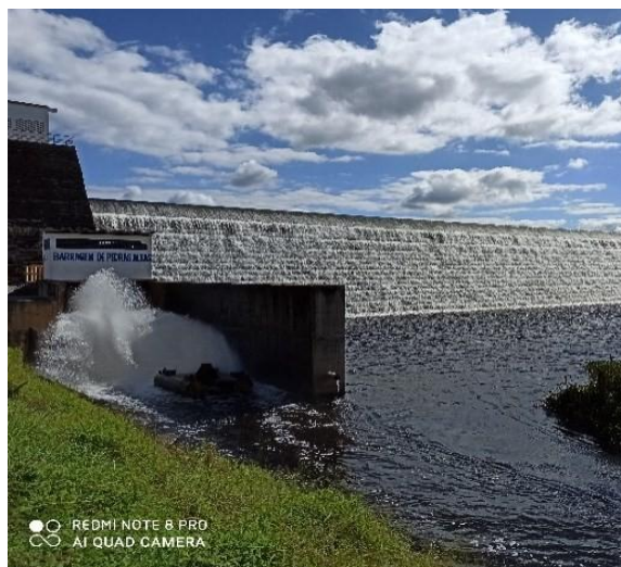
Figura 52 – Captação Barragem de Pedras Altas
