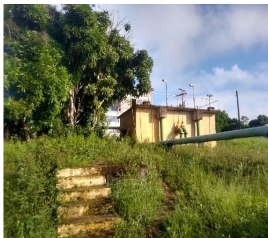
Figura 64 – Filtro ETA Terra Nova
