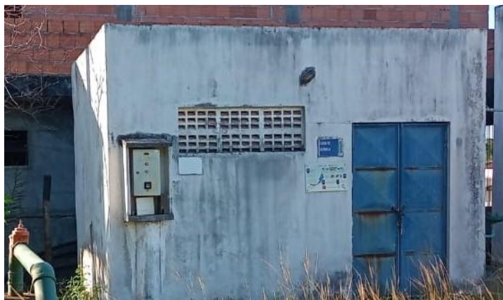
Figura 5.95 - Biribeira: vista da casa de química e barrilete do poço ao lado. Fonte: Embasa (2024).
