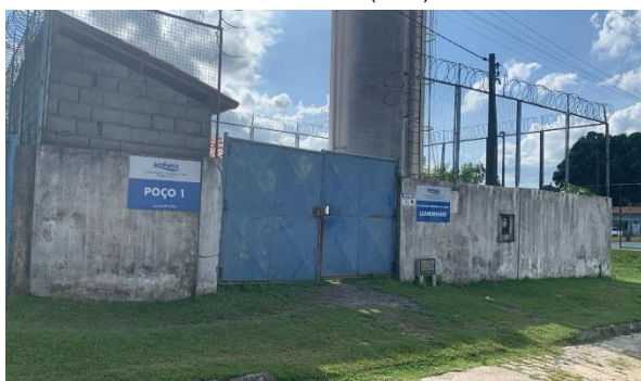
Figura 5.78 - Leandrino CSB1: vista área do poço Fonte: Embasa (2024).
