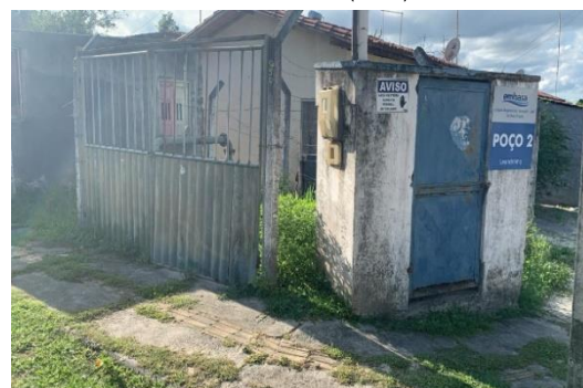
Figura 5.79 - Leandrino CSB2: vista área do poço. Fonte: Embasa (2024).
