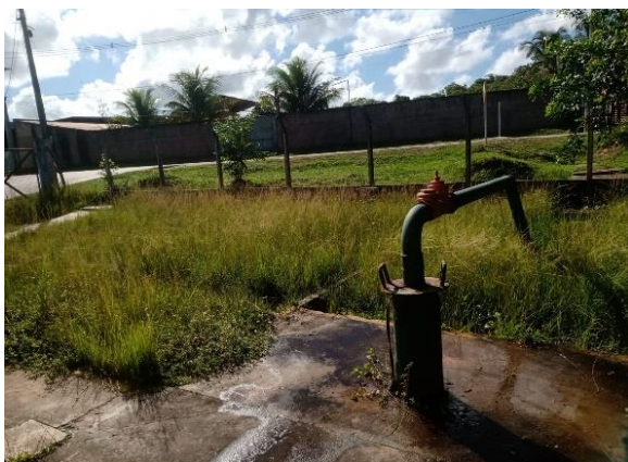
Figura 5.93 - Biribeira: vista do barrilete do poço e cerca da área
