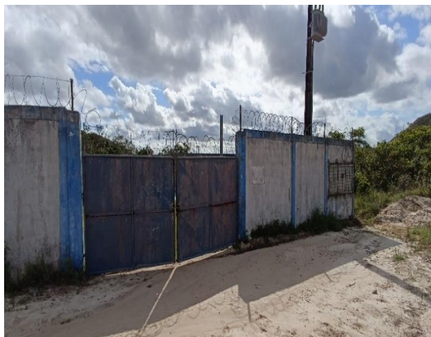
Figura 5.13 - Poço CSB2: vista geral da instalação, proteção com muro e falta de identificação e sinalização de acesso restrito
