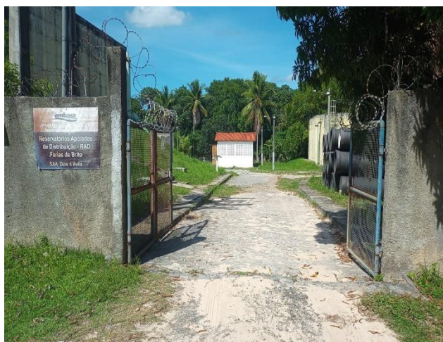
Figura 5.35 - ETA Farias de Brito: vista da entrada da área Fonte: Embasa (2024).
