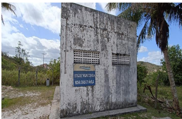
Figura 5.62 - Nova Dias d'Ávila: vista da casa de química Fonte: GEOHIDRO (2024).
