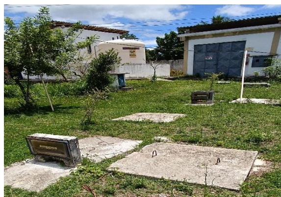
Figura 5.26 - área ETA Dias d'Ávila: ponto de coleta, medição de vazão e pressão dos poços 5, 6 e 7A. Fonte: GEOHIDRO (2024).
