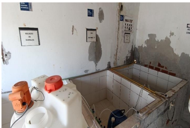
Figura 5.64 - Nova Dias d'Ávila: vista das bombas dosadoras de barrilha e flúor da casa de química Fonte: GEOHIDRO (2024).
