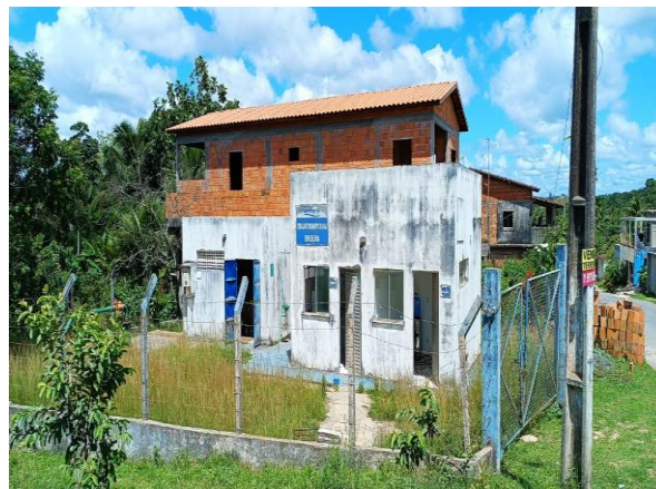
Figura 5.20 - SAA Biribeira: vista da área do poço, proteção com cerca, portão e identificação Fonte: Embasa (2024).
