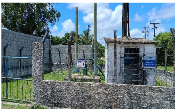
Figura 5.7 - Poço CSB5: área com muro/cerca, portão e sinalização Fonte: GEOHIDRO (2024).
