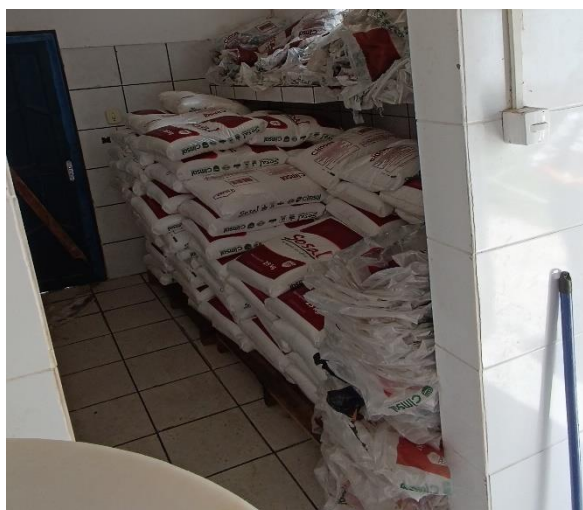
Figura 5.33 - ETA Dias d'Ávila: casa de química, estrado de armazenagem de cloreto de sódio Fonte: GEOHIDRO (2024).
