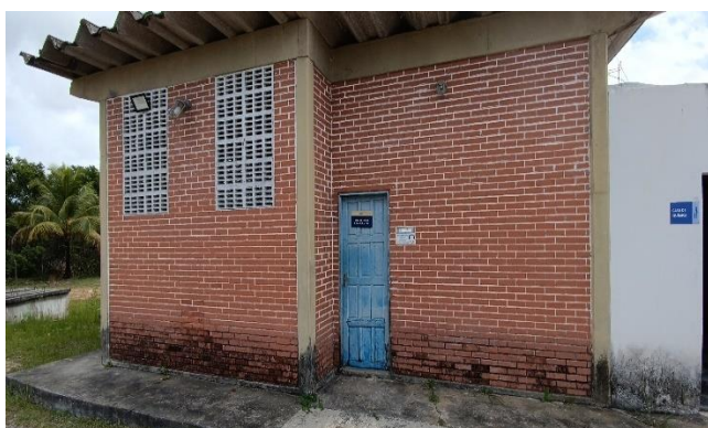
Figura 5.68 - Nova Dias d'Ávila: vista da estação elevatória de água tratada (EEAT) Fonte: GEOHIDRO (2024).
