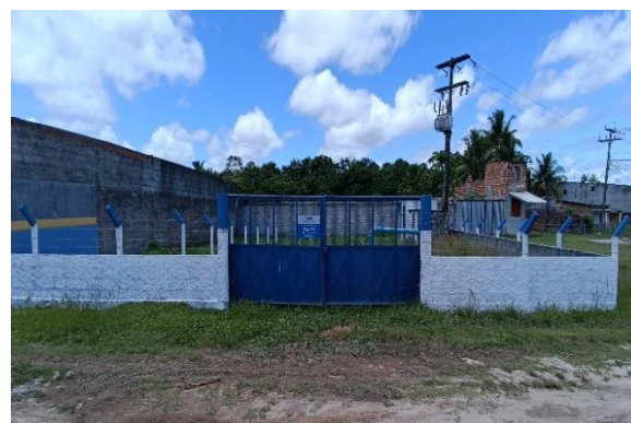
Figura 5.8 - Poço CSB7A: área com muro, portão com sinalização Fonte: GEOHIDRO (2024).
