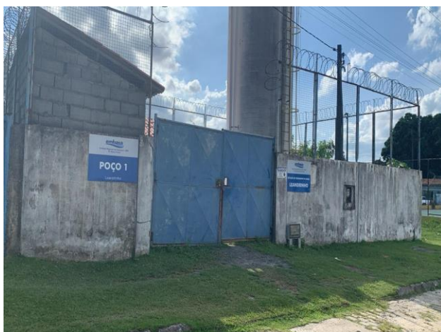
Figura 5.15 - SAA Leandrinho: poço 1 - proteção com muro e concertina; portão, identificação e indicação de acesso restrito
