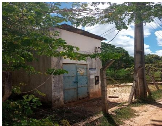
Figura 5.21 - SAA Boa Vista de Santa Helena: área do poço, proteção com cerca Fonte: Embasa (2024).
