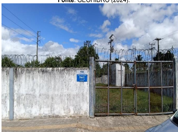
Figura 5.11 - Poço CSB11: proteção com muro e concertina; portão e identificação e indicação de acesso restrito
