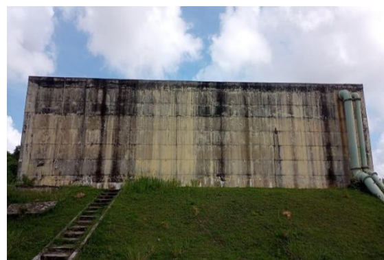
Figura 5.38 - ETA Farias de Brito: vista do RAD 1-1.500m³, onde são aplicados os produtos químicos Fonte: Embasa (2024).
