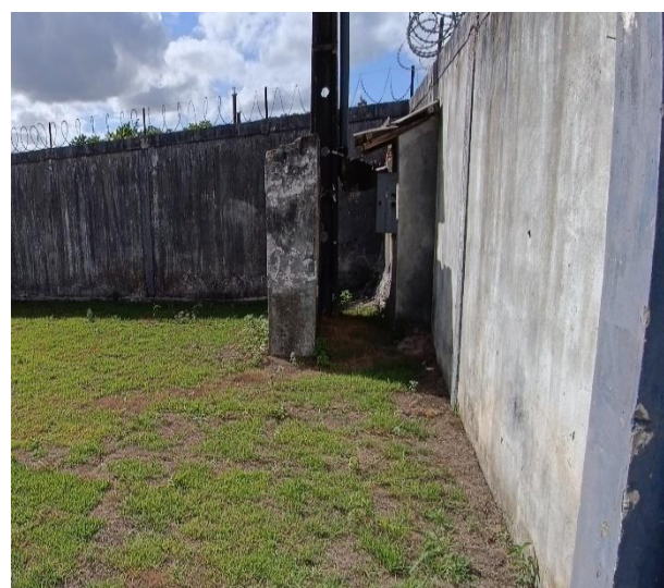
Figura 5.61 - Nova Dias d'Ávila: vista do quadro de comando da EEAB2 Fonte: GEOHIDRO (2024).
