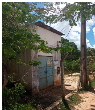
Figura 5.102 - Boa Vista de Santa Helena: vista da área do poço
