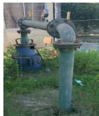
Figura 5.77 - Leandrino CSB2: vista do barrilete da bomba e inexistência de pau de carga Fonte: Embasa (2024).
