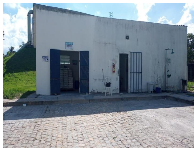
Figura 5.36 - ETA Farias de Brito: vista da casa de química Fonte: Embasa (2024).
