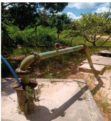
Figura 5.101 - Boa Vista de Santa Helena: vista do barrilete do poço
