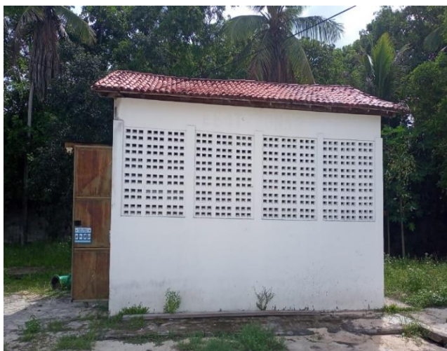
Figura 5.49 - EEAT2: vista das instalações
