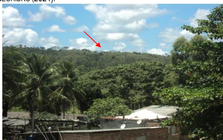
Figura 5.74 - Nova Dias d'Ávila: reservatório apoiado 150 m³, vista do local
