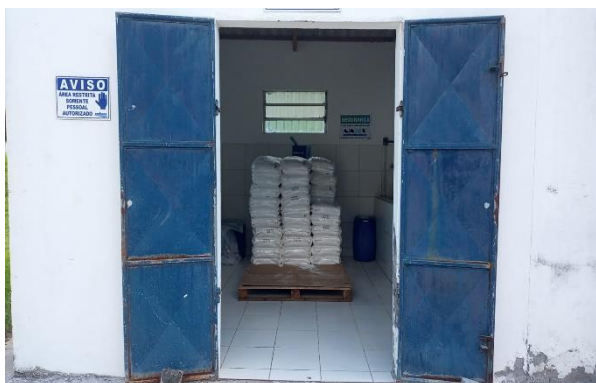
Figura 5.37 - ETA Farias de Brito: vista do estrado da área de armazenamento de barrilha Fonte: Embasa (2024).
