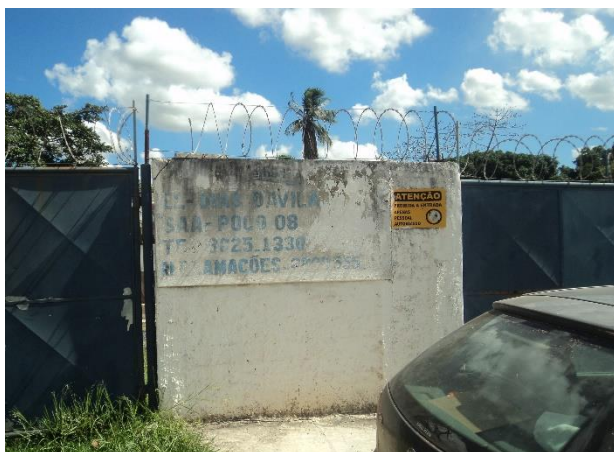
Figura 5.9 - Poço CSB8: área com proteção com muro e concertina, com identificação e indicação de acesso restrito
