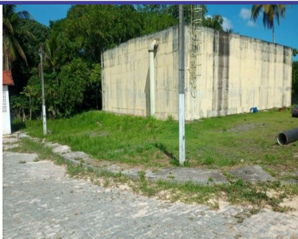
Figura 5.51 - EEAT2: vista das instalações Fonte: Embasa (2024).
