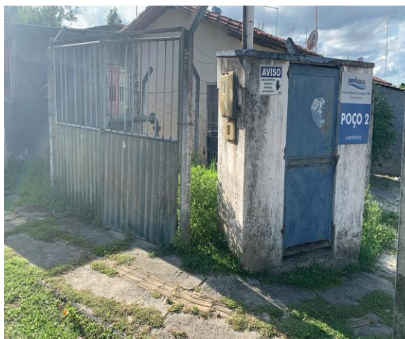
Figura 5.17 - SAA Leandrino: Poço 2 - proteção com cerca; portão, identificação e indicação de acesso restrito Fonte: Embasa(2024).
