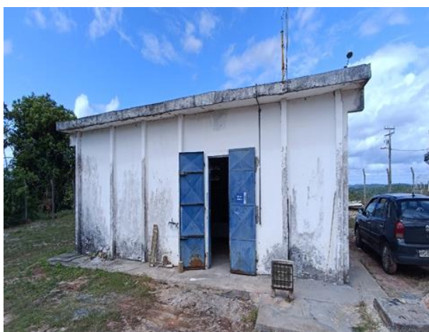
Figura 5.39 - ETA Canta Galo: vista da casa de química Fonte: GEOHIDRO (2024).
