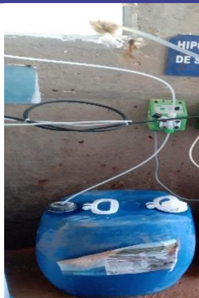
Figura 5.107 - Boa Vista de Santa Helena: vista do tanque de preparo, bomba dosadora do hipoclorito Fonte: Embasa (2024).
