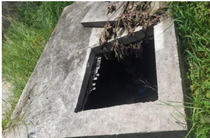
Figura 5.84 - Vista do abrigo da EEAT do SAA Leandrino Fonte: Embasa (2024).
