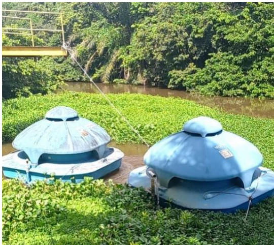
Figura 6.9 - Estruturas flutuantes do EEAB3 no Rio Pojuca Fonte: GEOHIDRO (2024).
