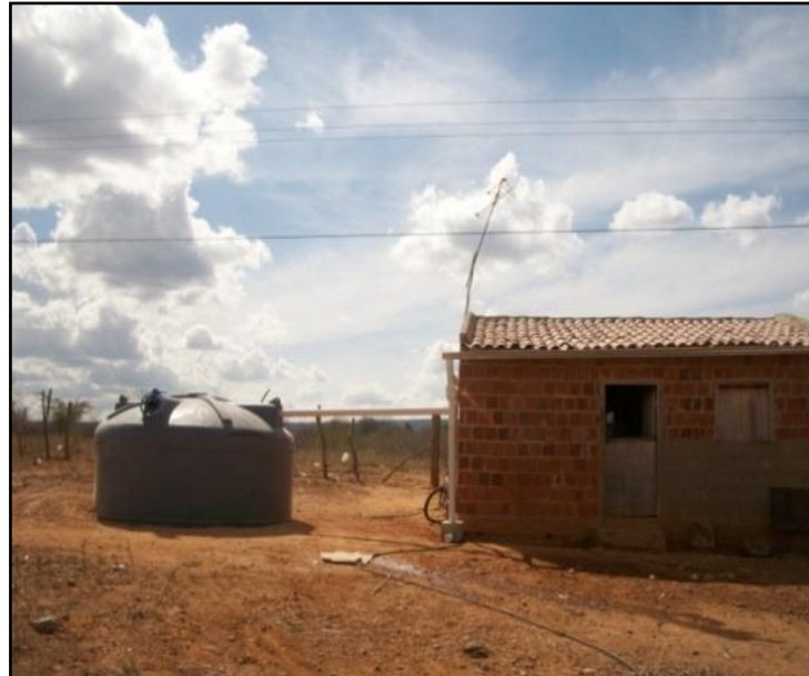
Figura 5.15 - Utilização de cisterna como solução individual para abastecimento de água
