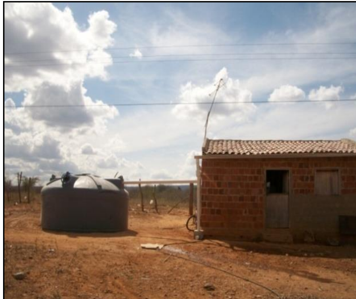
Figura 7.4 - Utilização de cisterna como solução individual para abastecimento de água
