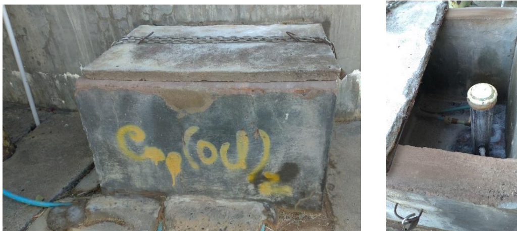
Figura 2.64 - Local de aplicação do hipoclorito de cálcio
