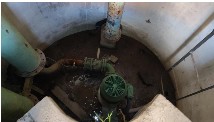
Figura 2.30 - Booster situado na parte inferior do R7- Abastecimento do Malembá
