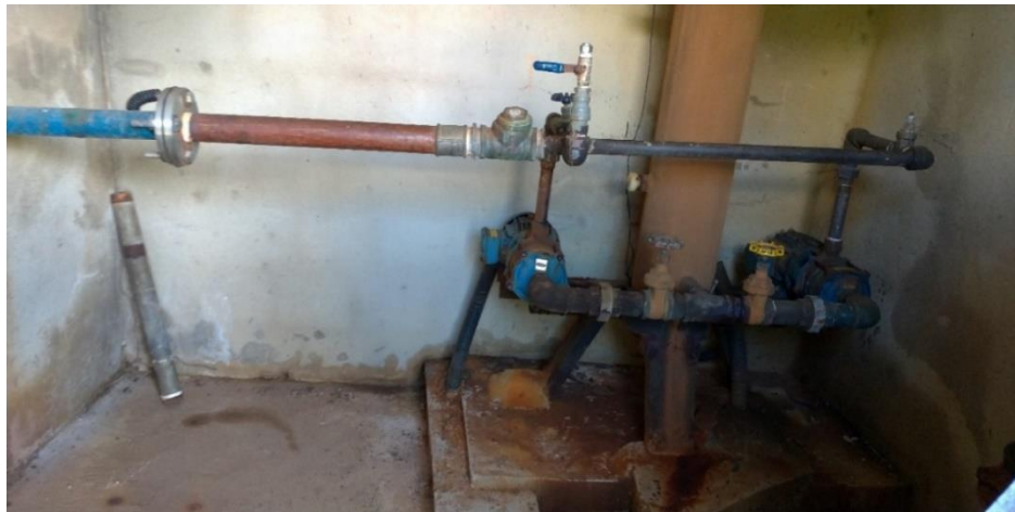
Figura 2.28 - Booster Santana das Neves Fonte: SEINFRA (2023).
