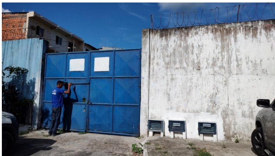
Figura 2.36 - Entrada da área do RZM
