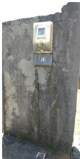
Figura 2.29 - Medidor de energia e quadro de comando do Booster de Santana das Neves Fonte: SEINFRA (2023).
