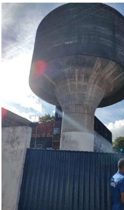
Figura 2.43 - Entrada e vista do Reservatório R7
