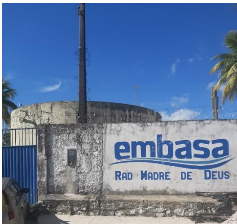
Figura 2.59 - Entrada da área de localização do Reservatório Apoiado de Madre de Deus Fonte: GEOHIDRO (2024).
