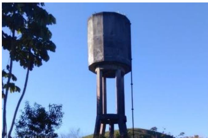
Figura 2.13 - Reservatório Elevado Caruaçu
