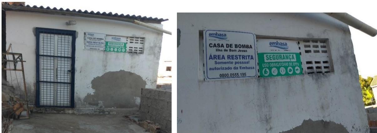
Figura 2.57 - Área da Estação Elevatória de Água Tratada de Bom Jesus dos Passos
