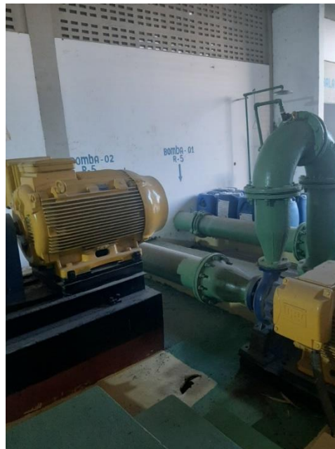
Figura 2.20 - CMB 1 e 2 - Abastecimento do R5
