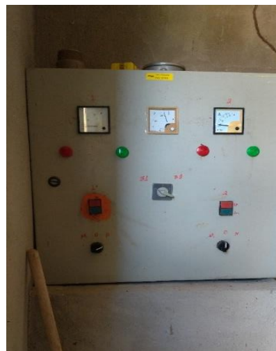
Figura 2.29 - Medidor de energia e quadro de comando do Booster de Santana das Neves Fonte: SEINFRA (2023).
