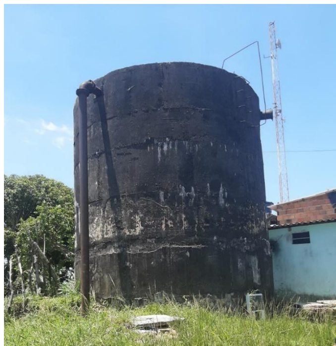
Figura 2.75 - Reservatório Apoiado de Campinas
