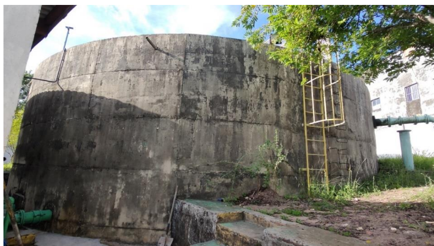
Figura 2.40 - Reservatório Apoiado R5
