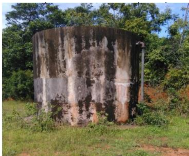
Figura 2.14 - Reservatório Apoiado Canto Galo
