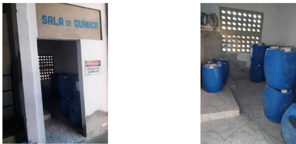
Figura 2.34 - Ponto de recloração localizado na área do RZBII
