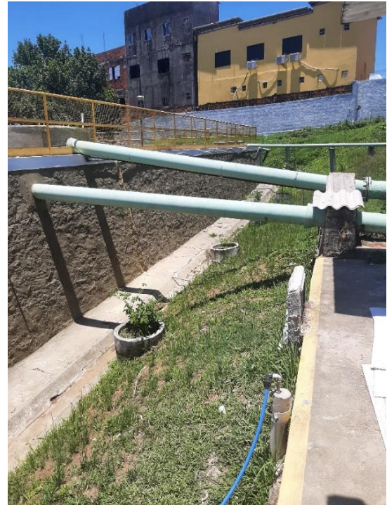
Figura 2.74 - Tubulações de saída do Reservatório Apoiado de São Francisco do Conde
