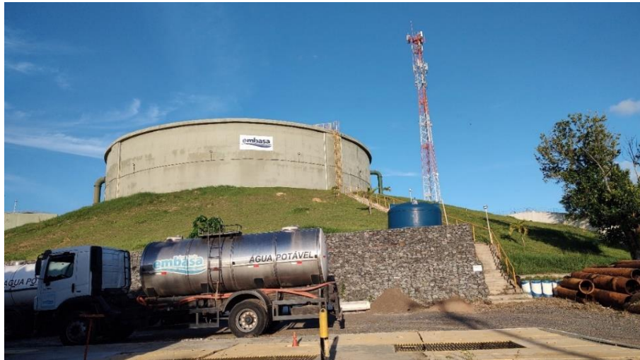
Figura 2.31 - Reservatório Apoiado RZB-II Fonte: GEOHIDRO (2024).
