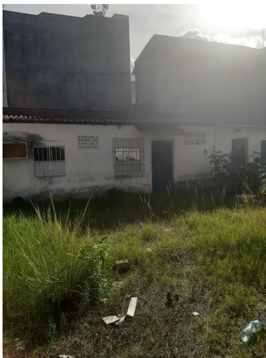
Figura 2.44 - Escritório localizado na área do Reservatório R7
