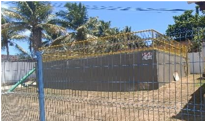
Figura 4.104 - Local onde está instalado o poço CSB1 Fonte: GEOHIDRO (2024).
