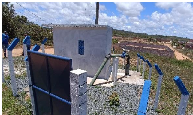
Figura 4.181 - Poço CSB1 Fonte: GEOHIDRO (2024).
