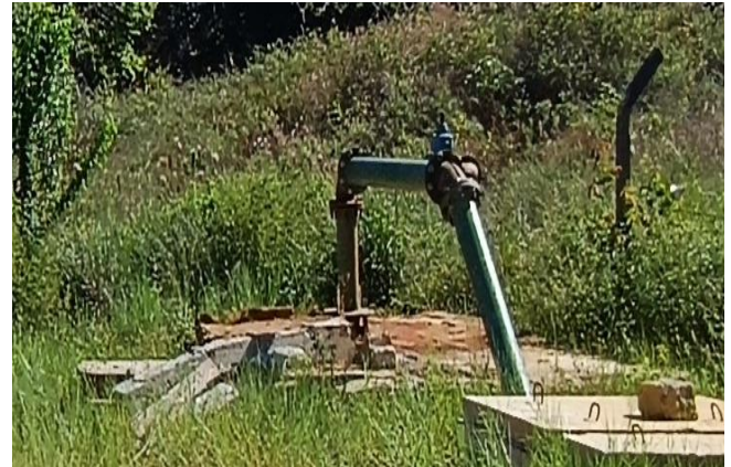
Figura 4.160 - Poço CSB10 SAA Machadinho Norte Fonte: GEOHIDRO (2024)
