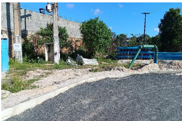
Figura 4.5 - Poço CSB1A localizado na área da ETA da zona Alfa
