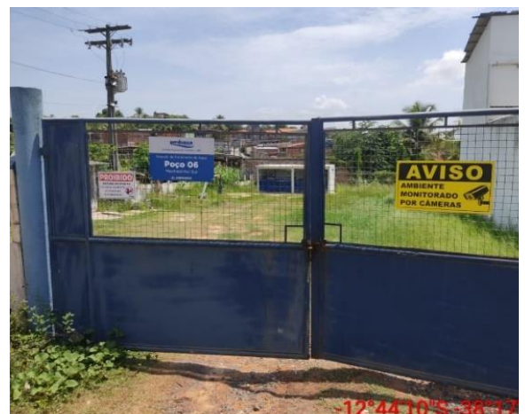
Figura 4.107 - Entrada poço CSB6 Fonte: GEOHIDRO (2024).
