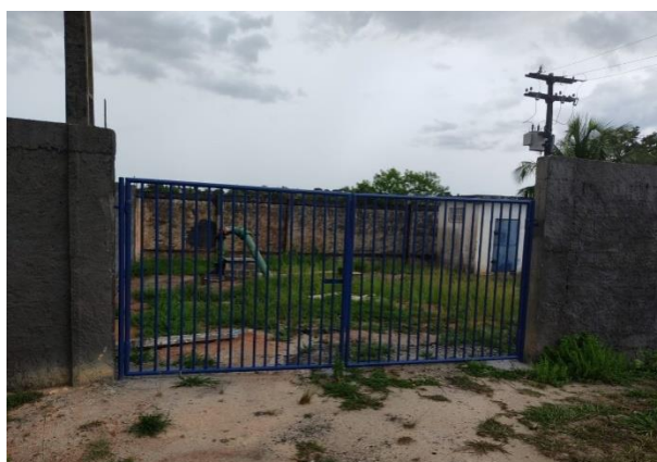
Figura 4.8 - Entrada do poço CSB 4A
