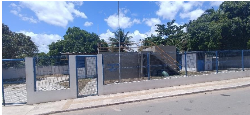
Figura 4.122 - Frente da EEAT e Tanque de Reunião de Machado Sul Fonte: GEOHIDRO (2024).
