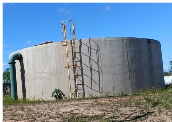
Figura 4.162 - CR1 - Caixa de reunião das vazões dos poços
