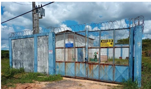
Figura 4.15 - Entrada do poço CSB 11 - Urca Fonte: Embasa (2024).
