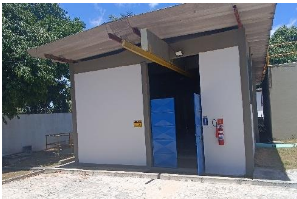
Figura 4.134 - EEAT1 Machadinho Sul - Fachada Fonte: GEOHIDRO (2024).
