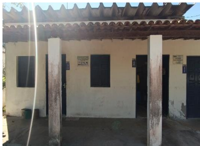
Figura 4.247 - Frente da Casa de Química e Sala do Operador da ETA do SAA Parafuso Fonte: GEOHIDRO (2024).
