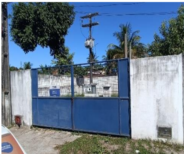
Figura 4.241 - Entrada do poço CSB3 Fonte: GEOHIDRO (2024).
