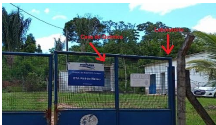
Figura 4.66 - Localização das unidades da ETA Pinhão Manso Fonte: Embasa (2024).
