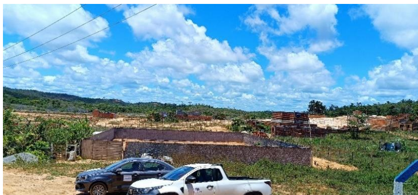
Figura 4.179 - Loteamento ao entorno do poço CSB1 Fonte: GEOHIDRO (2024).
