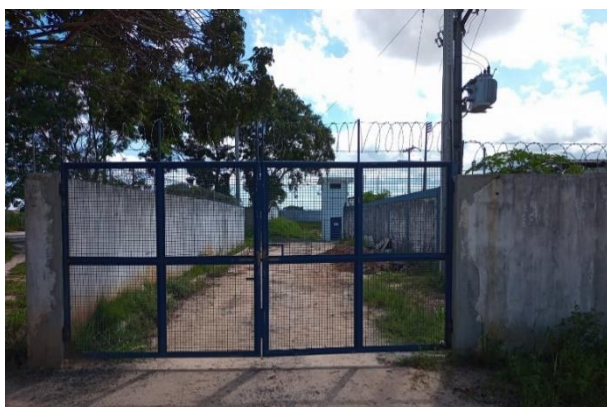
Figura 4.50 - Entrada da nova ETA_Estádio, em fase de implantação – local do poço CSB13.
