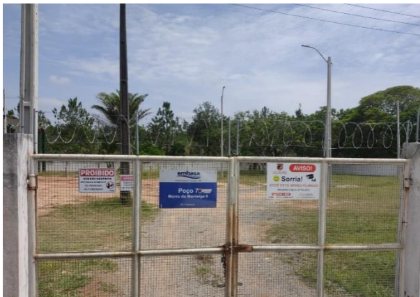
Figura 4.11 - Entrada do poço CSB 7 (Manteiga II) Fonte: Embasa (2024).
