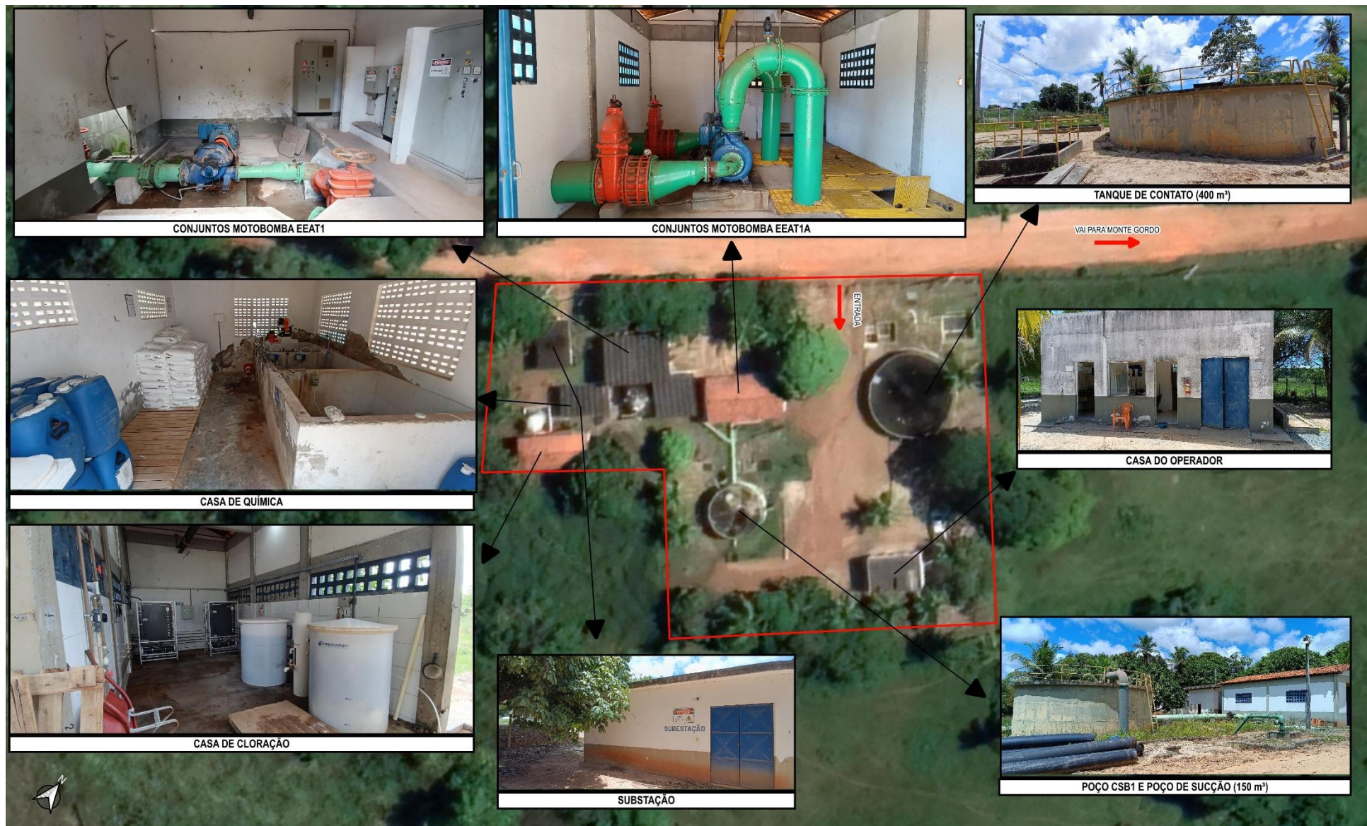
Figura 4.213 - Área da ETA do SIAA Jordão Fonte: Google Satélite (2024).
