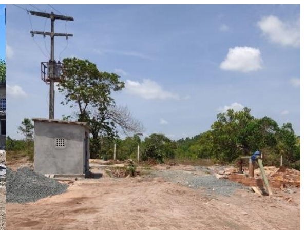
Figura 4.109 - Área do poço CSB8 Fonte: GEOHIDRO (2024).
