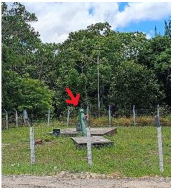
Figura 4.199 - Área do poço CSB3 Fonte: GEOHIDRO (2024).
