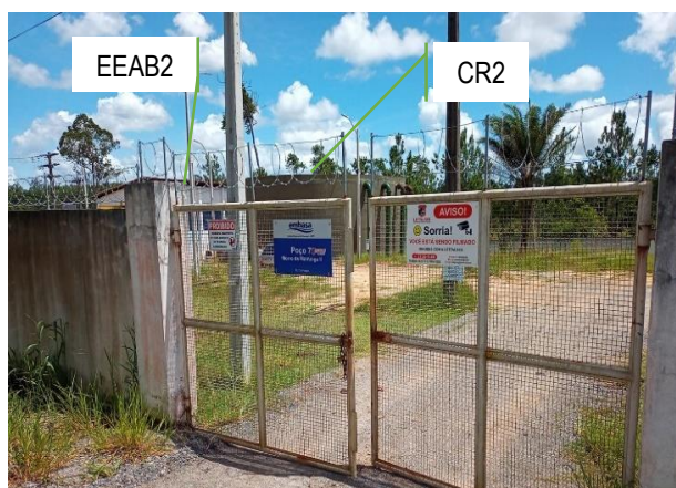
Figura 4.39 - Local de instalação da EEAB2 área do Poço 7, próximo ao Morro da Manteiga Fonte: Embasa (2024).
