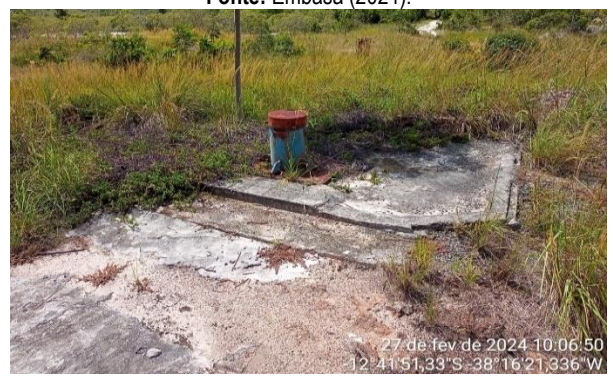
Figura 4.36 - Poço CSB17 - Terrabrás Fonte: Embasa (2024).
