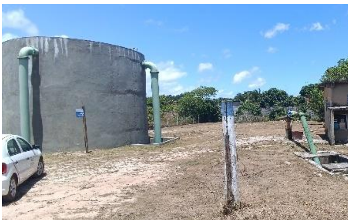
Figura 4.108 - Área de instalação do poço CSB7 Fonte: GEOHIDRO (2024).
