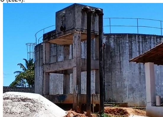
Figura 4.187 - Caixa de reunião (desativada) Fonte: GEOHIDRO (2024).
