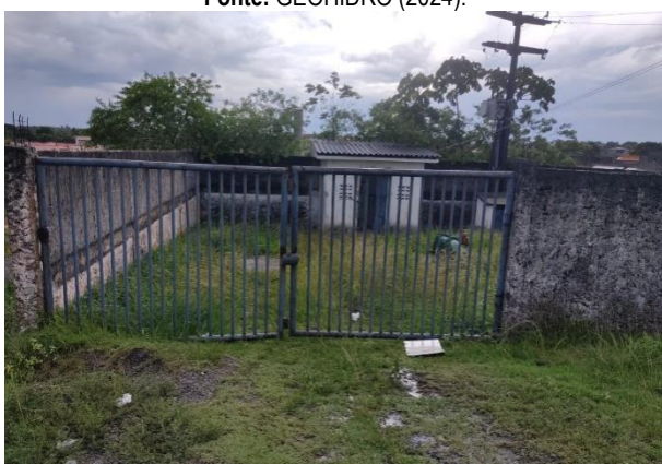
Figura 4.7 - Entrada do poço CSB 3
