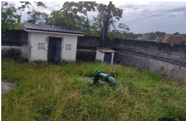
Figura 4.23 - Poço CSB3 localizado na zona Alpha Fonte: Embasa (2024).
