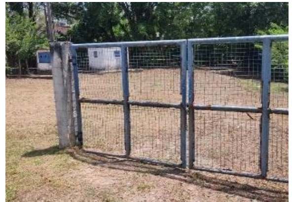
Figura 4.105 - Entrada poço CSB3 Fonte: GEOHIDRO (2024).
