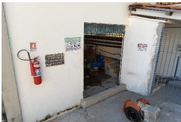
Figura 4.67 - Entrada da EEAT1 (a ser desativada) - Zona Alpha
