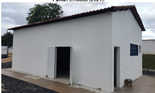
Figura 4.54 - Casa de Cloração - ETA_Estádio. Fonte: Embasa (2024).
