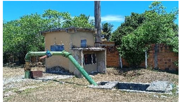
Figura 4.114 - Área de instalação do poço CSB3 Fonte: GEOHIDRO (2024).
