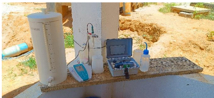
Figura 4.192 - Laboratório do SAA Canto dos Pássaros Fonte: GEOHIDRO (2024).
