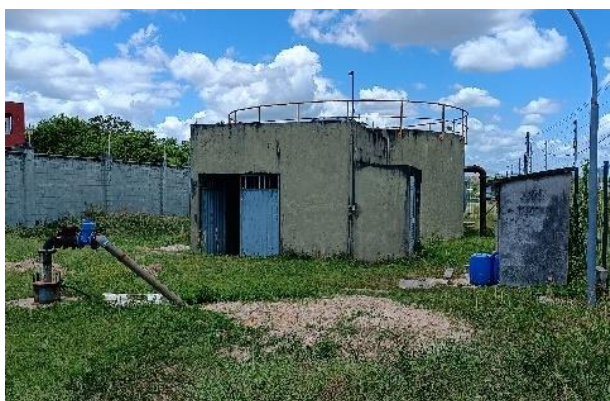
Figura 4.119 - Poço CSB11 Terras Alphavile Fonte: GEOHIDRO (2024).
