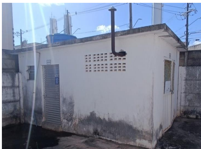
Figura 4.63 - Casa do operador da ETA Terra Brasilis Fonte: GEOHIDRO (2024).
