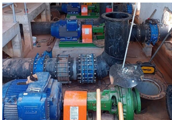
Figura 4.40 - Obra de implantação da nova EEAB2 próximo ao Morro da Manteiga Fonte: Embasa (2024).
