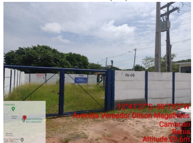
Figura 4.12 - Entrada do poço CSB 8 (Manteiga III) Fonte: Embasa (2024).
