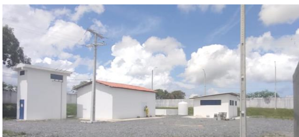
Figura 4.52 - Área da ETA_Estádio em implantação (Casa de Química, Casa de Cloração e Subestação) Fonte: Embasa (2024).
