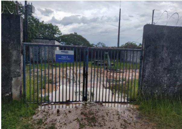
Figura 4.9 - Entrada do poço CSB 5 Fonte: Embasa (2024).
