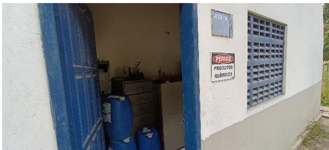
Figura 4.227 - Almoxarifate 2 Fonte: GEOHIDRO (2024).
