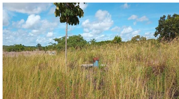
Figura 4.18 - Área de instalação do poço CSB 17 - Terrabrás Fonte: Embasa (2024).
