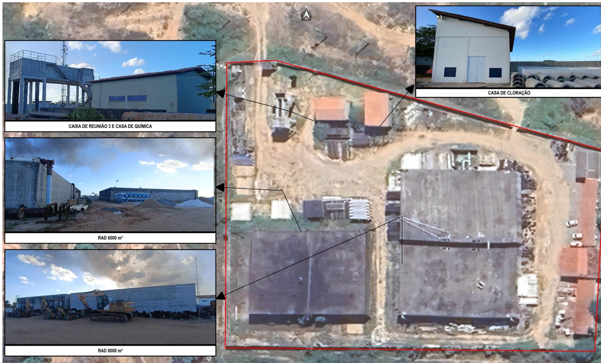
Figura 4.41 - Área da nova ETA Centro/Alpha e unidades existentes Fonte: Google Earth (2024).
