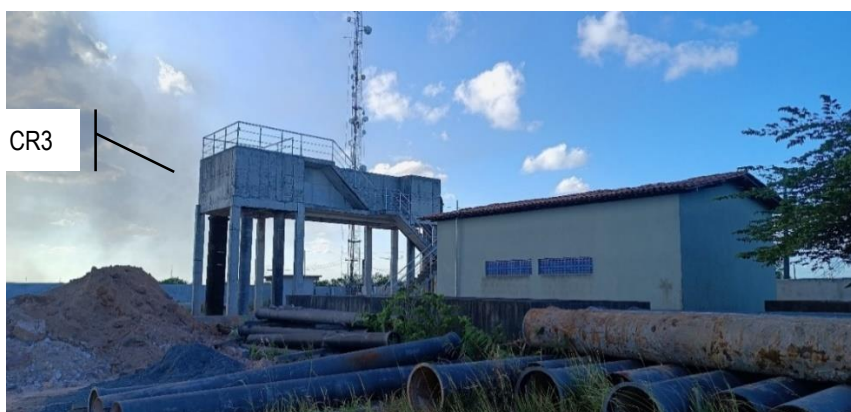
Figura 4.44 - Nova CR3 localizada no Morro da Manteiga (previsão para entrar em operação em abril/2024) Fonte: GEOHIDRO (2024).
