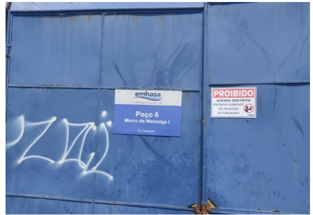
Figura 4.10 - Entrada do poço CSB 6 (Manteiga I) Fonte: Embasa (2024).
