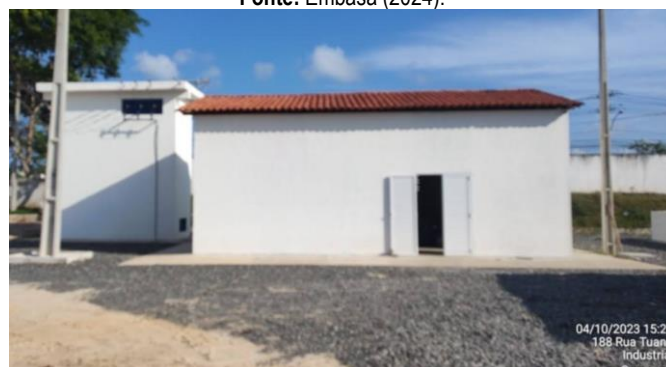
Figura 4.55 - Casa de Química - ETA_Estádio. Fonte: Embasa (2024).
