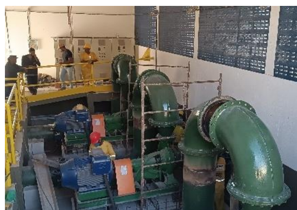
Figura 4.38 - Obra de implantação da nova EEAB1 sendo instalada na zona Alpha Fonte: GEOHIDRO (2024).
