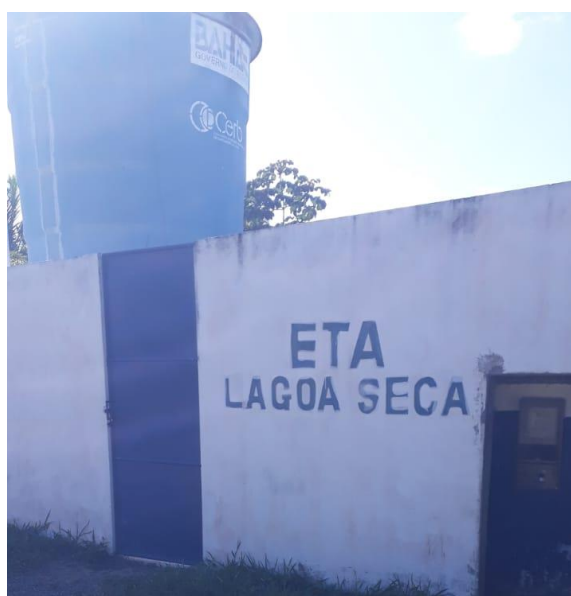
Figura 4.257 - Entrada da ETA do SAA Lagoa Seca
