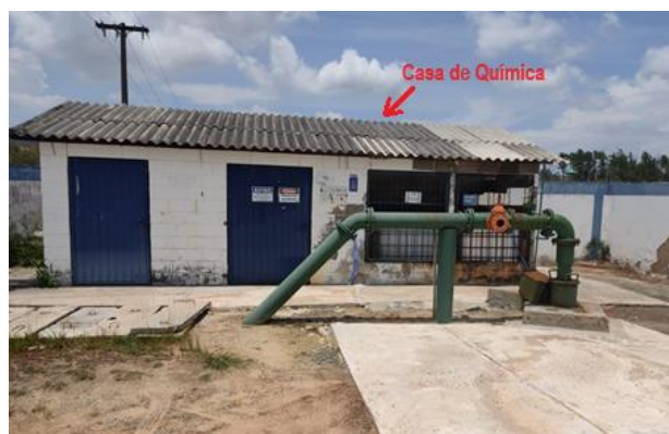
Figura 4.59 - Sistema de tratamento do poço CSB10 Fonte: Embasa (2024).
