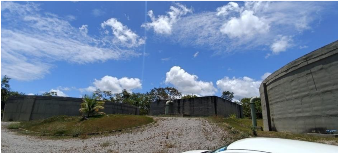
Figura 4.145 - Área de reservação Fonte: GEOHIDRO (2024).
