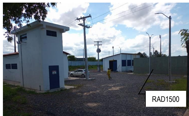
Figura 4.51 - Área da ETA_Estádio em implantação (Subestação, EEAT e RAD 1.500)
