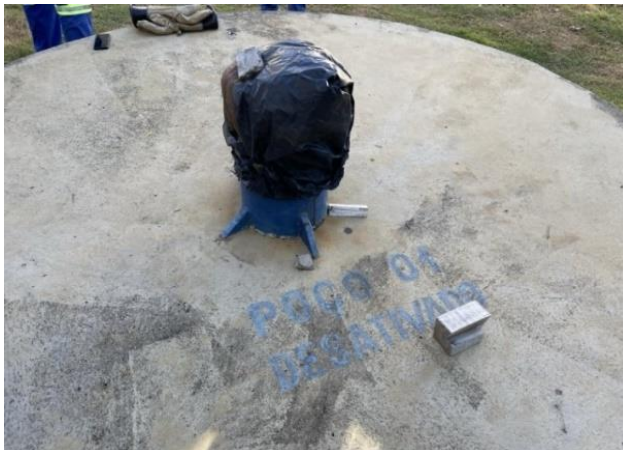
Figura 4.155 - CSB1 Desativado Fonte: GEOHIDRO (2024).
