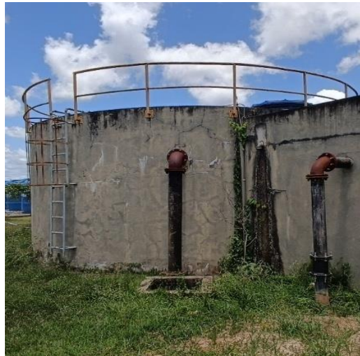
Figura 4.142 - RAD150 - área da ETA Terras Alphaville (desativado) Fonte: GEOHIDRO (2024).
