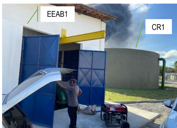
Figura 4.37 - Entrada da EEAB1 em implantação na zona Alpha Fonte: GEOHIDRO (2024).
