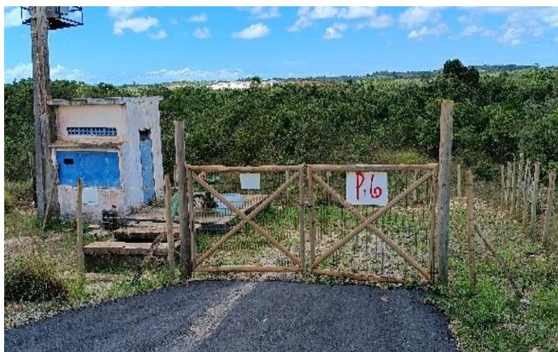
Figura 4.201 - Área do poço CSB6 Fonte: GEOHIDRO (2024).
