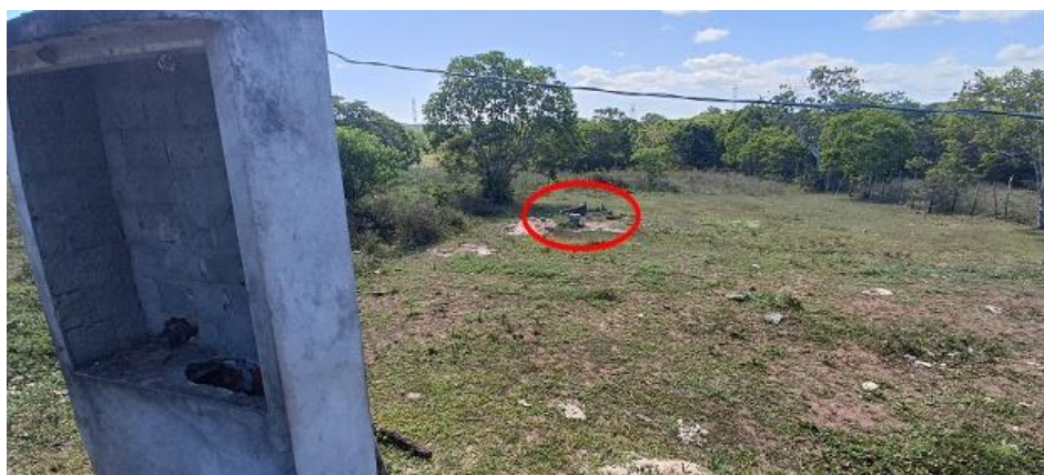
Figura 4.245 - Poço CSB4 (em fase de instalação)
