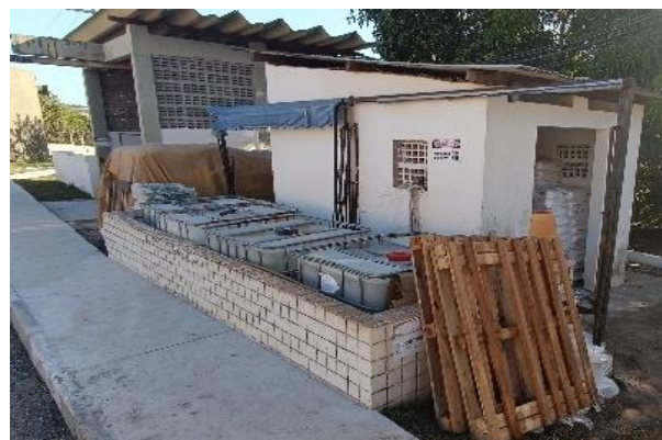
Figura 4.46 - ETA Alpha - Casa de dosagem e armazenamento de barrilha Fonte: GEOHIDRO (2024).
