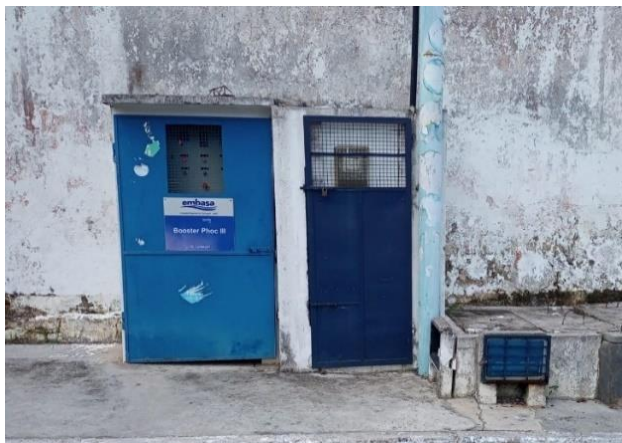
Figura 4.86 - Estrutura de abrigo do booster Phoc III Fonte: Embasa (2024).
