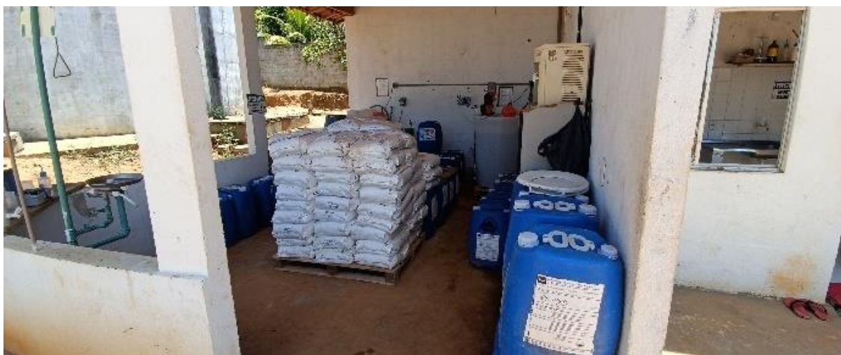
Figura 4.190 - Casa de química e laboratório do SAA Canto dos Pássaros (vista 1) Fonte: GEOHIDRO (2024).
