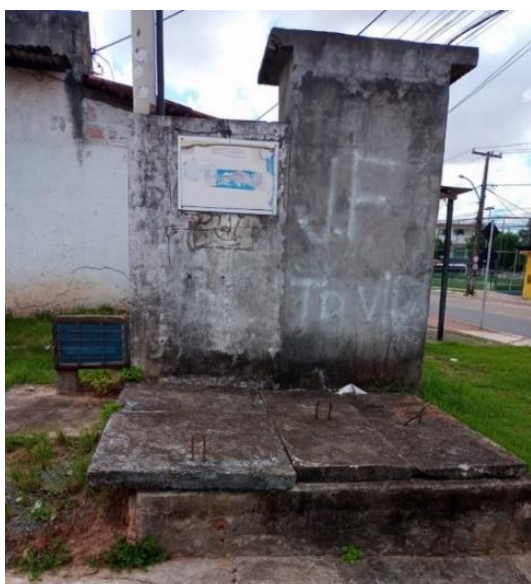
Figura 4.76 - Estrutura de abrigo do booster Alto do Triângulo Fonte: Embasa (2024).
