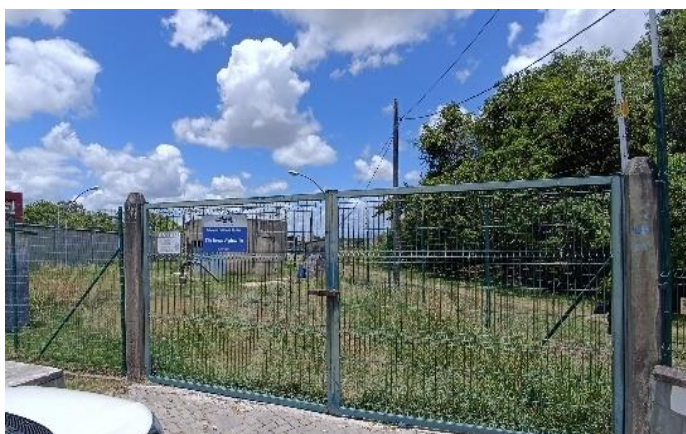
Figura 4.112 - Entrada da área Poço 11 - Terras Alphaville Fonte: GEOHIDRO (2024).
