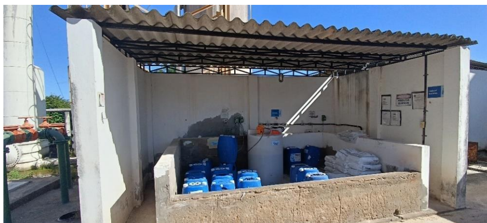
Figura 4.62 - Casa de química da ETA Terra Brasilis Fonte: GEOHIDRO (2024).
