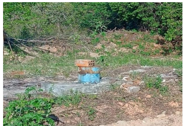
Figura 4.158 - Poço CSB6 do SAA Machadinho Norte Fonte: GEOHIDRO (2024).
