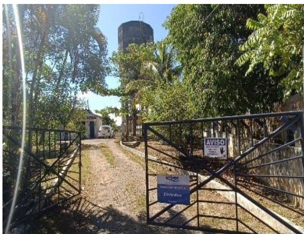
Figura 4.246 - Entrada da ETA do SAA Parafuso Fonte: GEOHIDRO (2024).
