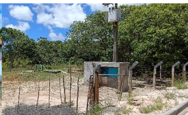
Figura 4.198 - Área do poço CSB2 Fonte: GEOHIDRO (2024).
