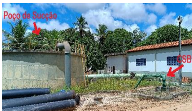
Figura 4.197 - Área do poço CSB1 Fonte: GEOHIDRO (2024).
