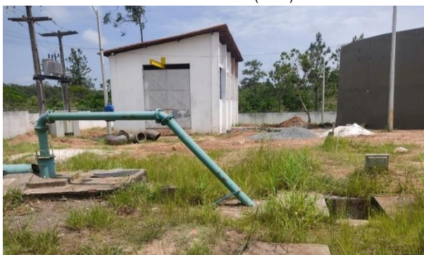
Figura 4.27 - Poço CSB7, localizado na zona Alpha Fonte: Embasa (2024).
