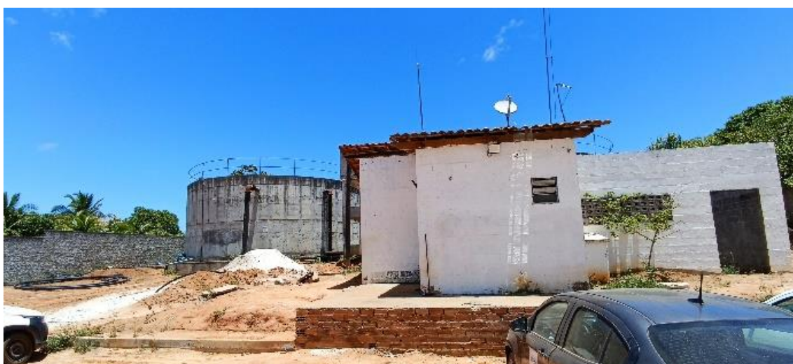
Figura 4.185 - ETA do SAA Canto dos Pássaros Fonte: GEOHIDRO (2024).
