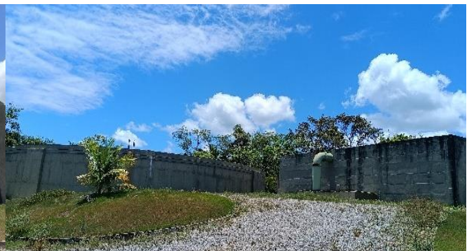
Figura 4.144 - RAD 4000 e RAP 900 Fonte: GEOHIDRO (2024).
