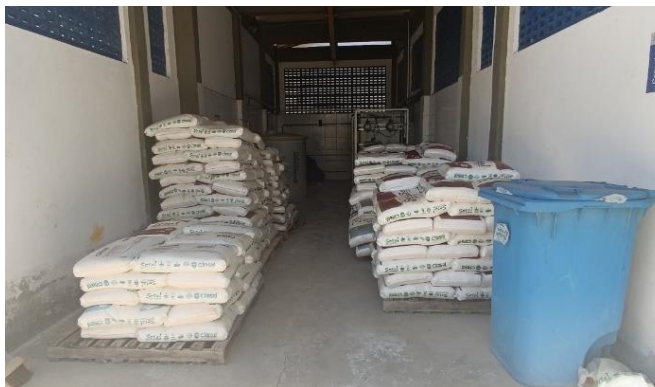
Figura 4.127 - Casa de química, onde está abrigado os equipamentos do sistema hidrogeron Fonte: GEOHIDRO (2024).
