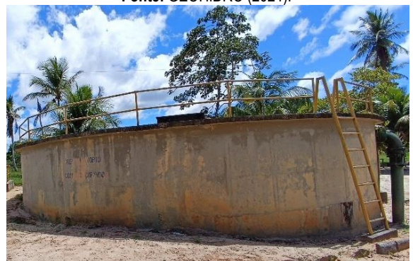
Figura 4.219 - RAD 400 m 3 Fonte: GEOHIDRO (2024).
