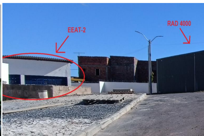
Figura 4.70 - EEAT2 – construída na área de reservação da Zona Estádio.
