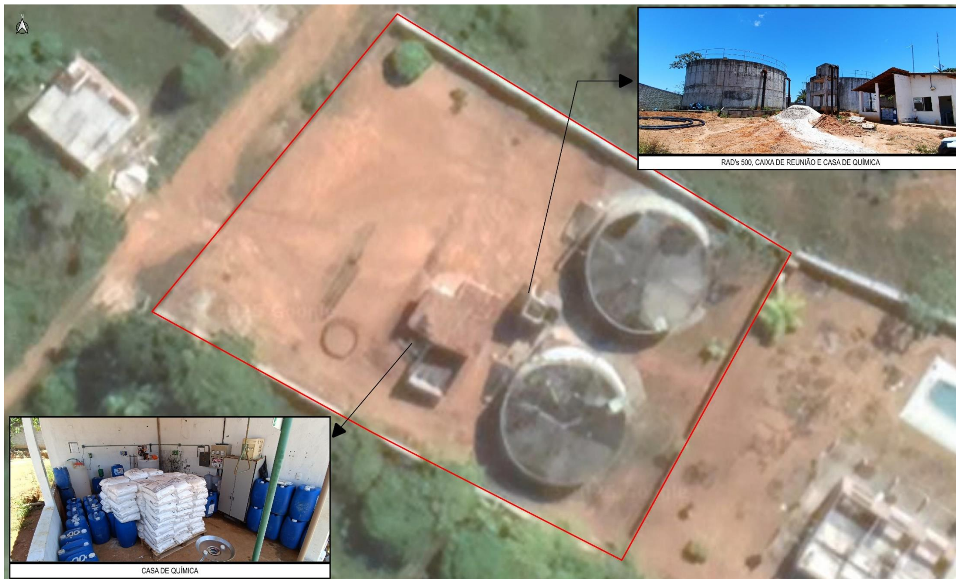
Figura 4.188 - Área da ETA Canto dos Pássaros e unidades existentes Fonte: Google Earth (2024).
