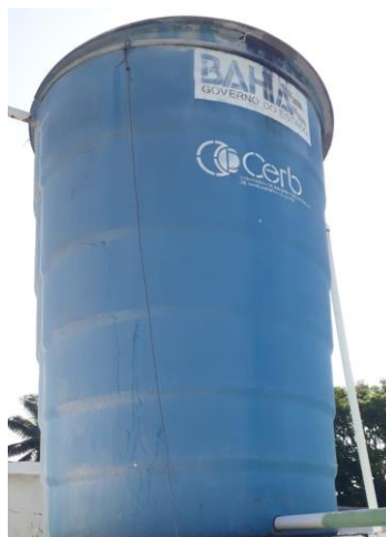
Figura 4.262 - Reservatório localizado na ETA do SAA Lagoa Seca
