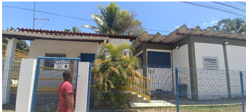
Figura 4.123 - Frente da ETA de Machado Sul Fonte: GEOHIDRO (2024).
