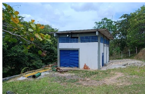
Figura 7.25 – Estação Elevatória de Água Bruta. Fonte: GEOHIDRO (2024).
