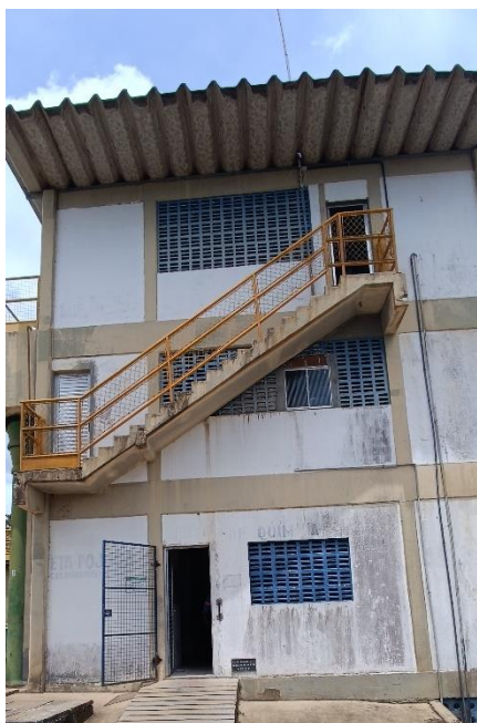
Figura 7.40 – Casa de Química. Fonte: GEOHIDRO (2024).
