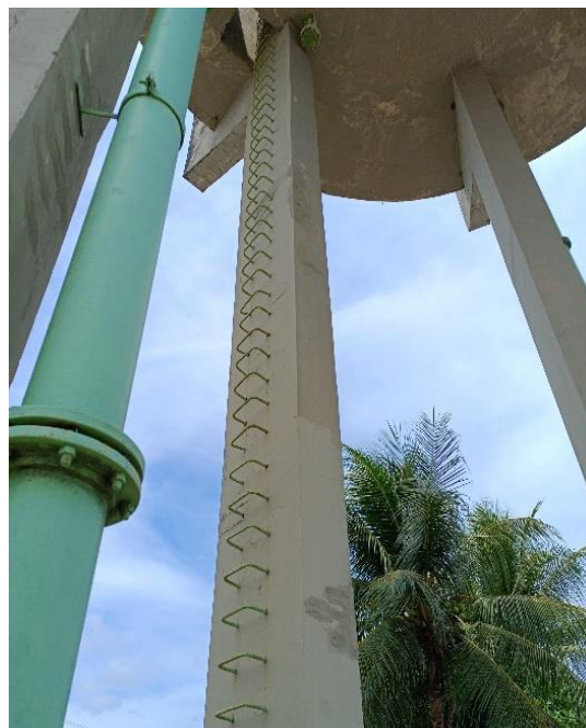
Figura 7.51 – Escada de acesso ao reservatório elevado de distribuição.
