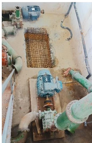
Figura 7.31 – Bomba centrífuga. Fonte: Elaboração própria (2024).
