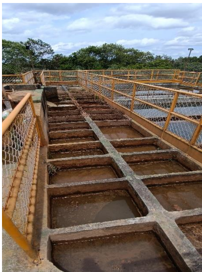
Figura 7.36 – Floclador Fonte: GEOHIDRO (2024).
