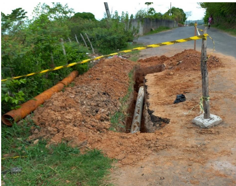
Figura 7.45 – Trecho da AAT sendo trocado pela Embasa.
