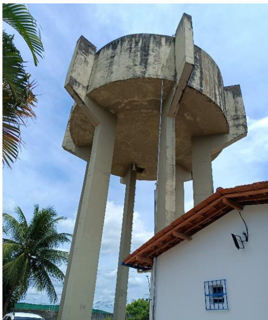
Figura 7.50 – Reservatório elevado de distribuição (300m 3 ).
