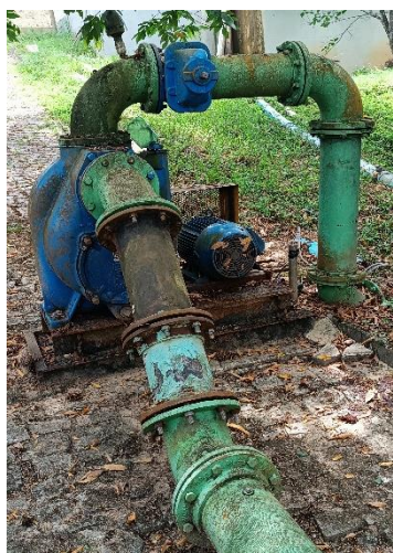
Figura 7.27 – Bomba Autoescorvante. Fonte: GEOHIDRO (2024).
