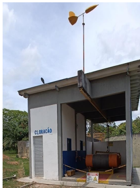
Figura 7.41 – Casa de Cloração. Fonte: GEOHIDRO (2024).
