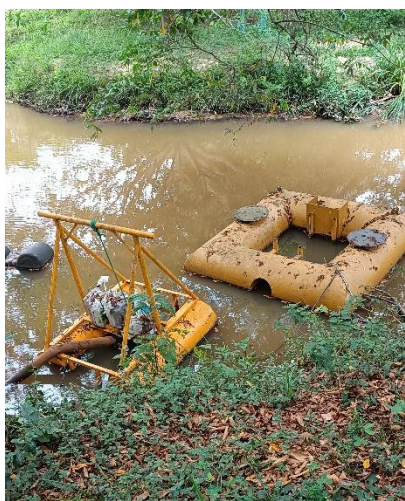
Figura 7.26 – Ponto de captação no rio Una. Fonte: GEOHIDRO (2024).
