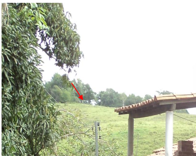
Figura 8.47 - Vista do local do Reservatório de Santo André
