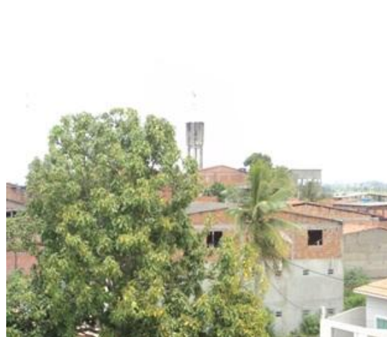
Figura 8.38 - Vista do RED 250m 3 - Desativado Fonte: GEOHIDRO (2024).
