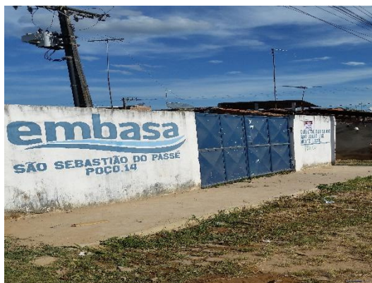
Figura 8.7 - Poço CSB14 – Vista geral do muro, portão e sinalização Fonte: EMBASA (2024).
