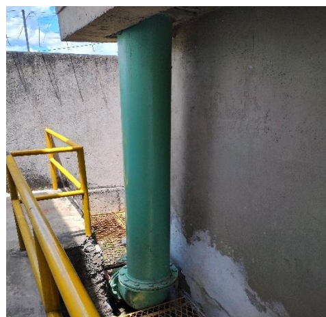
Figura 8.22 - Vista da saída do tubo de água tratada dos filtros Fonte: GEOHIDRO (2024).
