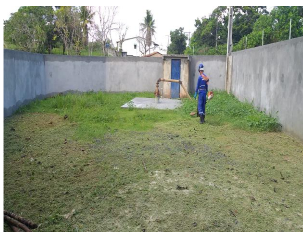
Figura 8.17 - Vista geral das instalações da EEB18 Fonte: EMBASA (2024).
