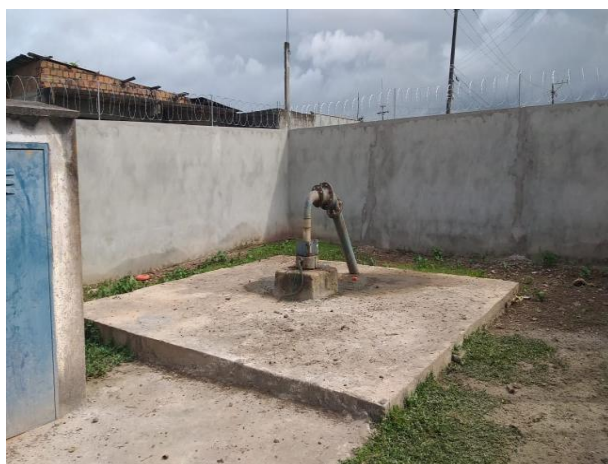
Figura 8.16 - Vista geral das instalações da EEB13. Fonte: EMBASA (2024).
