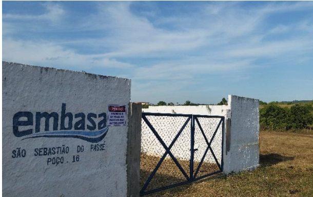
Figura 8.9 - Poço CSB16 – Vista geral do muro, portão e sinalização Fonte: EMBASA (2024).
