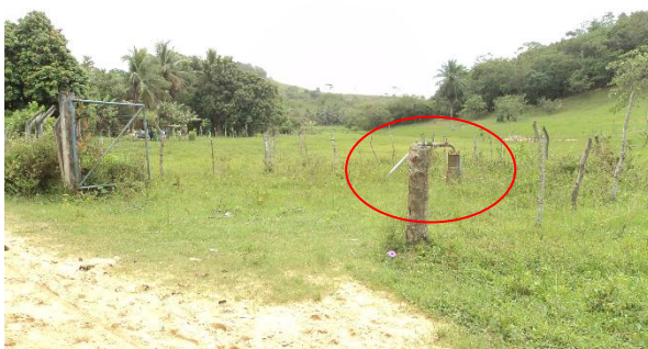
Figura 8.13 - Poço CSB5 – Local da Instalação; falta de portão e conservação do local Fonte: GEOHIDRO (2016).
