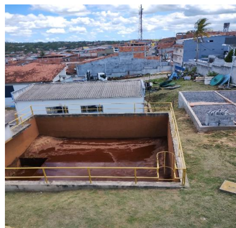
Figura 8.27 - Vista do Tanque de decantação e à direita construção de leito de secagem
