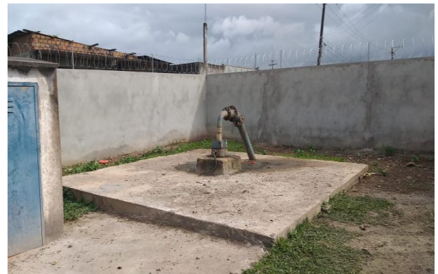
Figura 8.6 - Poço CSB13 – Vista geral da instalação. Proteção com muro e concertina Fonte: EMBASA (2024).
