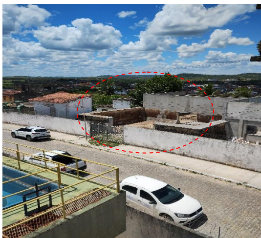
Figura 8.37 - Vista do RAD 1 (2x250m 3 ) - Demolido Fonte: GEOHIDRO (2024).
