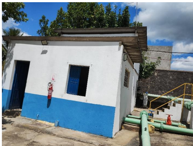
Figura 8.34 - EEAT1 – Vista da Casa de Bombas Fonte: GEOHIDRO (2024)
