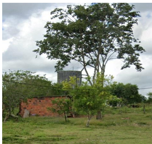
Figura 8.45 - Vista do Reservatório de Jacuípe – Cap. 100m 3 Fonte: Geohidro (2014).
