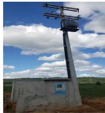
Figura 8.12 - Poço CSB19 – Vista da área, ainda sem muro de proteção Fonte: EMBASA (2024).
