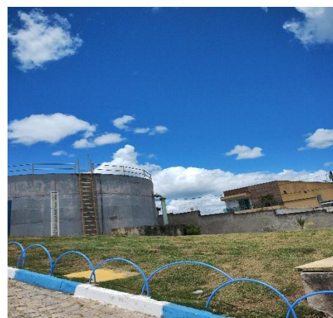
Figura 8.29 - Vista do RAD3-500m³ que funciona como poço de sucção da EEAT-2
