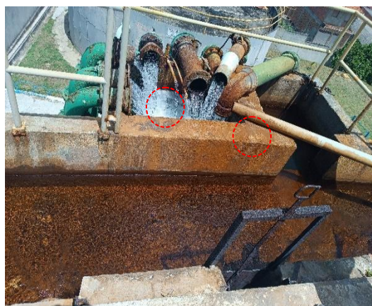
Figura 8.19 - Vista do topo da Torre de chegada de água bruta. Destaque - aplicação de cloro e flúor e tubo de água de reaproveitamento. Fonte: GEOHIDRO (2024).
