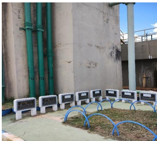
Figura 8.18 - Vista da Torre de chegada de água bruta e pontos de coleta de cada poço. Fonte: GEOHIDRO (2024).
