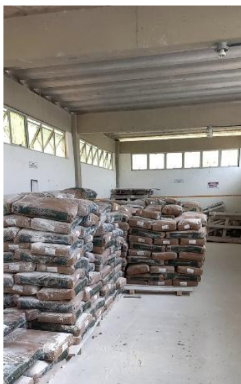
Figura 9.97 - Vista geral do depósito de hidróxido de cálcio (cal hidratada) Fonte: GEOHIDRO (2024).
