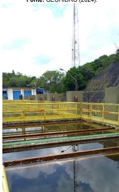
Figura 9.81 - Vista geral de topo dos filtros russos do módulo 2 (6 filtros) Fonte: GEOHIDRO (2024).
