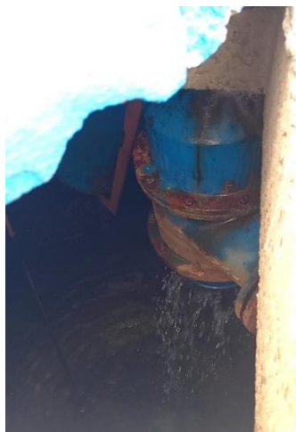
Figura 9.217 - Tubulação de entrada no reservatório Fonte: GEOHIDRO (2024).
