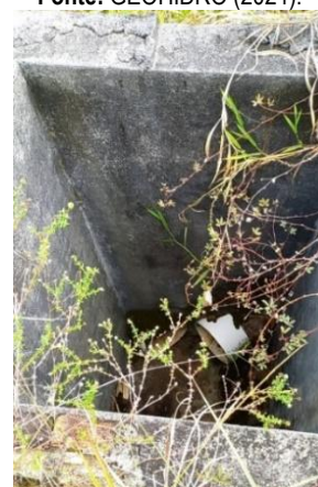
Figura 9.206 - Caixa da descarga de fundo do reservatório Fonte: GEOHIDRO (2024).
