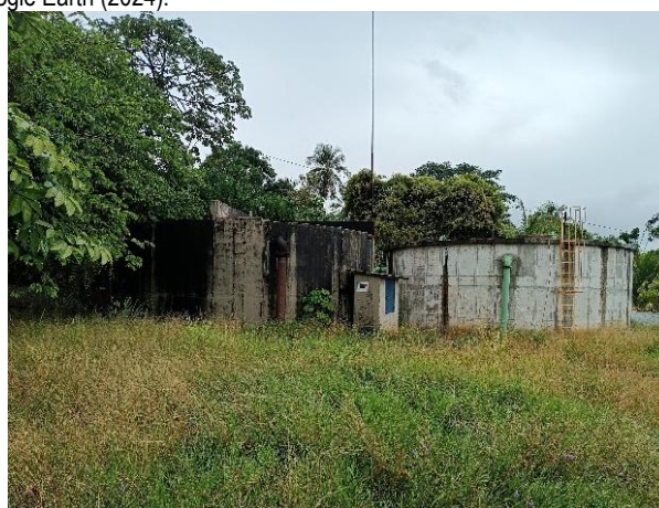
Figura 9.221 - Vista geral do RAD 12, à esquerda o novo reservatório Fonte: GEOHIDRO (2024).
