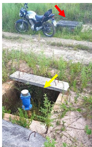
Figura 9.65 - Caixas das ventosas situadas após a caixa de derivação. Em amarelo a ventosa do AAB2 e em vermelho, a caixa da ventosa do AAB1 Fonte: GEOHIDRO (2024).
