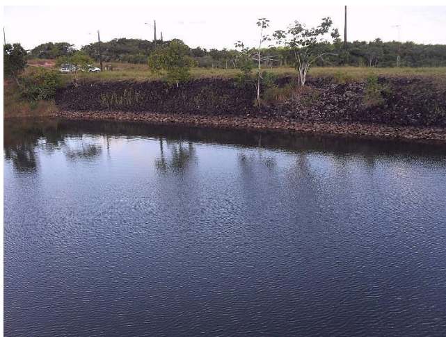
Figura 7.23 – Vista de montante do barramento (ombreira esquerda)
