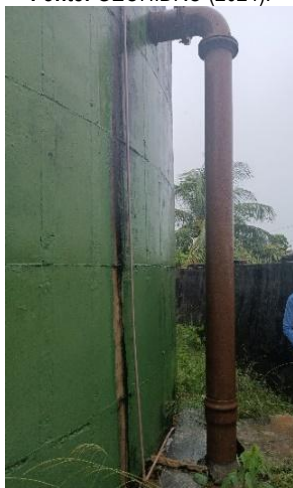
Figura 9.233 - Vista da tubulação do extravasor do reservatório Fonte: GEOHIDRO (2024).
