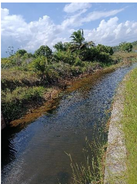
Figura 9.23 - Vista do canal de aproximação do vertedor da barragem Fonte: GEOHIDRO (2024).
