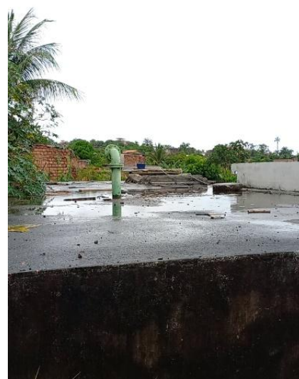
Figura 9.227 - Vista da laje e da tubulação de ventilação do reservatório Fonte: GEOHIDRO (2024).
