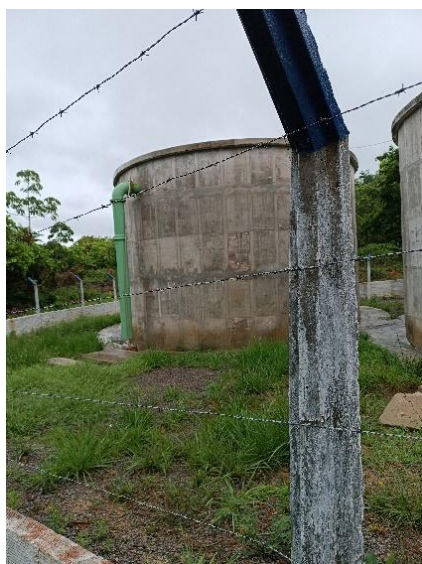
Figura 9.238 - Vista do reservatório e do extravasor em lado oposto à tubulação de entrada Fonte: GEOHIDRO (2024).
