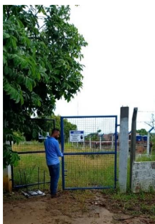
Figura 9.220 - Entrada do centro de reservação RAD 12 – Gameleira Fonte: GEOHIDRO (2024).
