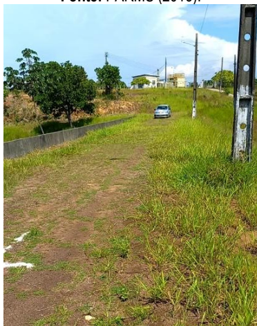
Figura 9.7 - Vista do coramento da barragem e ao fundo a ETA de Caçães Fonte: GEOHIDRO (2024).
