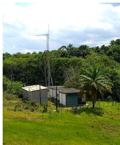
Figura 9.10 - Vista da elevatória de água bruta a jusante do barramento Fonte: GEOHIDRO (2024).
