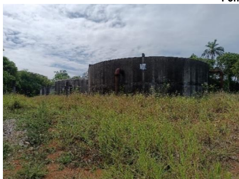
Figura 9.203 - Vista dos reservatórios RAP I, II e III do centro de reservação da Faustina Fonte: GEOHIDRO (2024).
