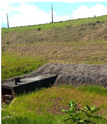
Figura 9.11 - Vista do talude de jusante do barramento com a estrutura de descarga de fundos e os drenos Fonte: GEOHIDRO (2024).
