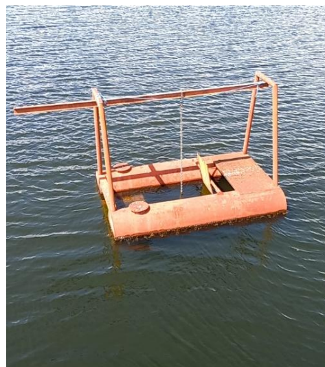
Figura 9.42 - Estrutura flutuante existente para captação de água do SIAA de Vera Cruz e Itaparica Fonte: GEOHIDRO (2024).
