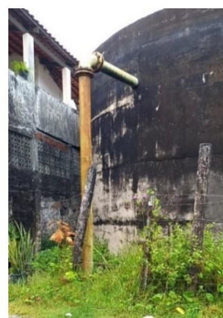
Figura 9.209 - Vista da tubulação do extravasor no reservatório
