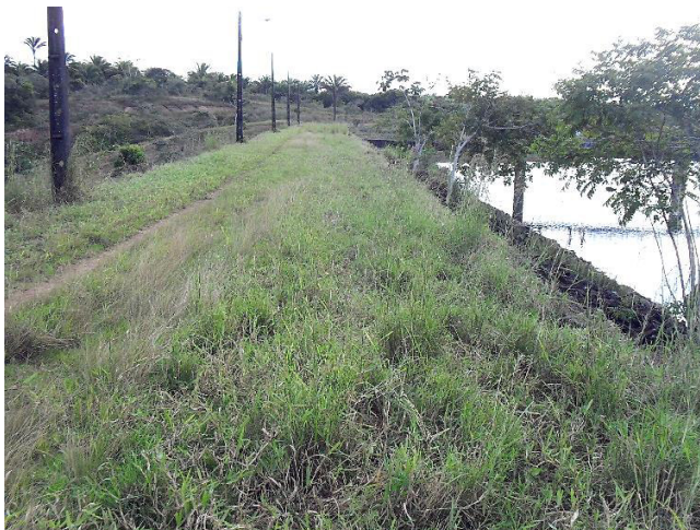
Figura 7.21 – Crista da barragem, vista da ombreira esquerda
