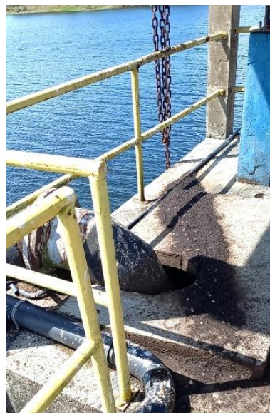
Figura 9.44 - Detalhe da tubulação da adutora de água bruta em direção à EEAB
