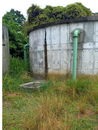
Figura 9.223 - Tubulações do extravasor à esquerda e de entrada à direita do novo reservatório Fonte: GEOHIDRO (2024).
