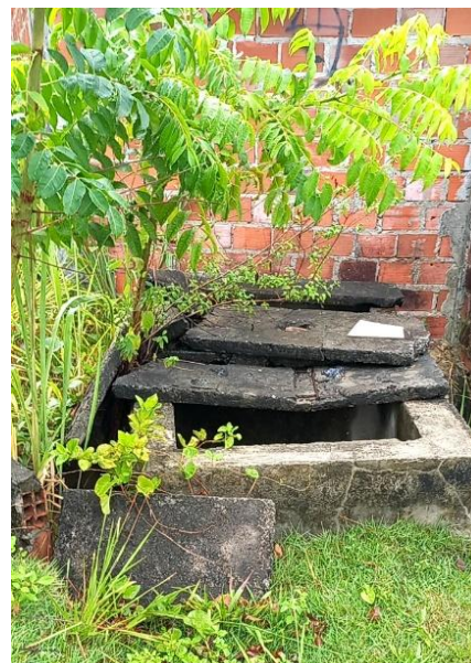
Figura 9.211 - Caixa da tubulação de entrada no reservatório Fonte: GEOHIDRO (2024).
