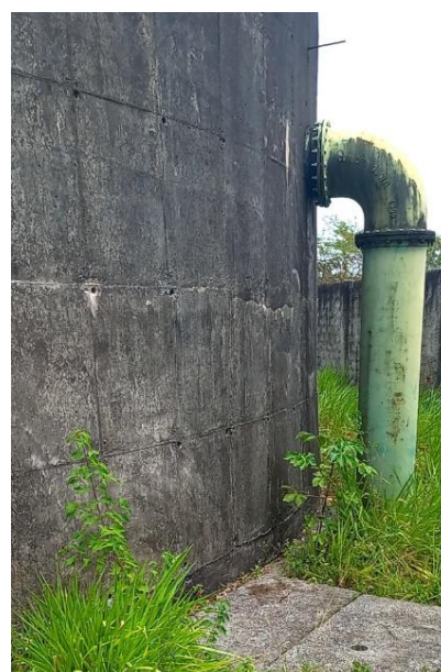
Figura 9.189 - Extravasor de um dos reservatórios Fonte: GEOHIDRO (2024).
