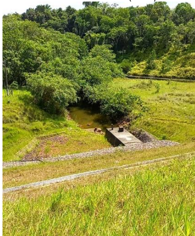
Figura 9.9 - Vista do talude de jusante do barramento com vista para a descarga de fundo na parte inferior com estrutura de canaletas de drenagem Fonte: GEOHIDRO (2024).
