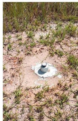
Figura 9.12 - Detalhe de um dos piezômetros instalados na crista da barragem Tapera. Fonte: GEOHIDRO (2024).
