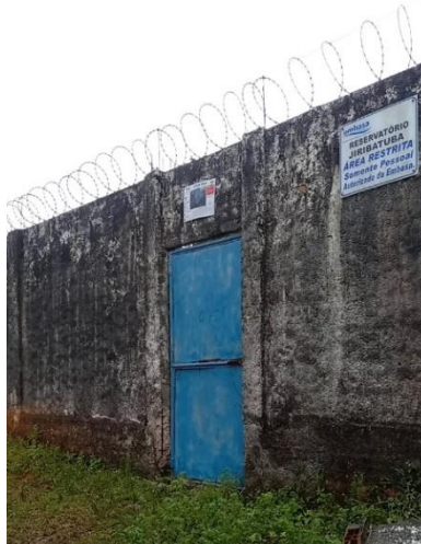
Figura 9.172 - Vista da área de entrada do RAD 2 – Jiribatuba Fonte: GEOHIDRO (2024).
