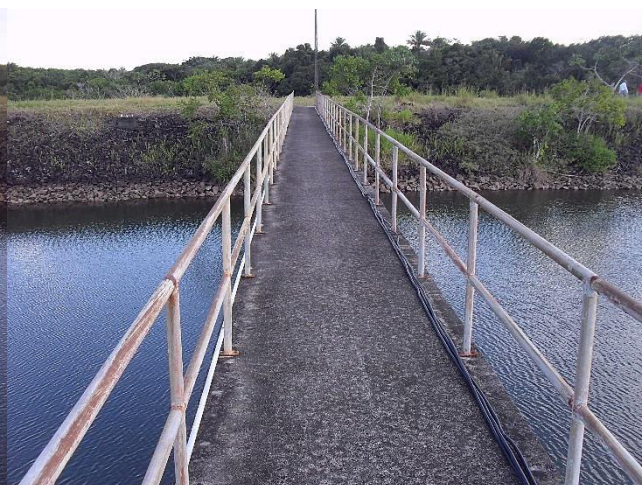
Figura 7.24 – Vista de montante do barramento (centro)
