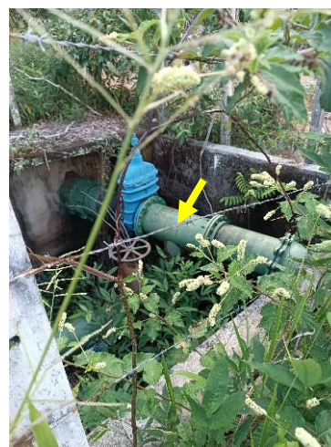
Figura 9.64 - Em amarelo, o detalhamento da derivação existente na AAB1, originando a AAB2 Fonte: GEOHIDRO (2024).
