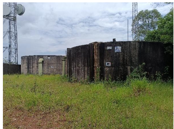
Figura 9.183 - Vista dos reservatórios RAD 3 Fonte: GEOHIDRO (2024).
