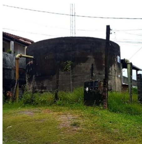
Figura 9.208 - Vista geral do reservatório RAD 10
