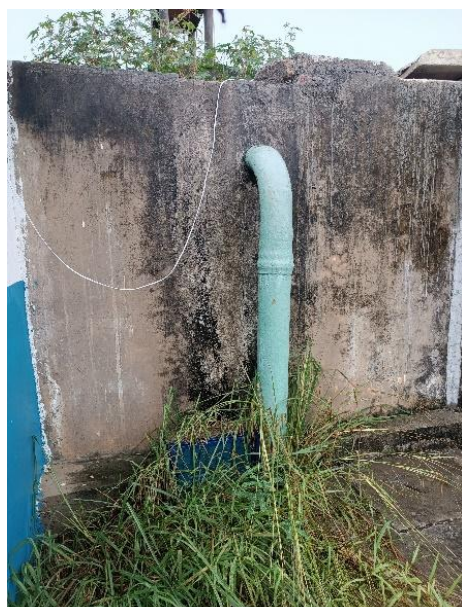
Figura 9.228 - Tubulação de entrada no reservatório Fonte: GEOHIDRO (2024).
