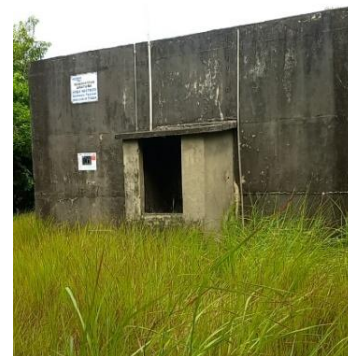
Figura 9.192 - Vista do reservatório RAD 4 – Aratuba Fonte: GEOHIDRO (2024).
