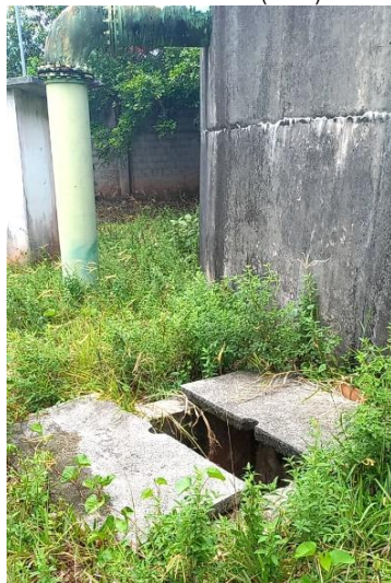
Figura 9.174 - Vista da tubulação do extravasor do reservatório Fonte: GEOHIDRO (2024).
