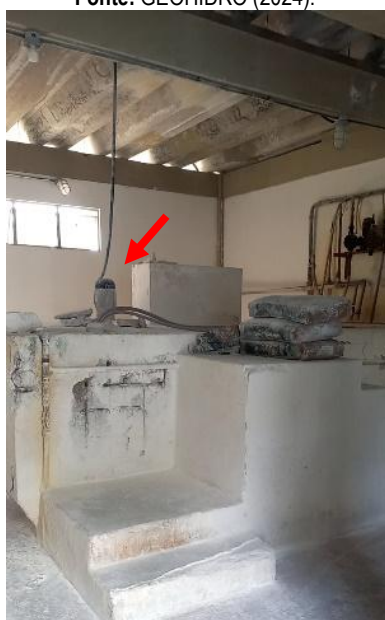
Figura 9.99 - Tanque de mistura de hidróxido de cálcio com o misturador mecânico de eixo vertical Fonte: GEOHIDRO (2024).
