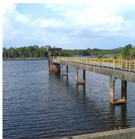
Figura 9.14 - Ponte de acesso à Torre de Tomada. Fonte: GEOHIDRO (2024).
