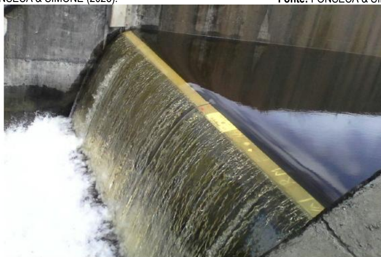
Figura 9.22 - Estrutura do vertedor com fusegate em funcionamento na barragem do rio Tapera
