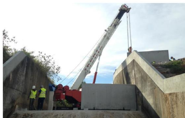
Figura 9.21 - Instalação dos fusegates da barragem do Rio Tapera (2016)
