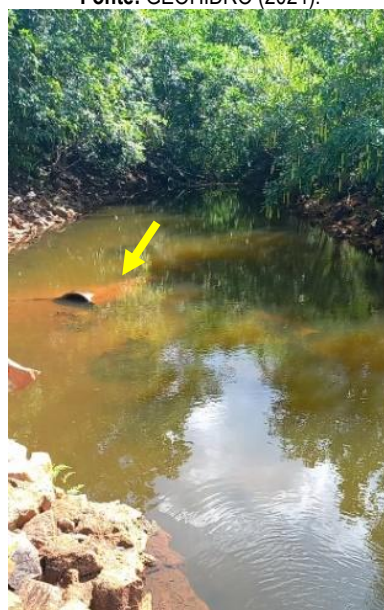
Figura 9.30 - Vista da bacia de dissipação a jusante da descarga de fundo da barragem Tapera. Fonte: GEOHIDRO (2024).
