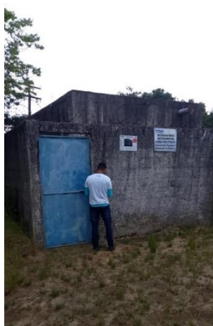
Figura 9.167 - Entrada da área do reservatório RAD 1
