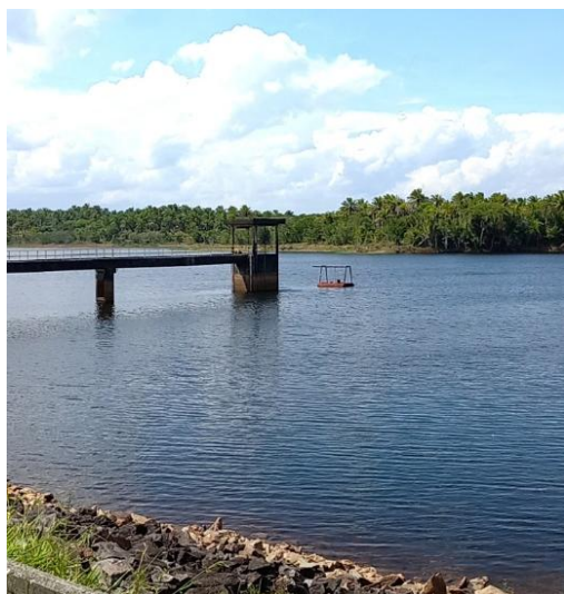
Figura 9.41 - Vista geral da torre de tomada e da captação flutuante do SIAA de Vera Cruz e Itaparica Fonte: GEOHIDRO (2024).
