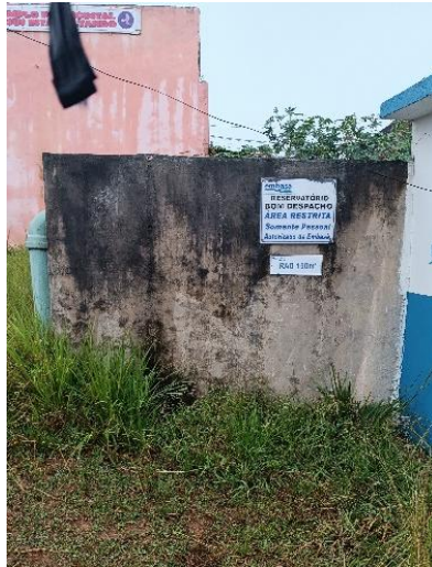
Figura 9.150 - RAD Bom Despacho que funciona como poço de sucção da EEAT3 e tubulação de entrada Fonte: GEOHIDRO (2024).
