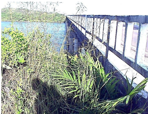
Figura 9.69 - Vista geral da travessia da AAB1 pela Ponte do Funil Fonte: PARMS (2016).
