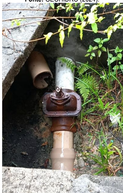
Figura 9.212 - Tubulação de entrada no reservatório Fonte: GEOHIDRO (2024).
