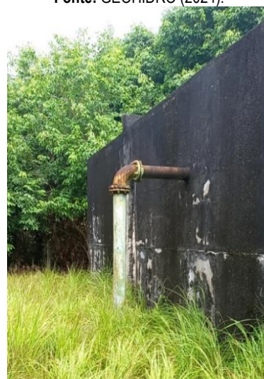
Figura 9.194 - Vista do extravasor do reservatório Fonte: GEOHIDRO (2024).
