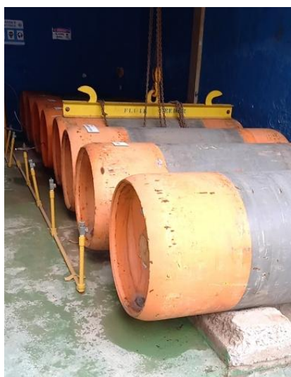
Figura 9.103 - Vista dos cilindros de cloro-gás.
