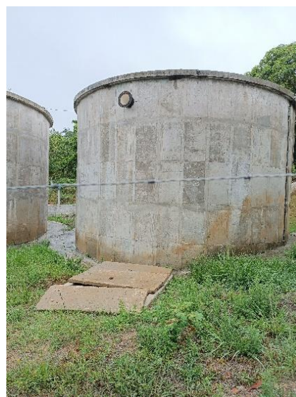
Figura 9.239 - Vista da entrada para nova tubulação e da caixa da válvula de descarga Fonte: GEOHIDRO (2024).
