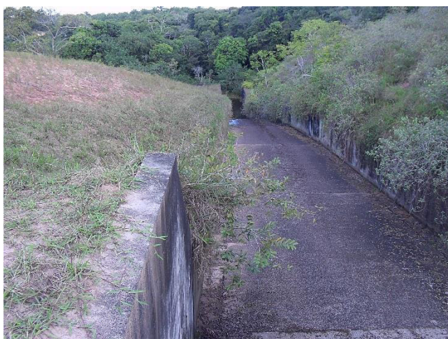
Figura 7.27 – Canal do vertedor
