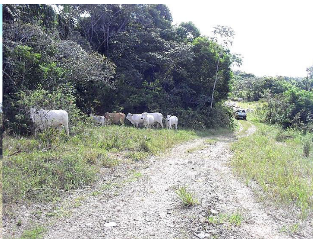
Figura 7.15 – Acesso à Barragem Tapera em área rural
