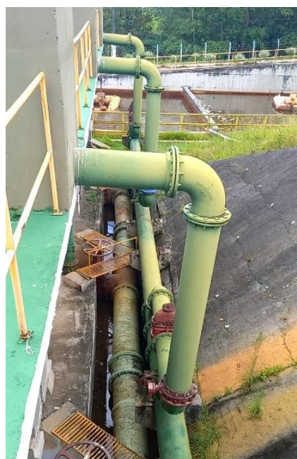
Figura 9.79 - Barrilete de distribuição da água bruta e do barrilete da descarga de fundo dos filtros no módulo 1 (4 filtros) Fonte: GEOHIDRO (2024).
