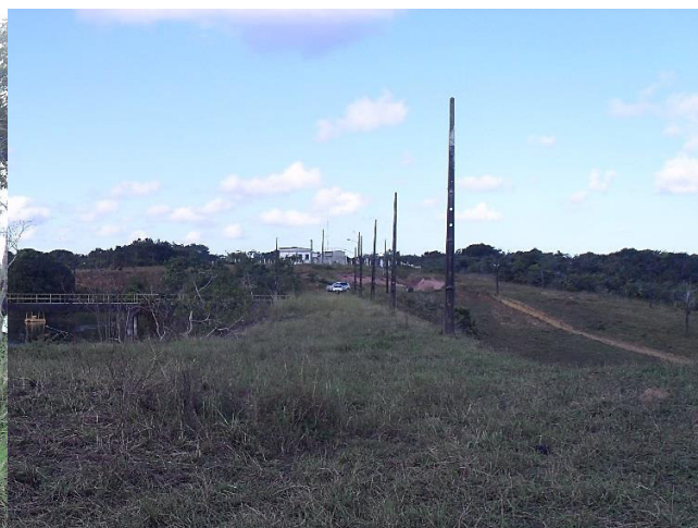
Figura 7.22 – Barragem vista da ombreira esquerda
