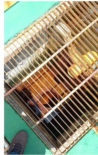
Figura 9.89 - Vista da calha de coleta da água filtrada com vertedouro fora de operação. Fonte: GEOHIDRO (2024).
