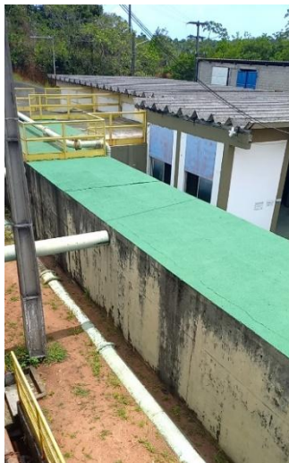
Figura 9.90 - Vista da parte superior do tanque de contato existente Fonte: GEOHIDRO (2024).
