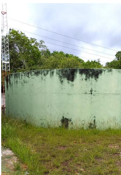
Figura 9.148 - Reservatório comunicante com o poço de sucção Fonte: GEOHIDRO (2024).
