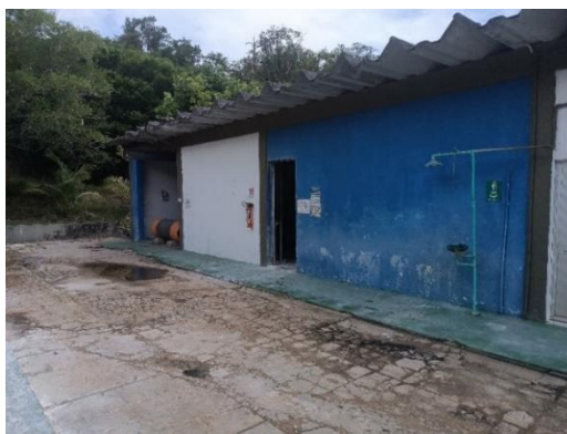
Figura 9.92 - Entrada da Casa de Química com vista do depósito de gás cloro Fonte: GEOHIDRO (2024).
