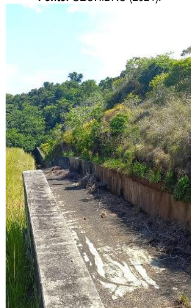
Figura 9.26 - Vista geral do canal de jusante do extravasor, após o vertedor Fonte: GEOHIDRO (2024).
