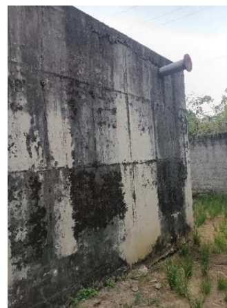
Figura 9.170 - Vista do extravasor na parte superior do reservatório Fonte: GEOHIDRO (2024).
