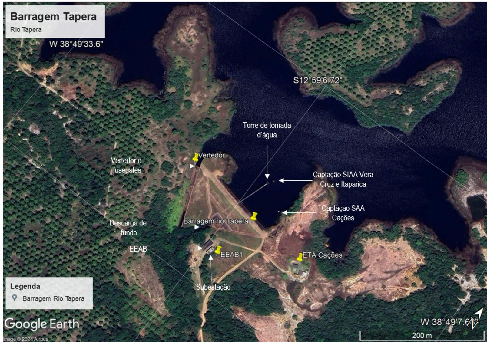
Figura 9.4 - Vista da Barragem Tapera e do reservatório Fonte: Imagem Google Earth (2023).
