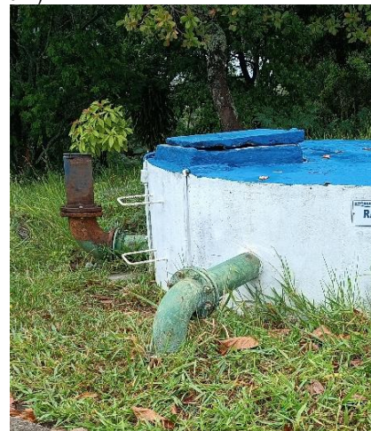
Figura 9.216 - Vista da tubulação de entrada e do extravasor do reservatório Fonte: GEOHIDRO (2024).
