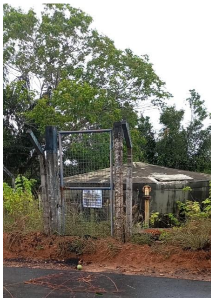
Figura 9.198 - Reservatório RAD 6 localizado às margens da estrada para a localidade de Ponta Grossa Fonte: GEOHIDRO (2024).
