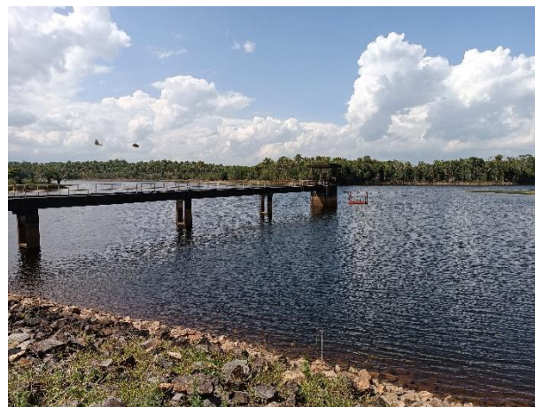
Figura 9.8 - Vista do lago da barragem do Tapera e da torre de tomada d' água Fonte: GEOHIDRO (2024).
