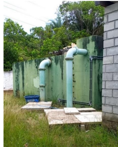
Figura 9.139 - Vista do poço de sucção da EEAT2 com as adutoras de chegada Fonte: GEOHIDRO (2024).
