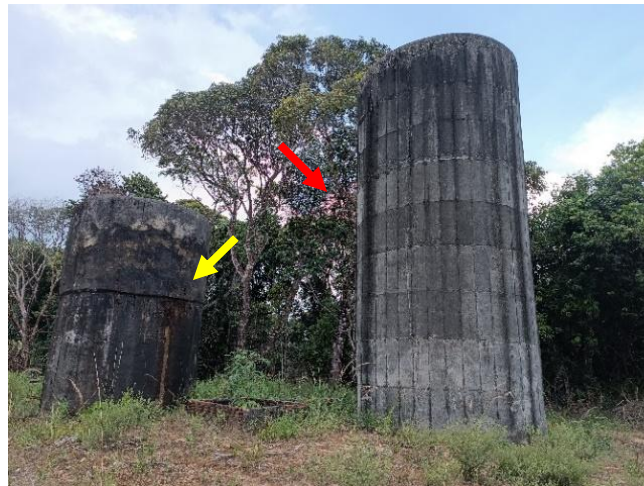
Figura 9.68 - Vista frontal dos standpipes instalados - standpipe da AAB1 (em amarelo) e o standpipe da AAB2 (em vermelho) Fonte: GEOHIDRO (2024).
