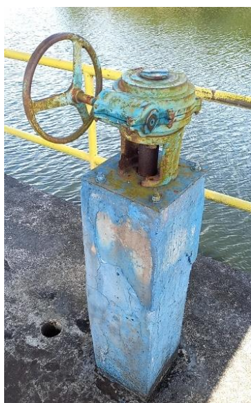
Figura 9.45 - Registro de manobra para a captação flutuante
