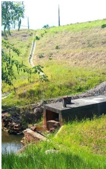
Figura 9.27 - Vista da descarga de fundo da barragem Tapera. Fonte: GEOHIDRO (2024).
