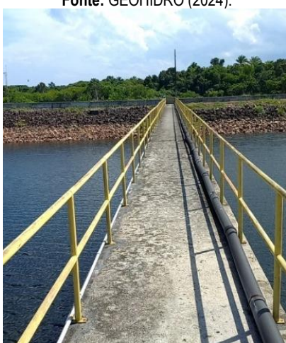
Figura 9.15 - Passarela de acesso à torre de tomada d'água do lago Fonte: GEOHIDRO (2024).
