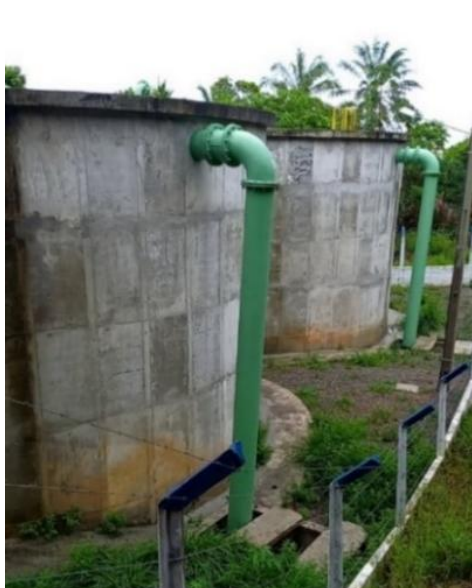
Figura 9.236 - Reservatórios do RAD 17 – Mar Grande/Morro do Gato e tubulações de entrada Fonte: GEOHIDRO (2024).
