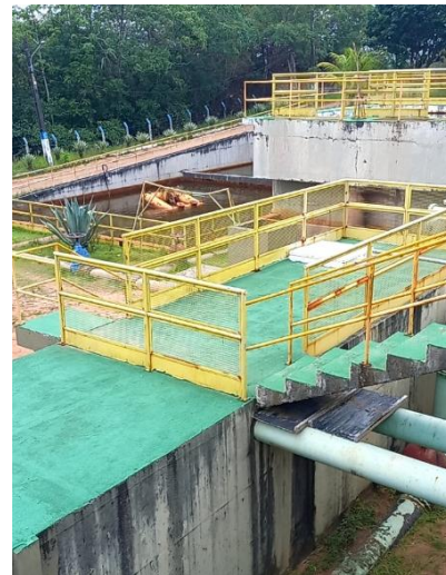
Figura 9.91 - Vista do acesso para a parte interna do tanque de contato e das tubulações de entrada no tanque Fonte: GEOHIDRO (2024).
