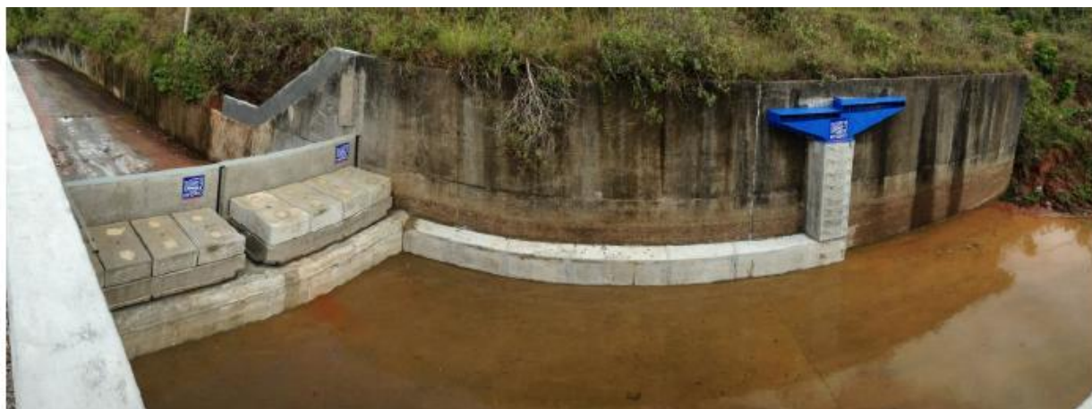
Figura 9.19 - Vista do Fusegate e da chaminé de alimentação – Barragem Rio Tapera (2016)
