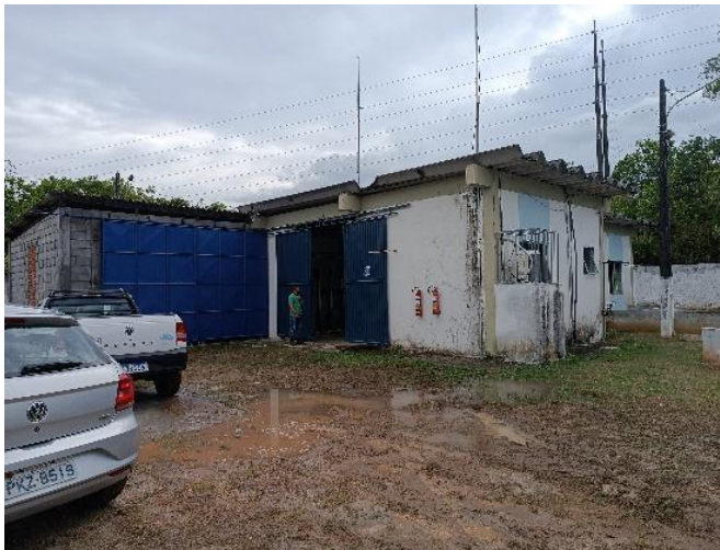
Figura 9.138 - Vista da EEAT2 e da subestação Fonte: GEOHIDRO (2024).
