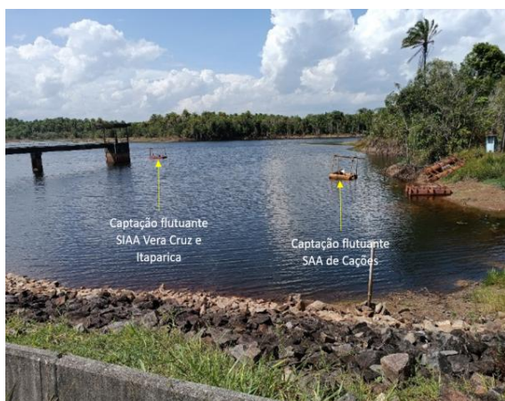
Figura 9.13 - Captações flutuantes no lago da Barragem Tapera Fonte: GEOHIDRO (2024).
