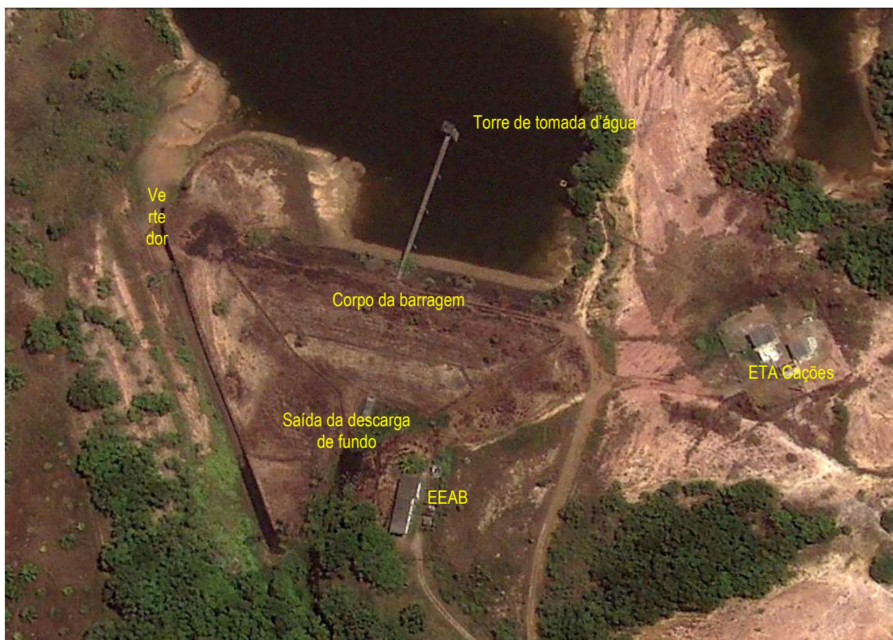
Figura 7.18 – Imagem de satélite da Barragem Tapera
