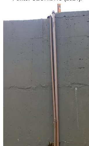
Figura 9.77 - Detalhe do sistema de dosagem no topo da torre de mistura Fonte: GEOHIDRO (2024).
