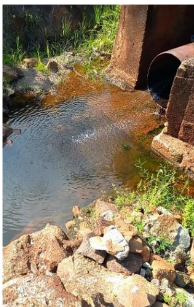
Figura 9.29 - Detalhe da saída da tubulação de descarga de fundo da barragem Tapera. Fonte: GEOHIDRO (2024).
