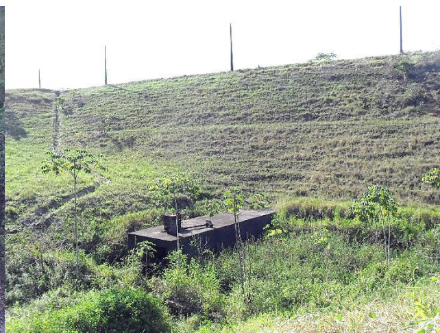
Figura 7.28 – Saída d'água da descarga de fundo e jusante do barramento
