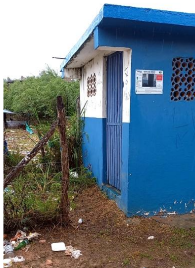
Figura 9.157 - Booster Amoreiras. Fonte: GEOHIDRO (2024).
