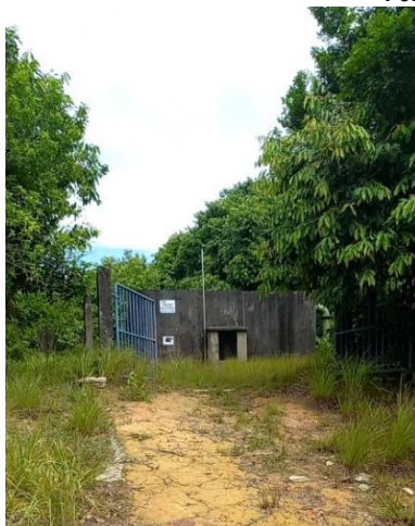
Figura 9.191 - Vista da entrada do RAD 4 Fonte: GEOHIDRO (2024).
