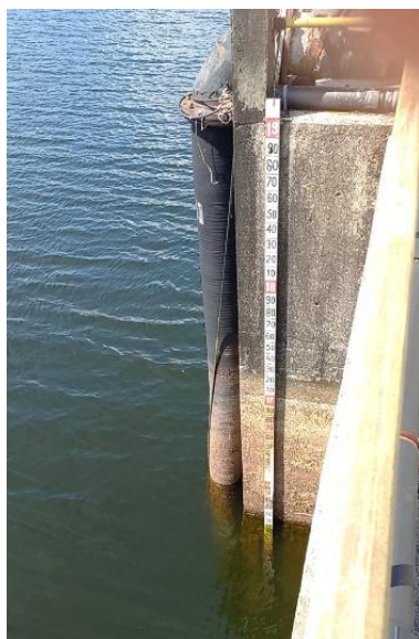
Figura 9.43 - Detalhe da curva da tubulação de captação em direção ao seu entroncamento na tubulação de tomada d'água antiga
