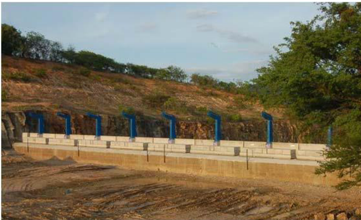
Figura 7.19 – Exemplo de fusegates na barragem do França
